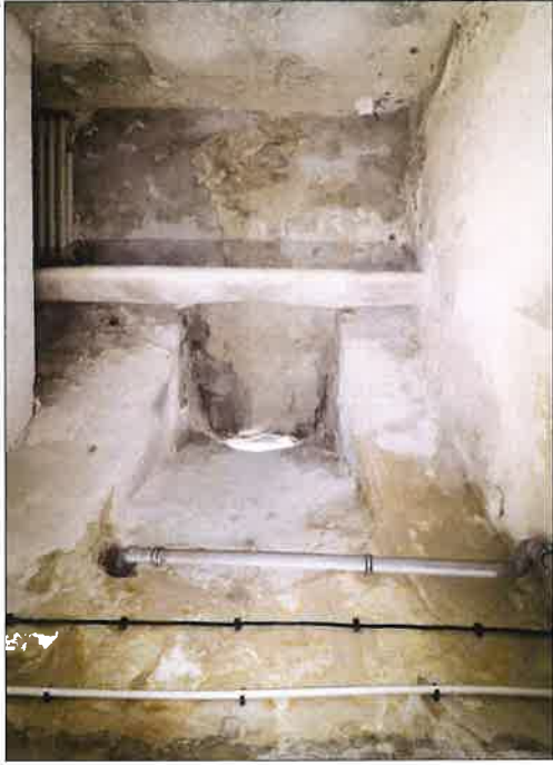
Lunety w sklepieniu nad pomieszczeniem piwnic. (fot. Jakub Andrzejewski, 2019 r.)
