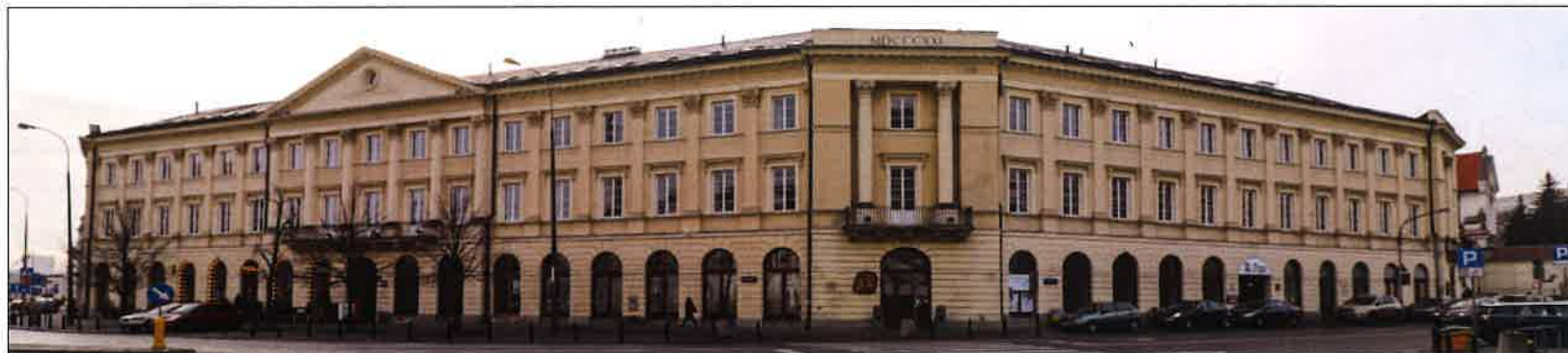
Widok budynku od strony ul. Bielańskiej (od strony północnej).
