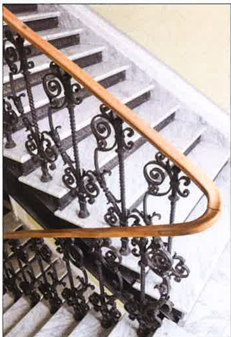
Balustrada z kutech elementów, widziana ze spocznika międzypiętrowego. (fot. Jakub Andrzejewski, 2019 r.)
