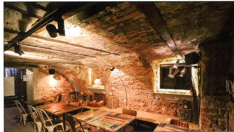
Pomieszczenie w kondygnacji piwnic, widoczne wtórnie przebudowane sklepienie które zostało połączone ze stropem kleina. (fot. Jakub Andrzejewski, 2019 r.)
