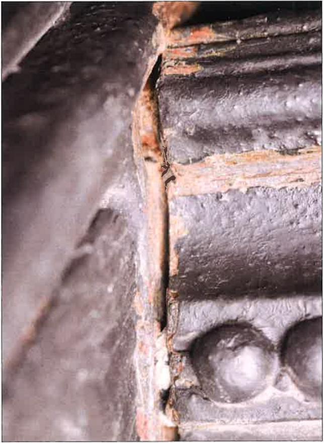
Detail połączenia żelwinych elementów stopnicy i podstopnicy oraz policzka. (fot. Jakub Andrzejewski, 2019 r.)
