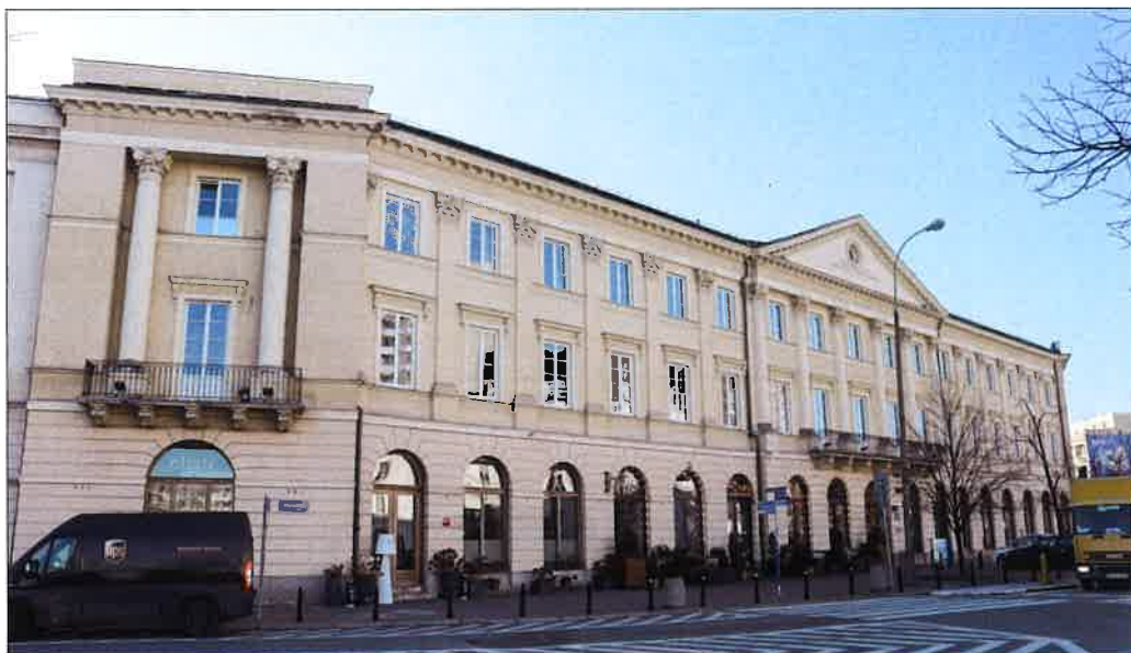
Elewacja ze skrajnym, dobudowanym przy odbudowie ryzalitem (po lewej), widok od strony północno-wschodniej (pl. Teatralnego). (fot. Jakub Andrzejewski, 2019 r.)
