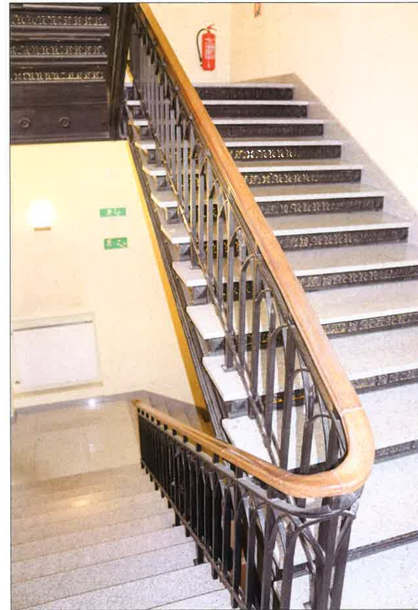
Biegi zachodniej klatki schodowej widoczne ze spocznika międzypiętrowego pomiędzy parterem i I piętrzem. (fot. Jakub Andrzejewski, 2019 r.)
