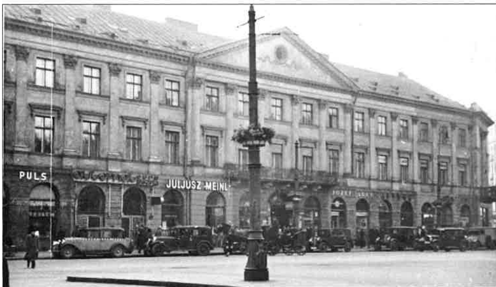
Widok elewacji od strony ul. Wierzbowej 1938 r. Referat Gabarytów (źródło: ze zbiorów Archiwum Państwowego w Warszawie źródło zdjęcia: http://warszawa.ap.gov.pl )
