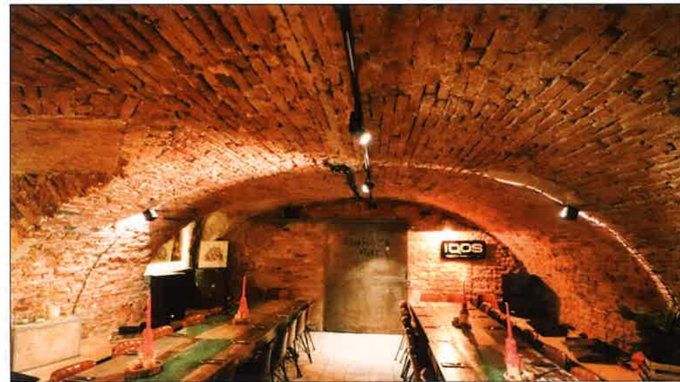
Sklepienia pomieszczenia w kondygnacji piwnic we wschodniej części budynku adaptowane na lokal gastronomiczny. (fot. Jakub Andrzejewski, 2019 r.)
