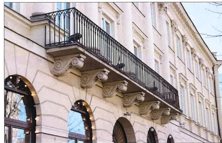
Balkon na osi ryzalitu, nad kondygnacją parteru. (fot. Jakub Andrzejewski, 2019 r.)
