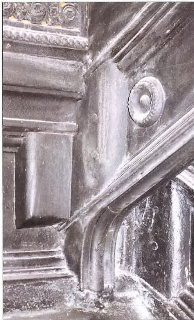
Połączenie na śruby belek pojedynczego biegu schodowego z belką spocznika międzypiętrowego, po lewej widoczne połączenie śrubowe w narożu bez maskownicy, po prawej z maskownicą. (fot. Jakub Andrzejewski, 2019 r.)
