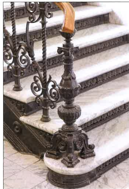
Prefabrykowany, żeliwny słupek początkowy balustrady w kondygnacji parteru. (fot. Jakub Andrzejewski, 2019 r.)
