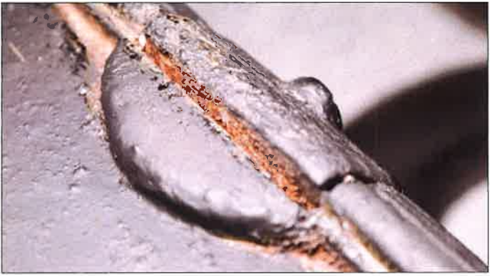
Widok od spodu srubowego połączenia elementów stopnicy i podstopnicy. (fot. Jakub Andrzejewski, 2019 r.)
