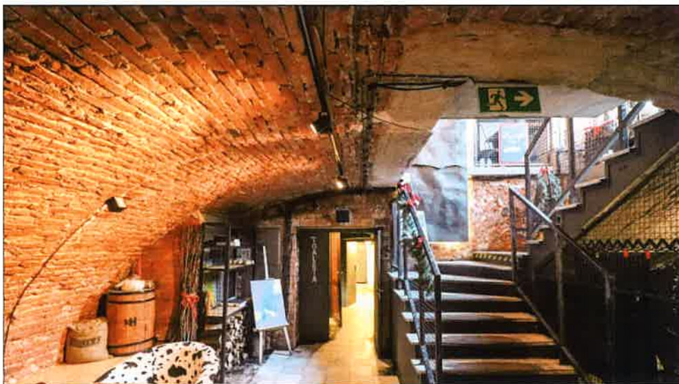
Oryginalne sklepienia pomieszczenia w kondygnacji piwnic we wschodniej części budynku, widoczne wtórnie wykonane schody. (fot. Jakub Andrzejewski, 2019 r.)
