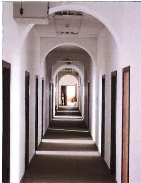
Korytarz w kondygnacji I piętra, we wschodniej części budynku, widok w kierunku zachodnim. (fot. Jakub Andrzejewski, 2019 r.)
