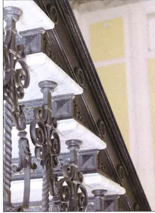
Belka wsporcza od strony duszy z widocznymi policzkami i krawędziami stopni. (fot. Jakub Andrzejewski, 2019 r.)
