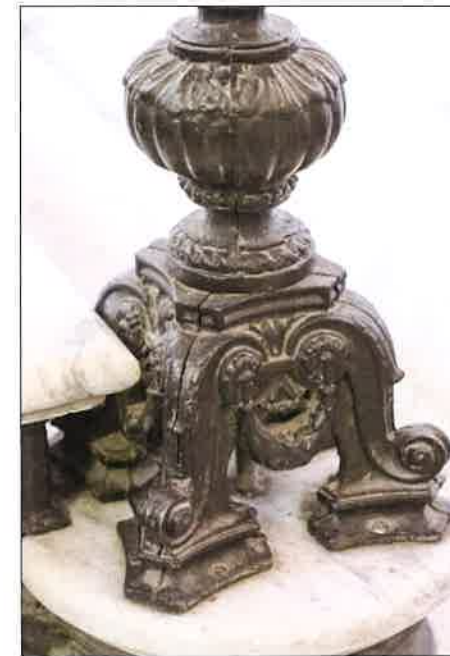
Tralka złożona z czterech, prefabrykowanych odlewanych, żeliwnych elementów. (fot. Jakub Andrzejewski, 2019 r.)
