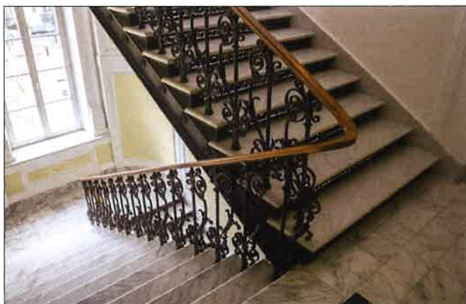
Wschodnia klatka schodowa, widok ze spocznika I piętra w kierunku zachodnim. (fot. Jakub Andrzejewski, 2019 r.)
