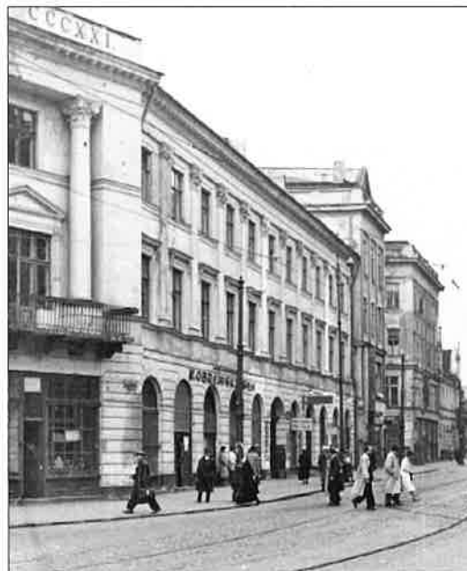
Widok elewacji od strony ul. Senatorskiej 1941 r. Referat Gabarytów (źródło: ze zbiorów Archiwum Państwowego w Warszawie źródło zdjęcia: http://warszawa.ap.gov.pl )
