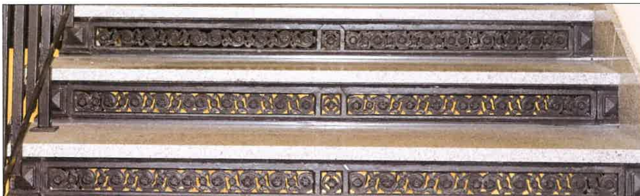
Stopnie w jednym z biegów zachodniej klatki schodowej, widoczne ażurowe wypełnienie żeliwnych elementów podstopnic oraz wtórne granitowe stopnice i balustrady. (fot. Jakub Andrzejewski, 2019 r.)
