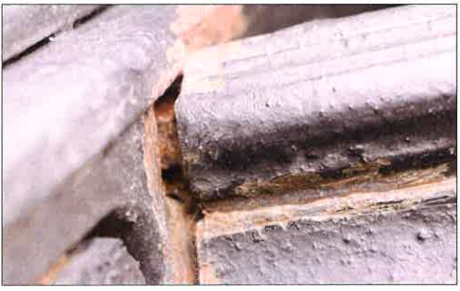
Detail połączenia stopnicy z policzkiem i belką biegu schodowego. (fot. Jakub Andrzejewski, 2019 r.)
