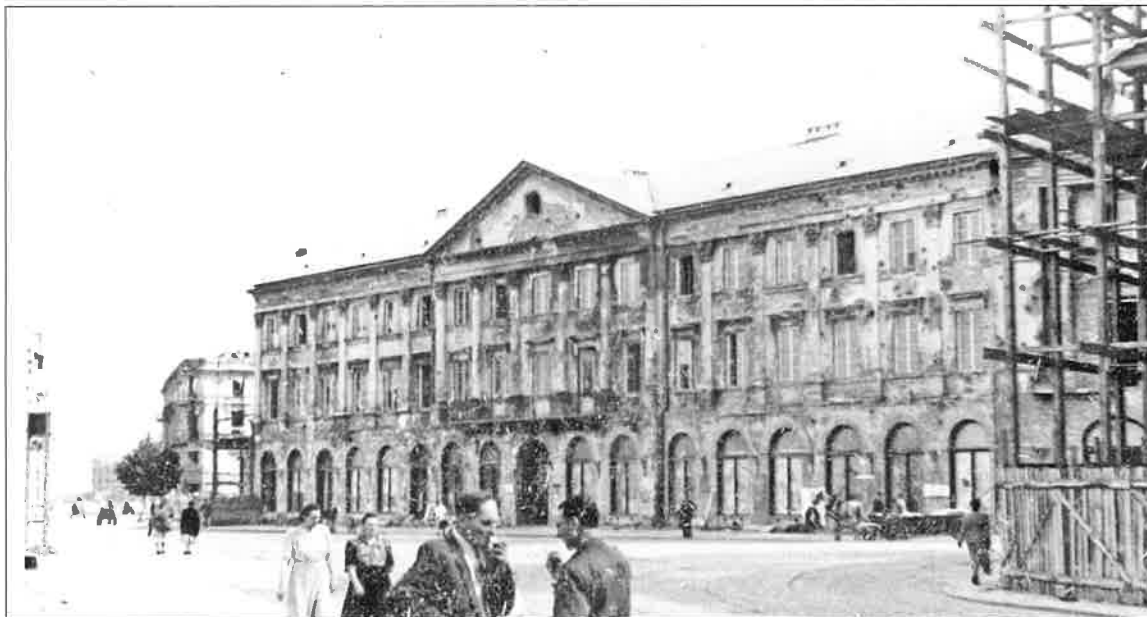
Kamienica po odbudowie, widok od strony ul. Bielańskiej, fotografia wykonana w pierwszej połowie 1950 r., widoczna nieotynkowana elewacja frontowa ze śladami postrzelin (źródło: skan zdjęcia z Archiwum M. St. Warszawy).
