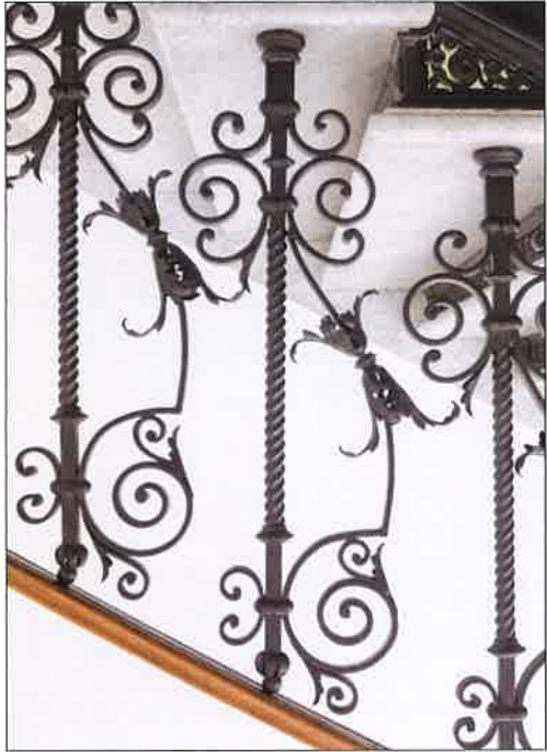
Wykonane w latach 90. XX w. wtórne biegi klatki schodowej pomiędzy kondygnacją II i III piętra, widoczne wykonane na wzór oryginalnych żeliwne elementy konstrukcyjne schodów. (fot. Jakub Andrzejewski, 2019 r.)
