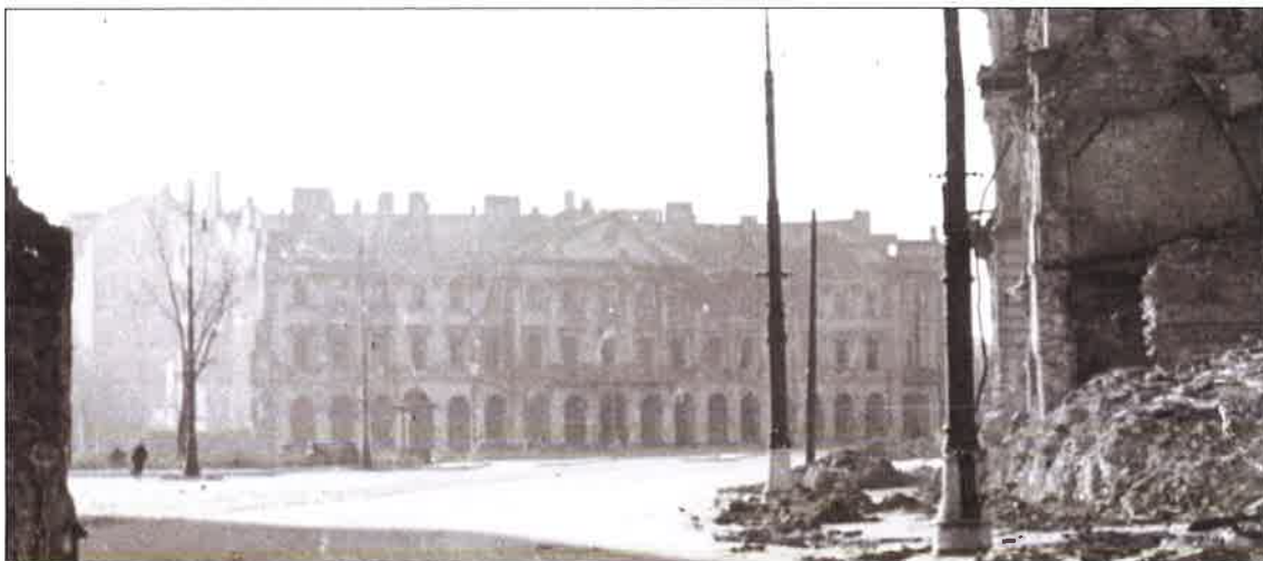
Wypalona kamienica Petiscusa po zakończeniu Powstania Warszawskiego, widok z północno-wschodniego naroża placu Teatralnego, zdjęcie wykonane najprawdopodobniej w listopadzie 1944 r. (źródło: http://stanislawjankowskiagaton.pl )
