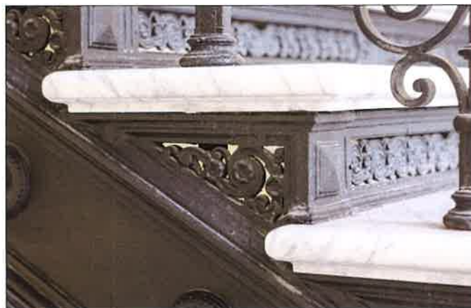
Widok krawędzi i policzka pojedynczego stopnia z wtórną, kamienną stopnicą. (fot. Jakub Andrzejewski, 2019 r.)
