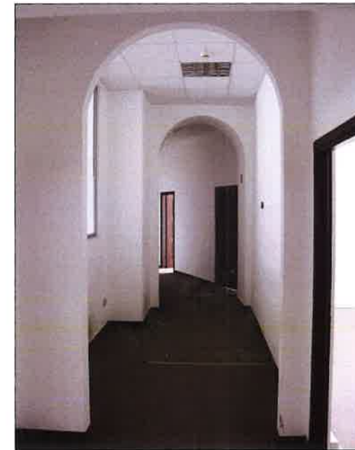
Korytarz w kondygnacji I piętra, na styku zachodniej i wschodniej części budynku. (fot. Jakub Andrzejewski, 2019 r.)
