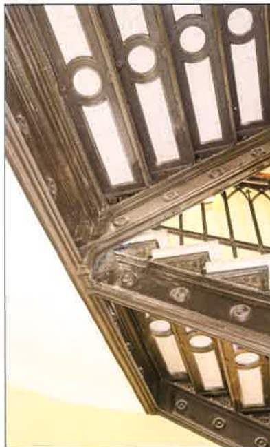
Żeliwna belka podtrzymująca spocznik I pietra oraz biegi klatki schodowej. (fot. Jakub Andrzejewski, 2019 r.)
