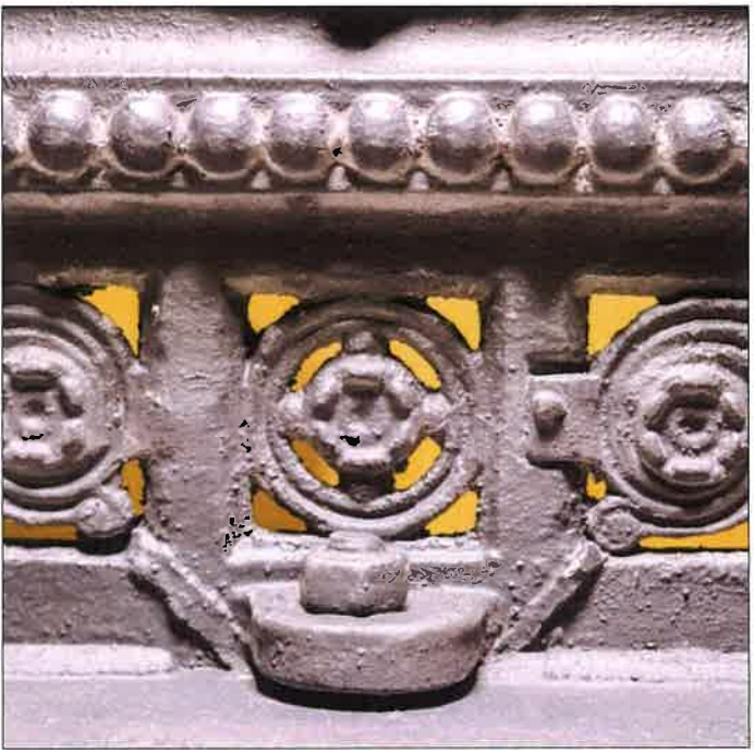
Zeliny elementy ozdoby wypielające podstopnicę i srubowe połączenie z elementem stopnicy. (fot. Jakub Andrzejewski, 2019 r.)
