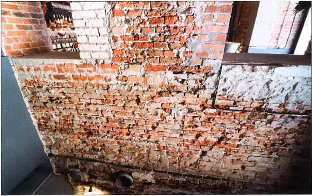
Wnętrze jednego z pomieszczeń w parterze budynku po stronie wschodniej, pod skutym pokryciem tynkarskim widoczne liczne ślady przebudowy. (fot. Jakub Andrzejewski, 2019 r.)
