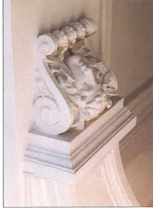
Konsola wspierająca łuk nad wejściem do klatki w kondygnacji parteru. (fot. Jakub Andrzejewski, 2019 r.)
