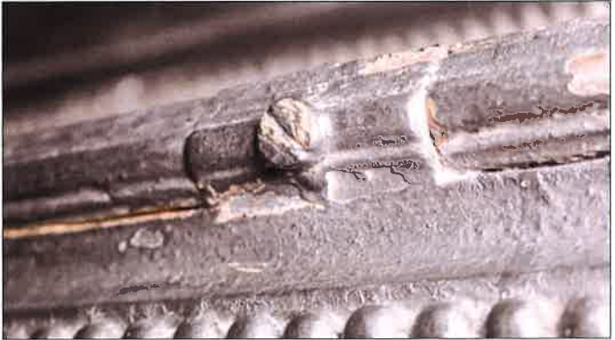
Detail srubowego połączenia żelwinych elementów stopnicy i podstopnicy. (fot. Jakub Andrzejewski, 2019 r.)
