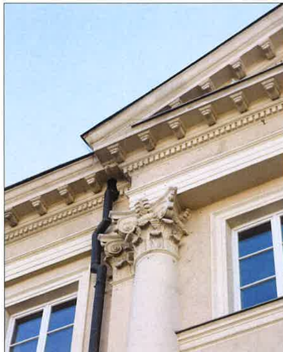
Fragment ryzalitu, widoczne pilastry z głowicą kompozytową oraz gzyms wieńczący elewację. (fot. Jakub Andrzejewski, 2019 r.)
