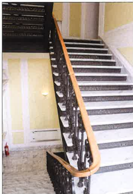
Wschodnia klatka schodowa, widok ze spocznika międzypiętrowego. (fot. Jakub Andrzejewski, 2019 r.)
