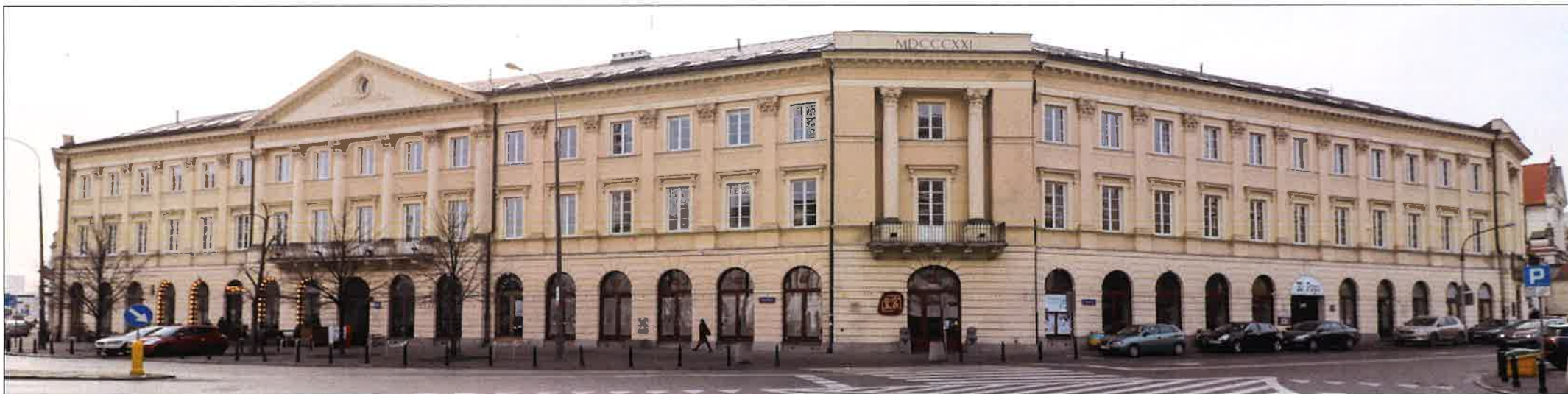
Środkowy ryzalit kamienicy w elewacji od strony ul. Senatorskiej i pl. Teatralnego, widok od strony ulicy Bielańskiej. (fot. Jakub Andrzejewski, 2019 r.)
