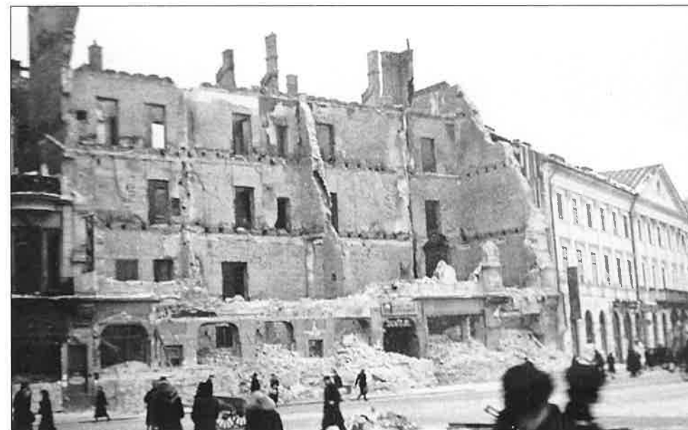
Listopad 1939 r., widok zawalanej elewacji frontowej kamienicy Dmuszewskiego, po prawej stronie widoczna kamienica Petiscusa (źródło: http://fotopolska.eu ).
