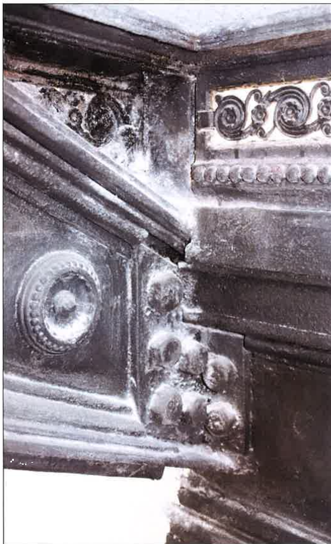
Połączenie na śruby belek pojedynczego biegu schodowego z belką spocznika międzypiętrowego, po lewej widoczne połączenie śrubowe w narożu bez maskownicy, po prawej z maskownicą. (fot. Jakub Andrzejewski, 2019 r.)
