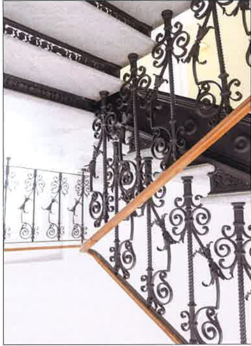
Wykonane w latach 90. XX w. wtórne biegi klatki schodowej pomiędzy kondygnacją II i III piętra, widoczne wykonane na wzór oryginalnych żeliwne elementy konstrukcyjne schodów. (fot. Jakub Andrzejewski, 2019 r.)
