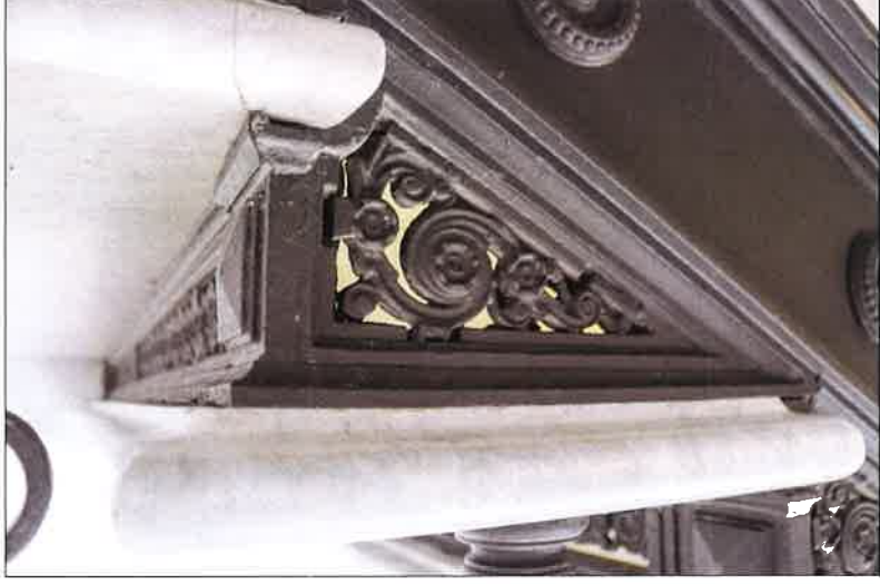
Wykonane w latach 90. XX w. wtórne biegi klatki schodowej pomiędzy kondygnacją II i III piętra, widoczne wykonane na wzór oryginalnych żeliwne elementy konstrukcyjne schodów. (fot. Jakub Andrzejewski, 2019 r.)
