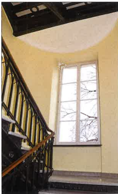
Spocznik międzypietrowy w zachodniej klatce schodowej. (fot. Jakub Andrzejewski, 2019 r.)
