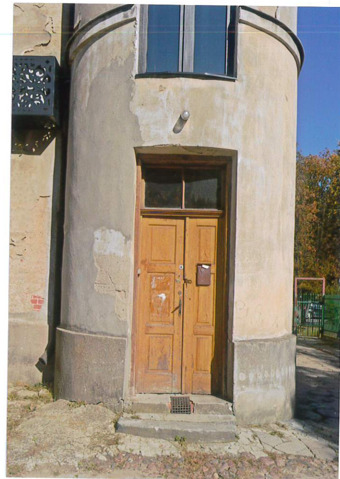
Fot. 5. Elewacja od podwórza – aneks z klatki schodowej.
