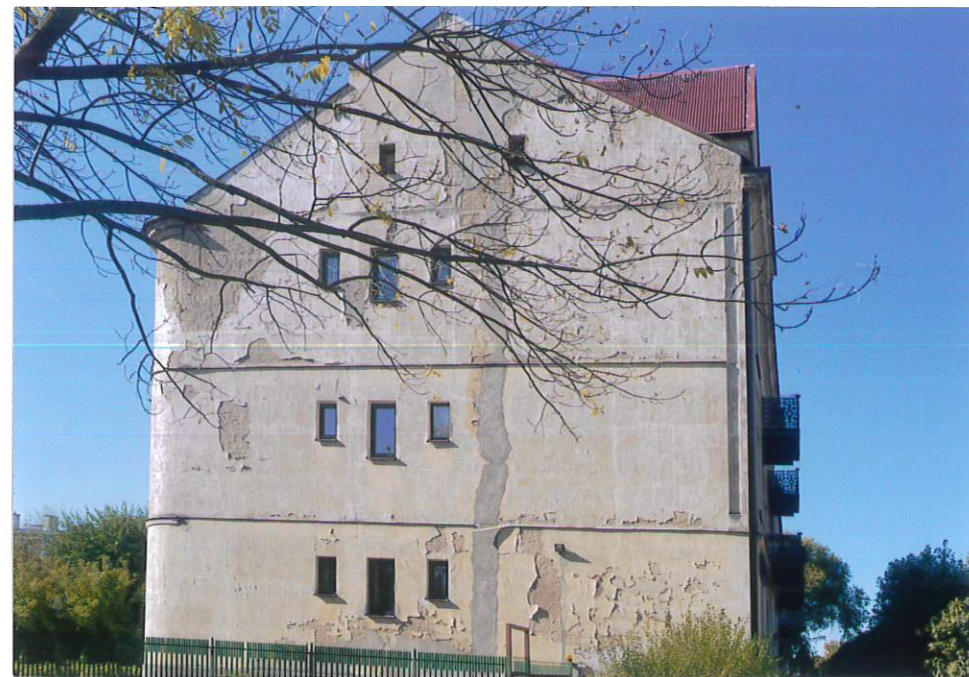
Fot. 7. Ściana szczytowa.
