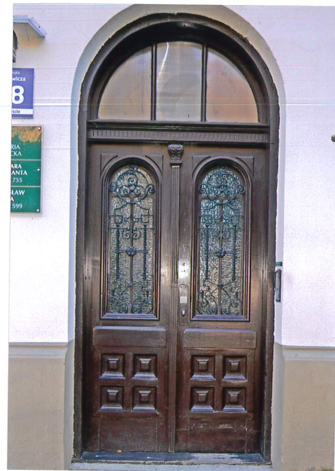
Fot. 2. Drzwi frontowe.
