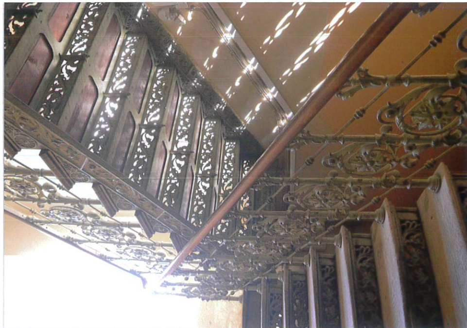
Fot. 14. Schody główne.
