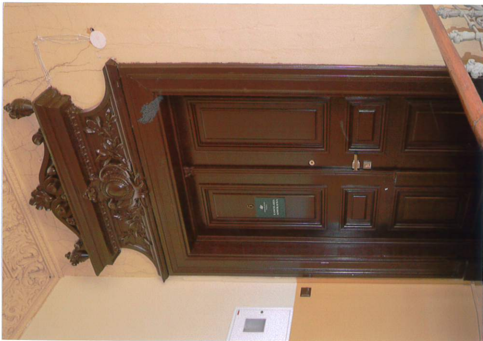
Fot. 15. Główna klatka schodowa - drzwi do lokali.
