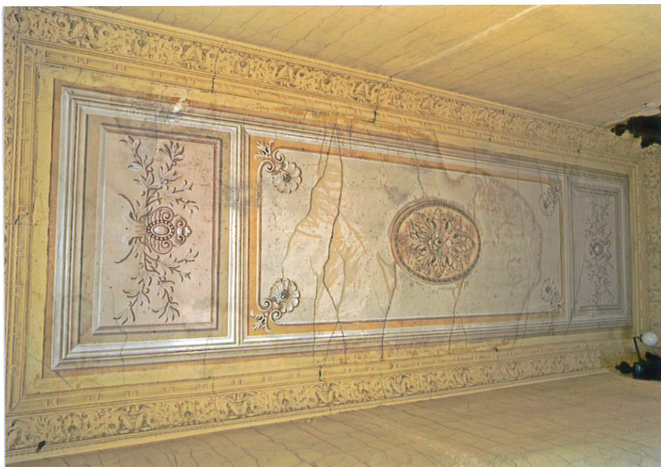
Fot. 16. Główna klatka schodowa – polichromia sufitu.
