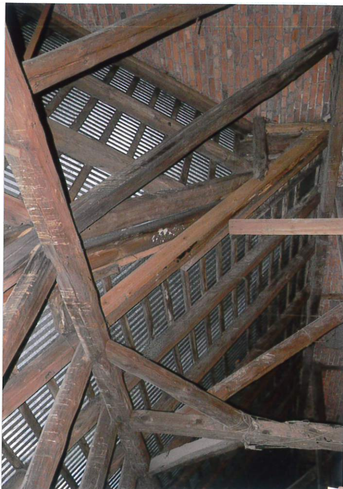
Fot. 17. Więżba dachowa.
