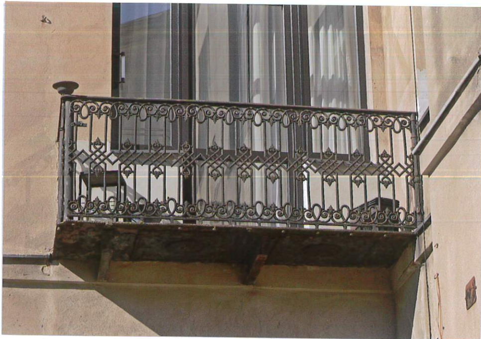
Fot. 6. Elewacja od podwórza (południowa) – balkon.
