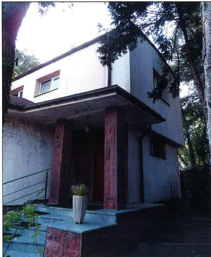
IL.59. Podcień wejścia głównego do budynku
