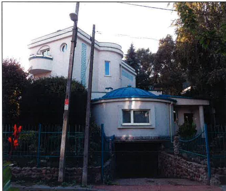
IL. 22. Widok domu 2.kopułowego ze zjazdem do garażu od ul. Ustrzyckiej i dobudowanego 3.kondygnacyjowego skrzydła od strony północnej
