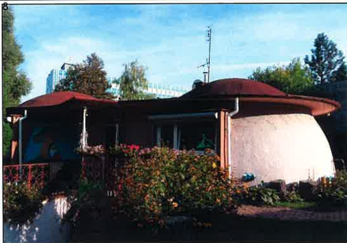
Widok budynku ul. 1 Sierpnia 25 – od strony ul. Ustrzyckiej
