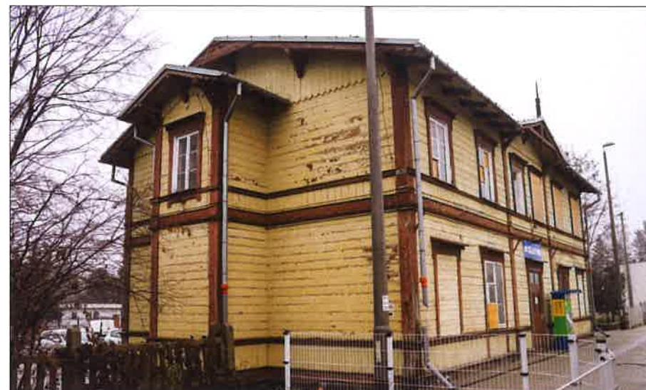
Elewacje północno-zachodnia oraz południowo-zachodnia widoczne od strony peronu. (fot. Jakub Andrzejewski, 2021 r.)
