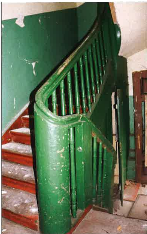
Drewniana balustrada klatki schodowej w północno-zachodniej części budynku, widok z parteru. (fot. Jakub Andrzejewski, 2021 r.)
