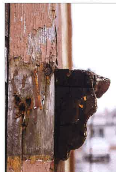
Detale gzymśców oraz części cokołowej wykonane z profilowanych listew i desek. (fot. Jakub Andrzejewski, 2021 r.)
