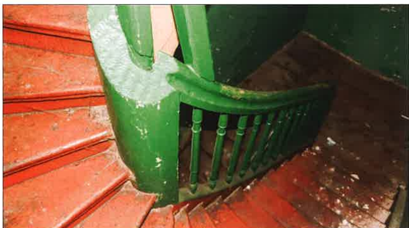
Widok biegu klatki schodowej pomiędzy piętrami. (fot. Jakub Andrzejewski, 2021 r.)
