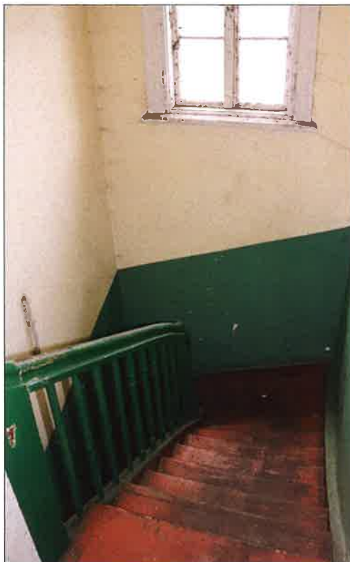
Górny bieg klatki schodowej w północno-zachodniej części budynku, widok z I piętra. (fot. Jakub Andrzejewski, 2021 r.)
