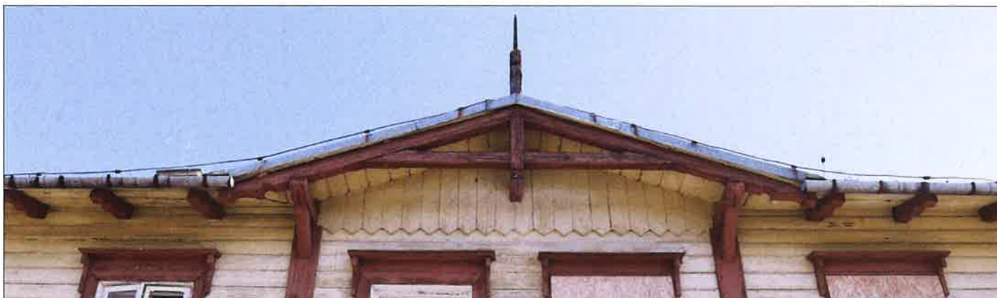
Szczyt elewacji południowo-zachodniej widocznej od strony peronu z widocznymi elementami konstrukcji wsporczej dachu. (fot. Jakub Andrzejewski, 2021 r.)
