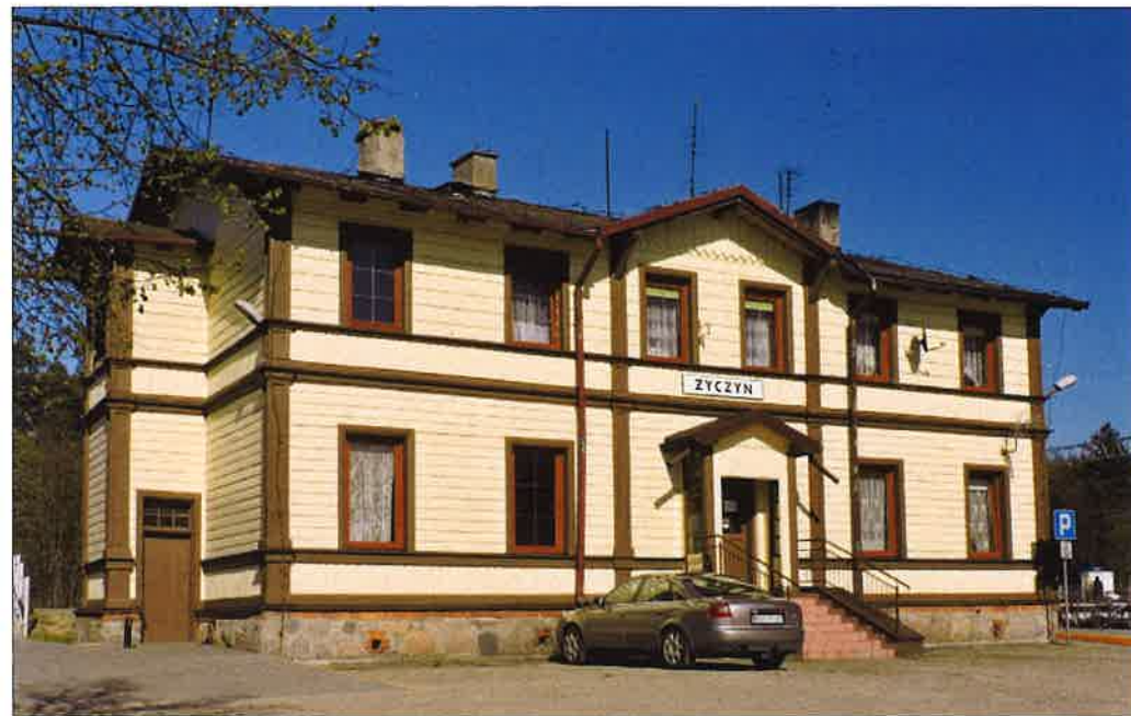
Budynek dworca na stacji kolejowej Życzyn wybudowany tak jak budynek dworca w Celestynowie w połowie lat 80. XIX w. (fot. Rafał Terkner, 2021 r., źródło: http://fotopolska.eu )
