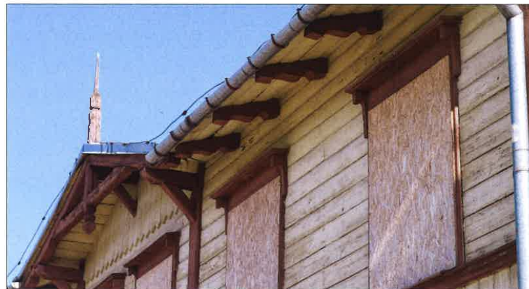
Szczyt elewacji południowo-zachodniej widocznej od strony peronu z widocznymi elementami konstrukcyjnymi dachu. (fot. Jakub Andrzejewski, 2021 r.)
