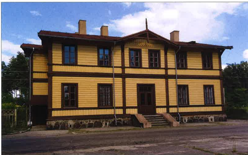
Budynek dworca na stacji kolejowej Gołęb wybudowany tak jak budynek dworca w Celestynowie w połowie lat 80. XIX w. (fot. Darek Pawlak, 2020 r., źródło: http://fotopolska.eu )
