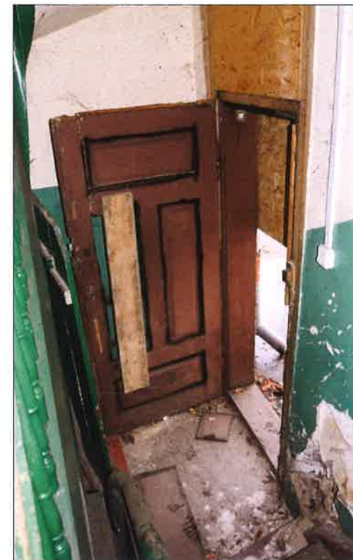
Drzwi wejściowe do klatki schodowej w północno-zachodniej części budynku. (fot. Jakub Andrzejewski, 2021 r.)
