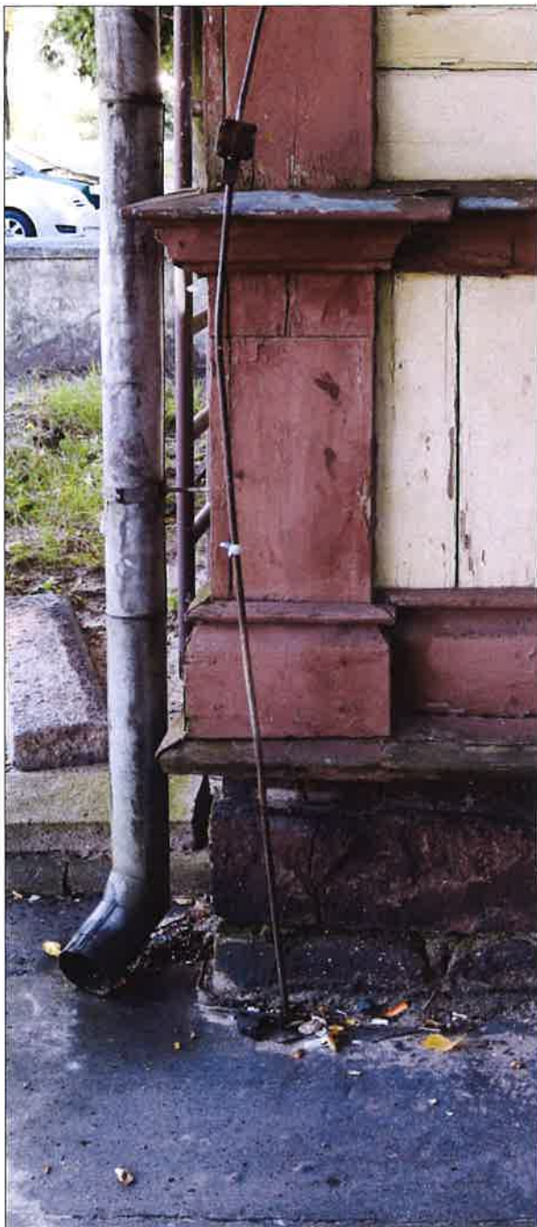
Widok północnego naroża budynku w przyziemiu. (fot. Jakub Andrzejewski, 2021 r.)
