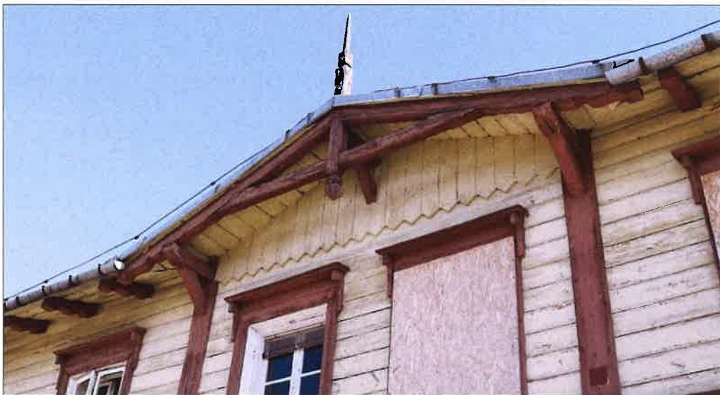
Szczyt elewacji południowo-zachodniej widocznej od strony peronu. (fot. Jakub Andrzejewski, 2021 r.)
