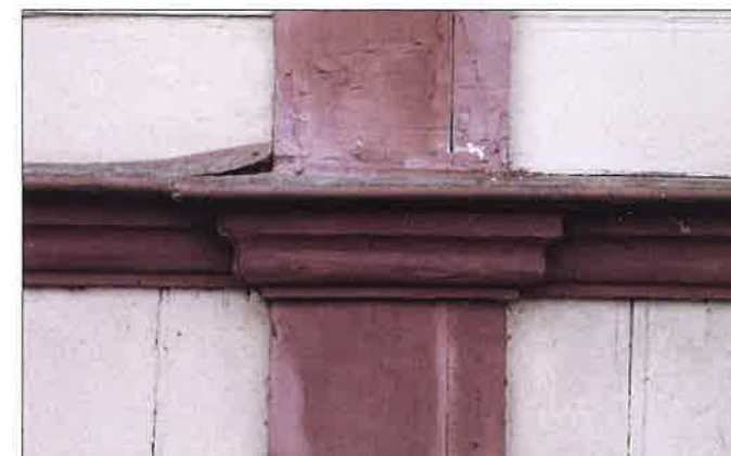
Pilaster z profilowanym gzymsem w części cokołowej elewacji. (fot. Jakub Andrzejewski, 2021 r.)
