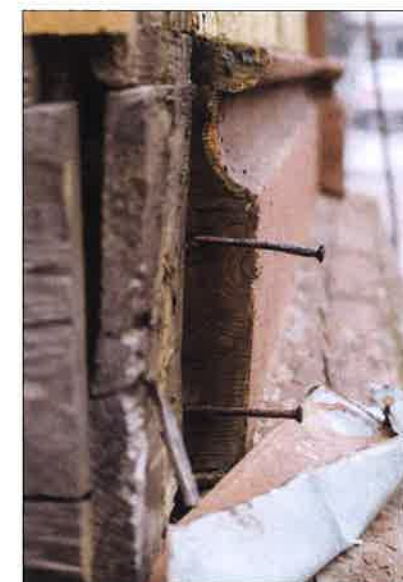
Detale gzymśców oraz części cokołowej wykonane z profilowanych listew i desek. (fot. Jakub Andrzejewski, 2021 r.)
