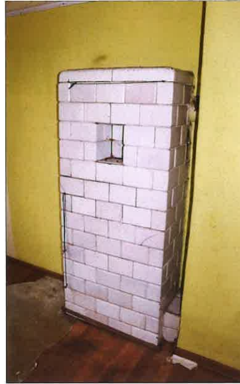
Zachowane piece kaflowe w pomieszczeniu na parterze (po lewej i na dole) oraz w pomieszczeniach I piętra (środkowe i po prawej). (fot. Jakub Andrzejewski, 2021 r.)
