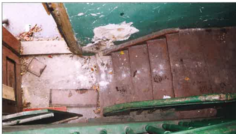
Początkowy bieg przy wejściu do klatki schodowej w północno-zachodniej części budynku. (fot. Jakub Andrzejewski, 2021 r.)
