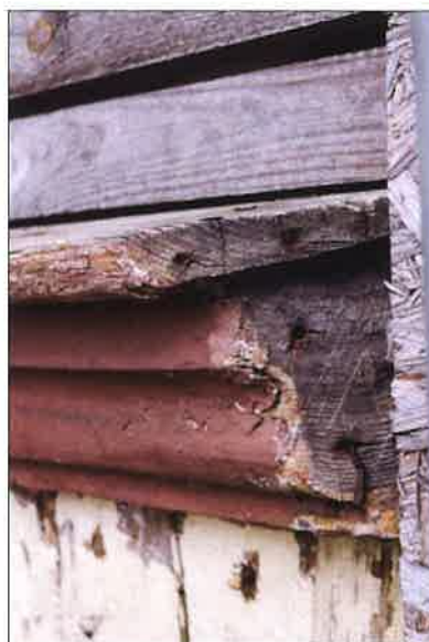
Detale gzymśców oraz części cokołowej wykonane z profilowanych listew i desek. (fot. Jakub Andrzejewski, 2021 r.)
