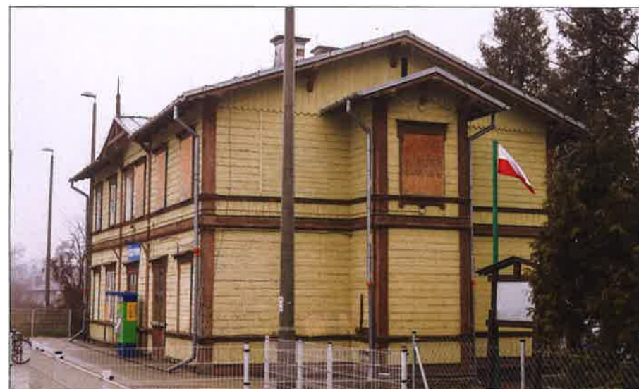
Elewacje południowo-wschodnia z ryzalitem mieszczącym klatkę schodową widoczna od strony peronu. (fot. Jakub Andrzejewski, 2021 r.)
