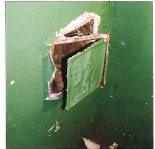
Drzwiczki wyczystek kominowych w pomieszczeniach parteru i I piętra (powyżej). (fot. Jakub Andrzejewski, 2021 r.)
