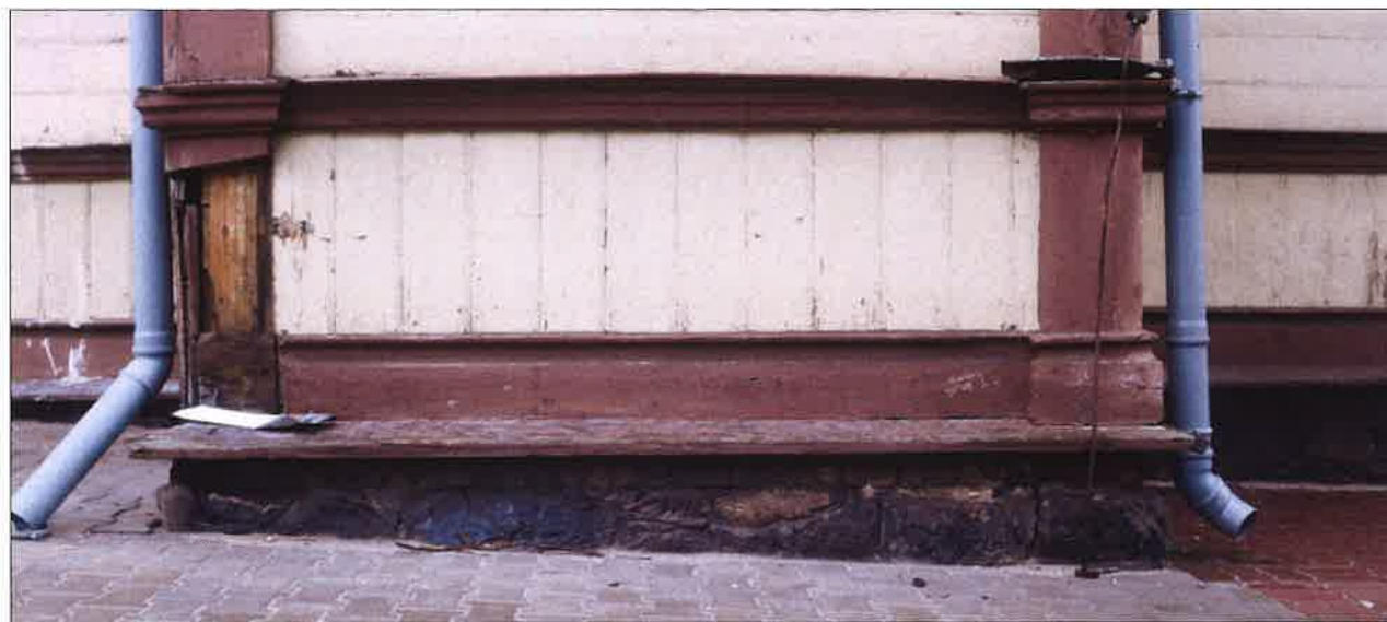
Widok przyziemia ryzalitu klatki schodowej w południowo-wschodniej części budynku. (fot. Jakub Andrzejewski, 2021 r.)
