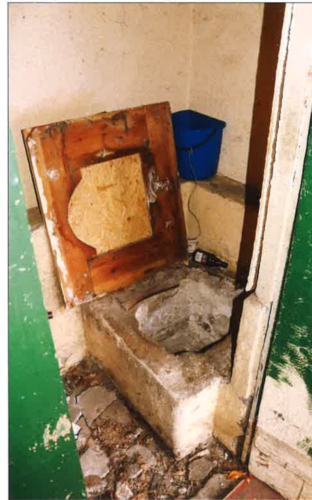
Wtórnie wykonany ustęp zlokalizowany pod biegiem w klatce schodowej w północno-zachodniej części budynku. (fot. Jakub Andrzejewski, 2021 r.)
