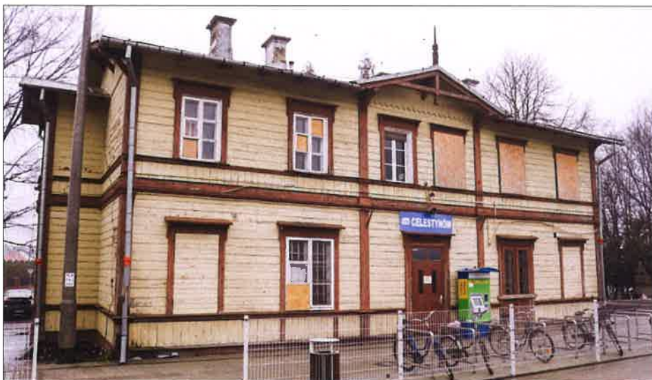
Elewacja południowo-zachodnia widoczna od strony peronu. (fot. Jakub Andrzejewski, 2021 r.)
