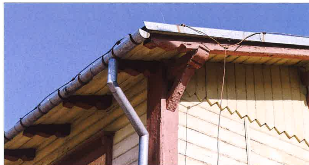
Naroże południowe budynku z widocznym szczytem z elementami konstrukcyjnymi dachu, krokwiami oraz płatwiami ze wspornikami. (fot. Jakub Andrzejewski, 2021 r.)
