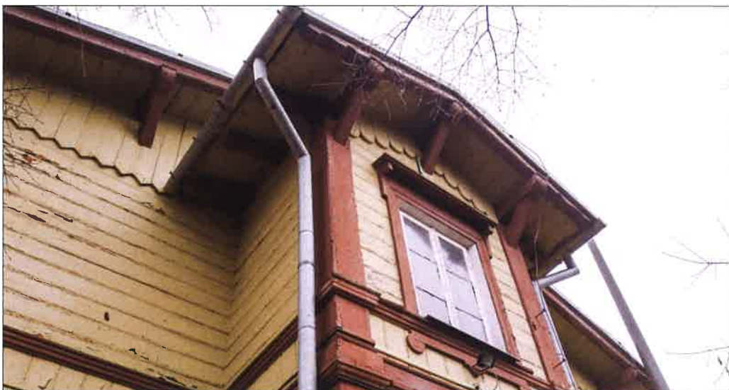
Szczyt ryzalitu w elewacji północno-zachodniej z widocznymi elementami konstrukcyjnymi dachu, krokwiami oraz płatwiami ze wspornikami. (fot. Jakub Andrzejewski, 2021 r.)
