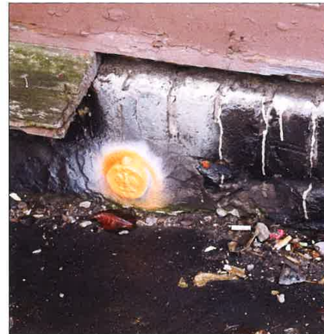
Reper w ścianie fundamentowej po północno zachodniej stronie budynku, najprawdopodobniej pochodzący z lat 20. lub 30. XX w. (fot. Jakub Andrzejewski, 2021 r.)
