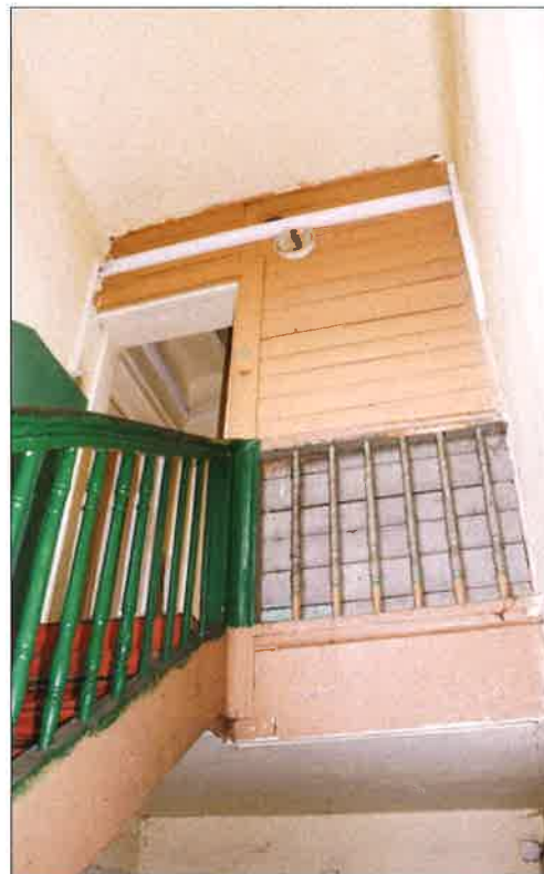
Drewniana balustrada klatki schodowej, widok w kierunku kondygnacji I piętra. (fot. Jakub Andrzejewski, 2021 r.)
