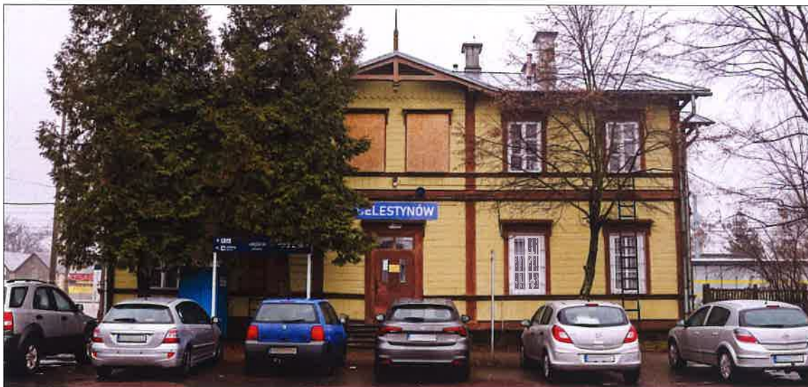
Elewacja północno-wschodnia, widoczna od strony podjazdu i ul. Kolejowej. (fot. Jakub Andrzejewski, 2021 r.)
