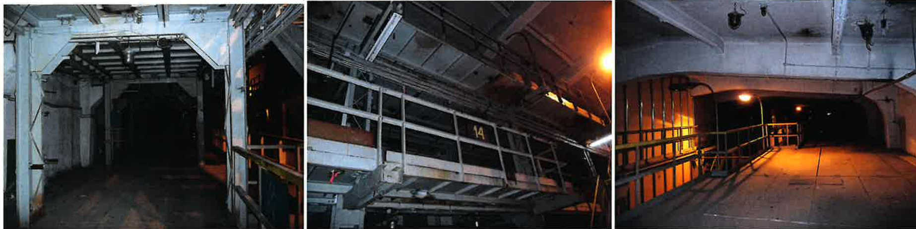
IL. 60, 61. Widoki wnętrza hali technologicznej (6C) wtórnie podzielonej stalowymi pomostami. IL. 62. Widok z pomostu stalowego na konstrukcję stropu i ścianę dobudówki.
