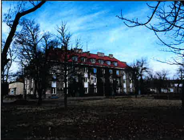
Widok frontowy od strony wewnętrznej ulicy dojazdowej
