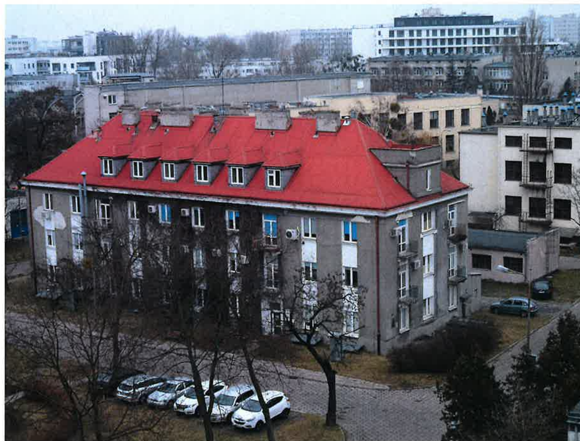
IL. 10. Widok ogólny z budynku biurowego (nr 24).
