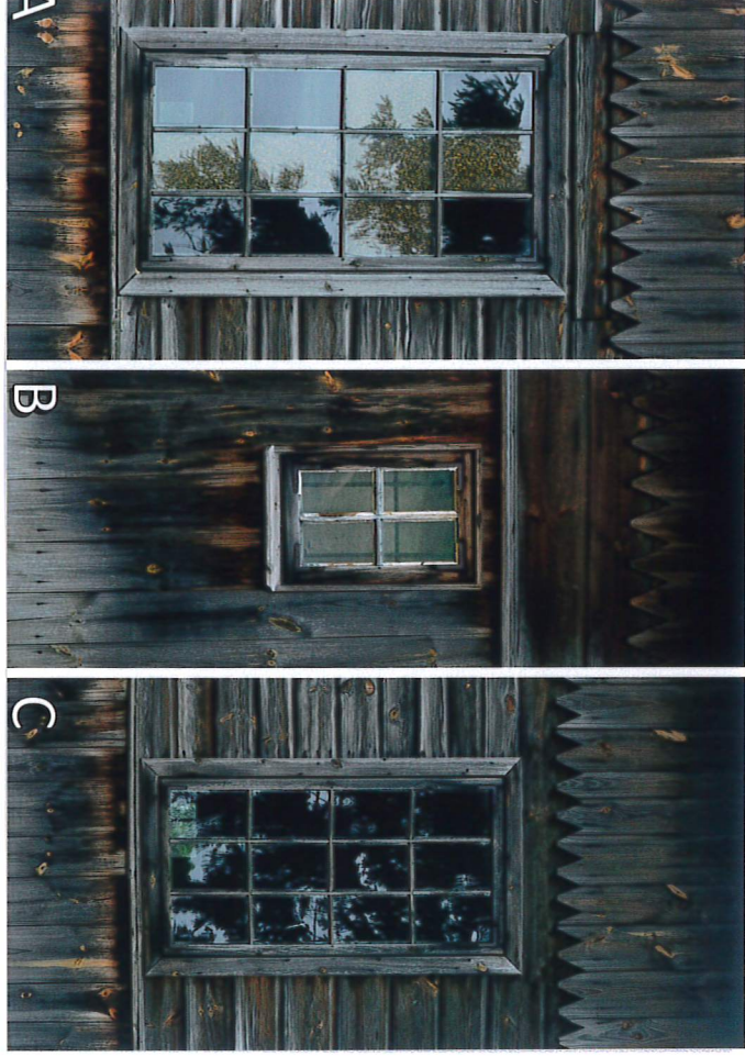
Fot. 6. Okna na elewacji zachodniej (A, C) oraz na ścianie południowej zachodniego aneksu, 2019.
