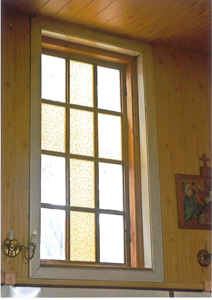
Fot. 8. Okno – widok od wewnątrz, 2019.
