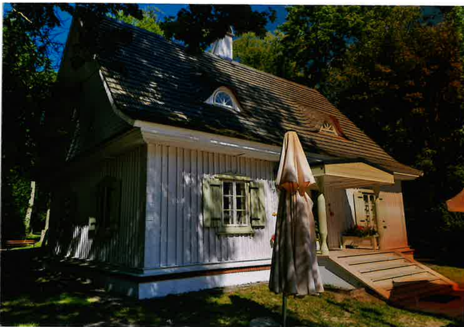
Fot. 1. Elewacja frontowa.
