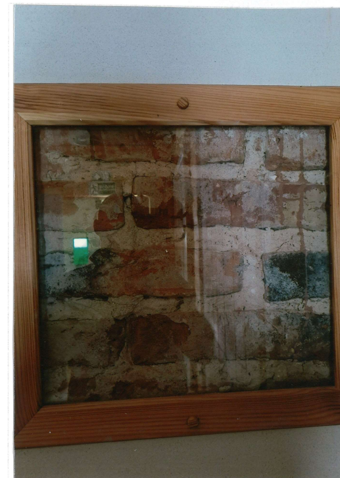
Fot. 8. Świadek zachowanej konstrukcji.
