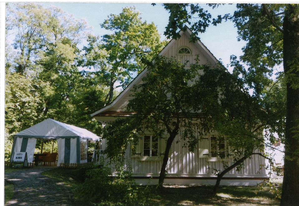
Fot. 5. Elewacja zachodnia.
