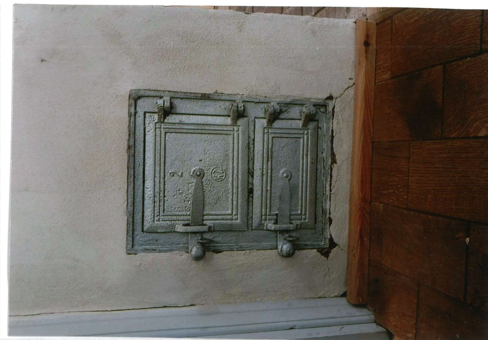
Fot. 10. Drzwiczki żeliwne (piec/komin) w korytarzu.
