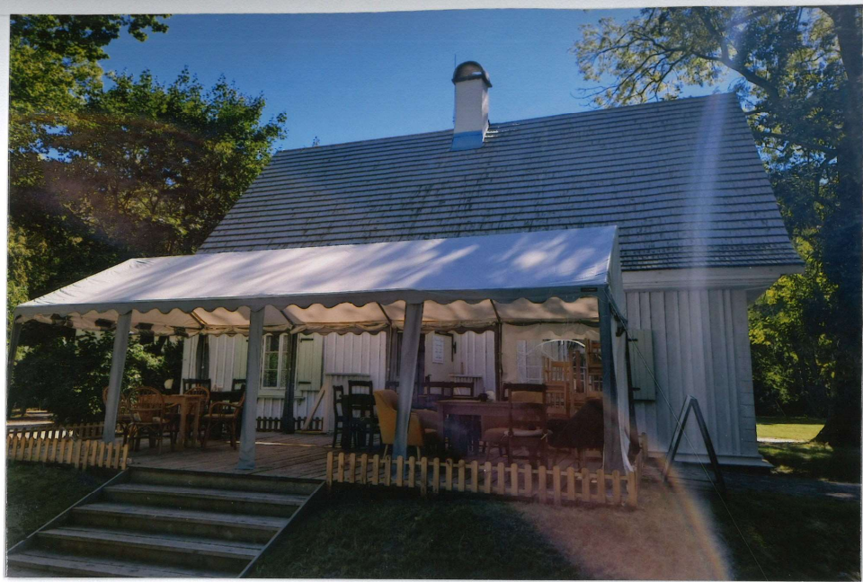
Fot. 2. Elewacja tylna.
