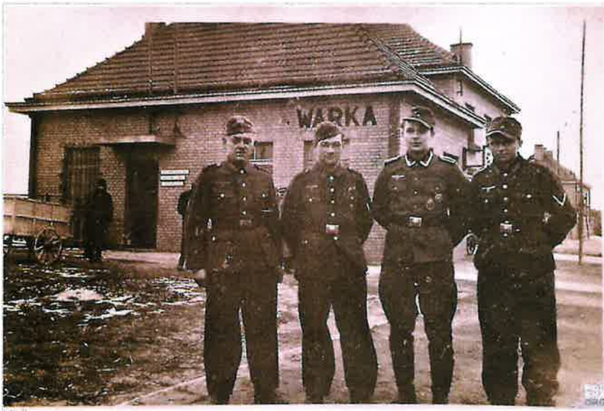
Fot. 2 Budynek dworca w czasie okupacji 1940 r.
