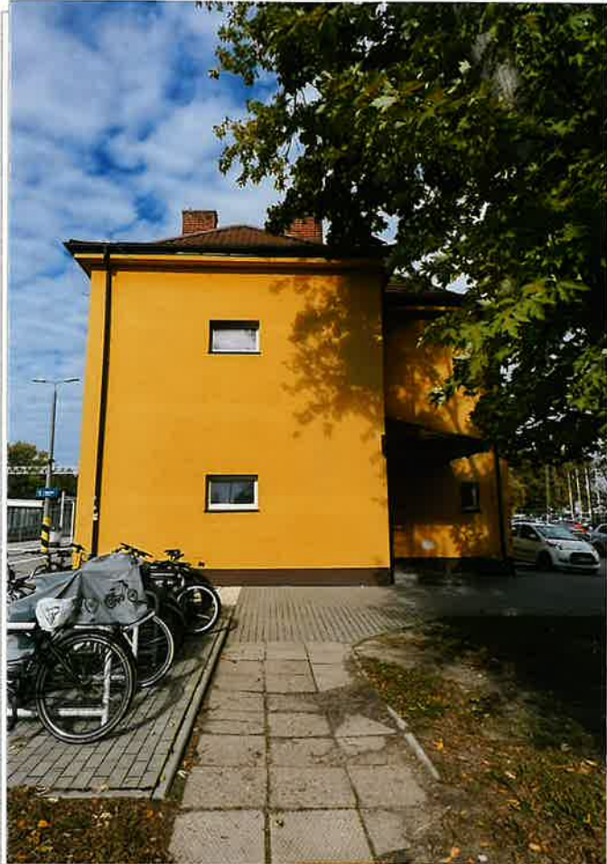
Fot. 3. Elewacja zachodnia
