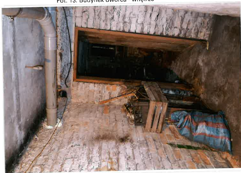
Fot. 14. Wnętrze piwnic
