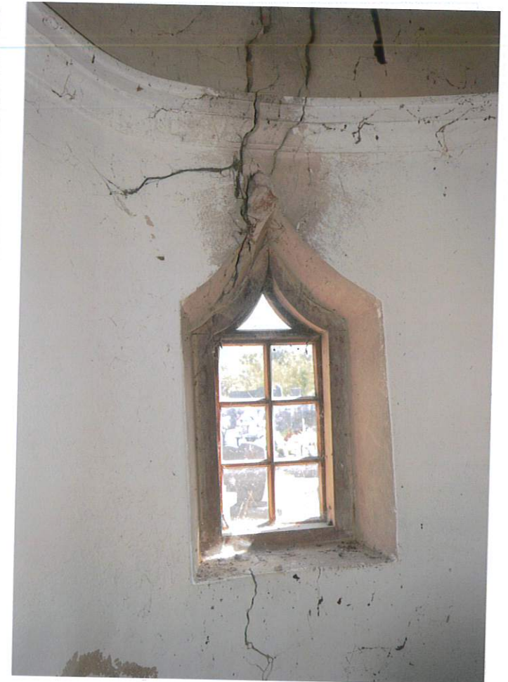
Fot. 9. Okno północne absydy, 2022.
