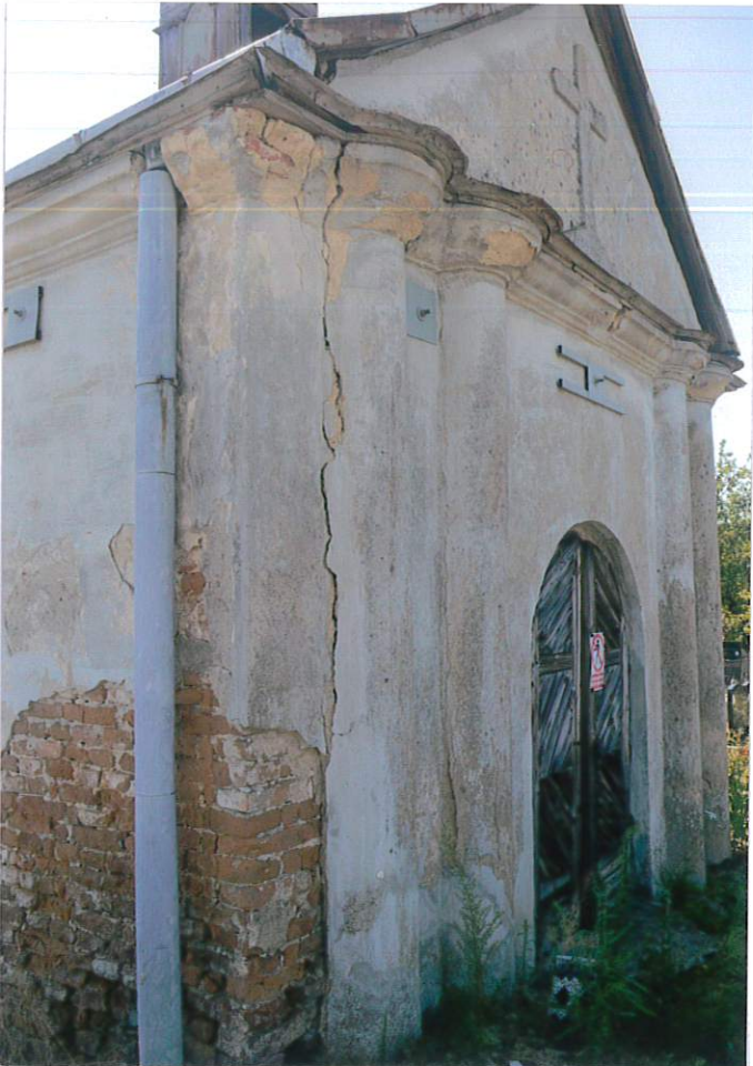
Fot. 4. Elewacja zachodnia – widok na północny narożnik, 2022.
