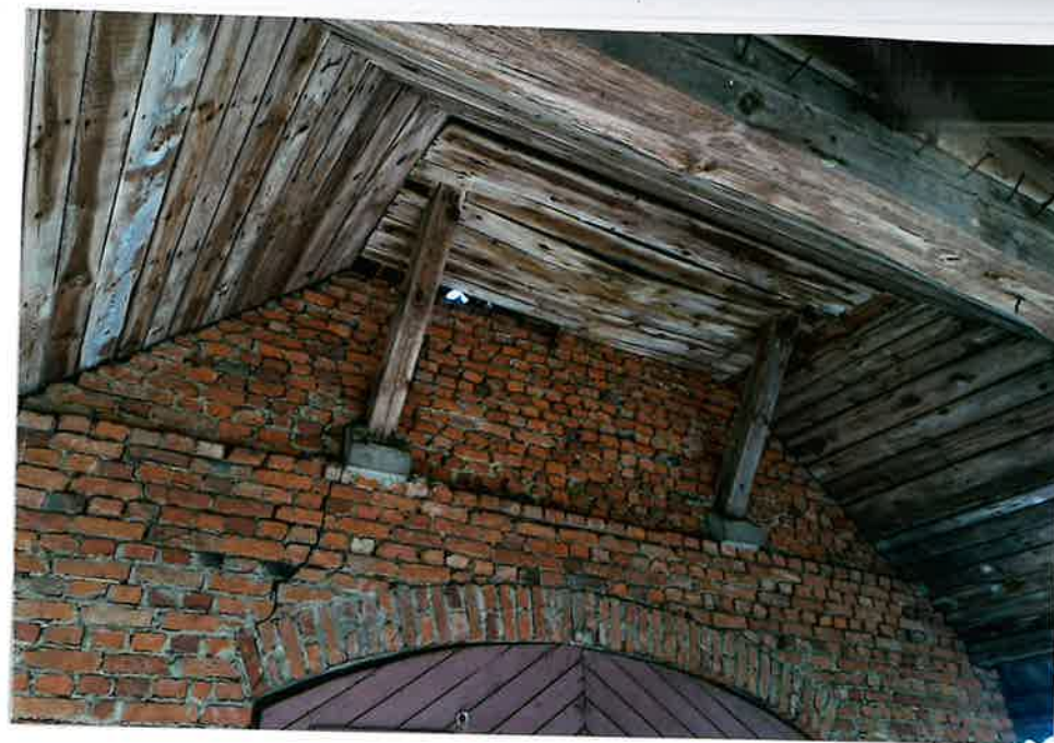
Fot. 5. Ściana północna, podparcie okapu nad wejściem (powyżej).
