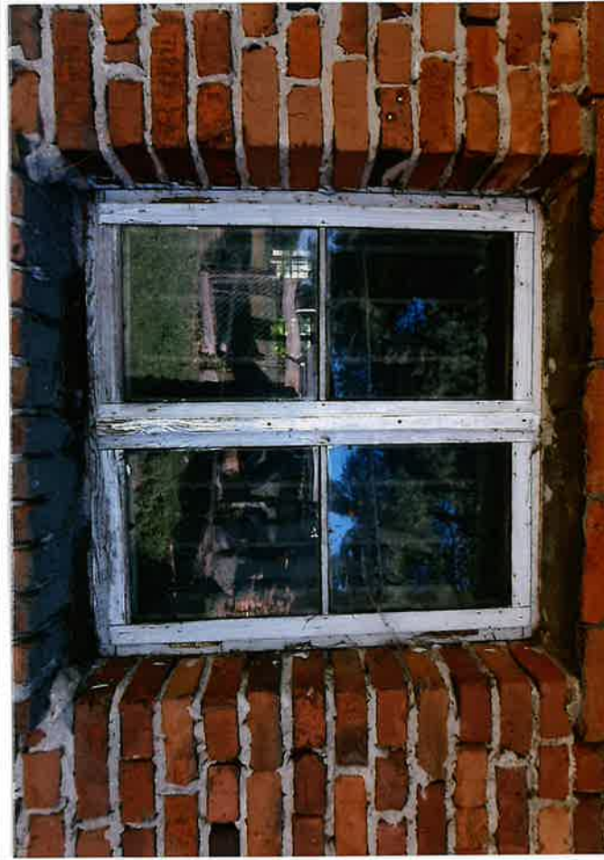
Fot. 7. Okno, widok od zewnątrz.
