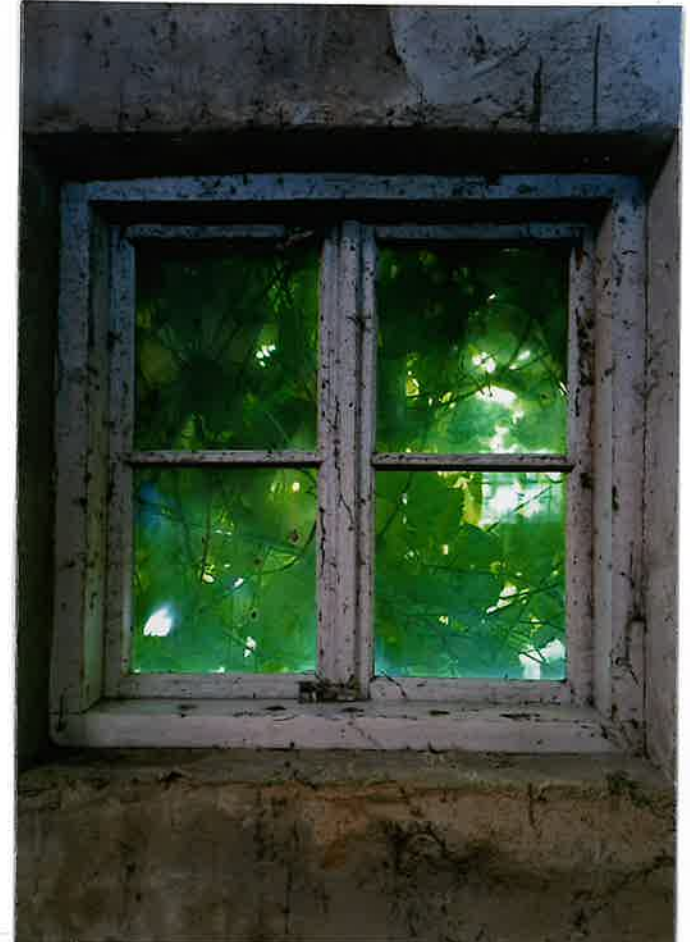
Fot. 8. Okno, widok od wewnątrz.
