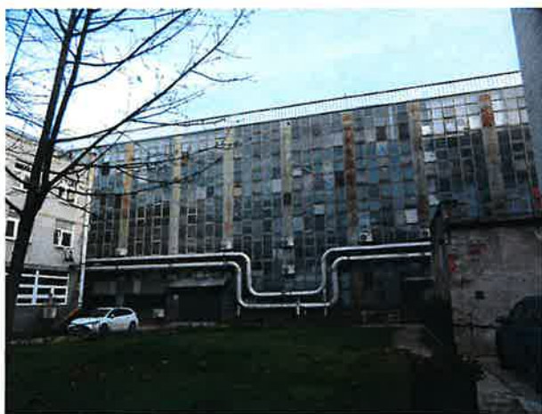
IL. 44. Elewacja tylna: zachodnia.
