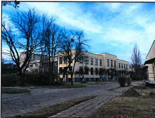
Widok frontowy od strony wewnętrznej ulicy dojazdowej
