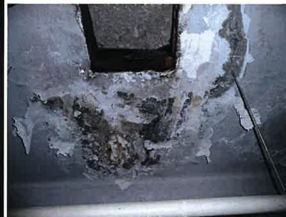
IL. 68, 69. Górne partie hali. IL. 70. Fragment klinkierowej nawierzchni przyziemia. IL. 71, 72. Drewniane i stalowe wrota. IL. 73. Zniszczenia płyty żelbetowej stropu.
