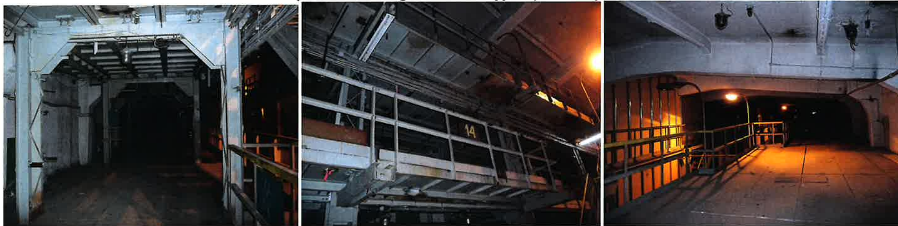
IL. 63, 64. Fragmenty wnętrza hali technologicznej.
