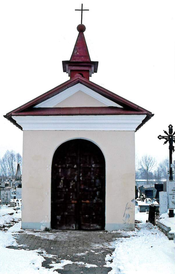
Fot. 1. Elewacja południowa.
