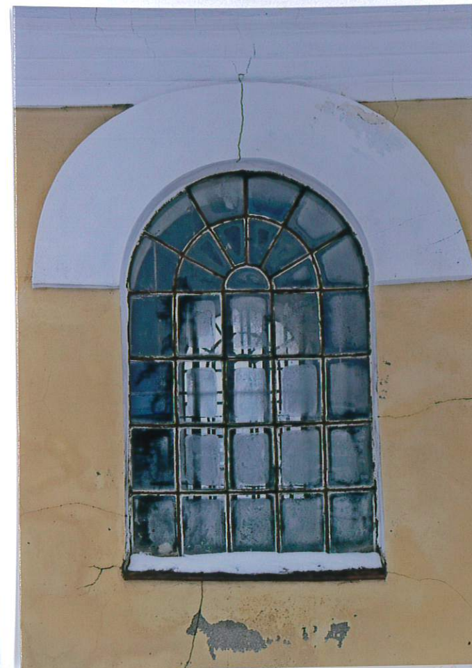
Fot. 3. Okno elewacji zachodniej.
