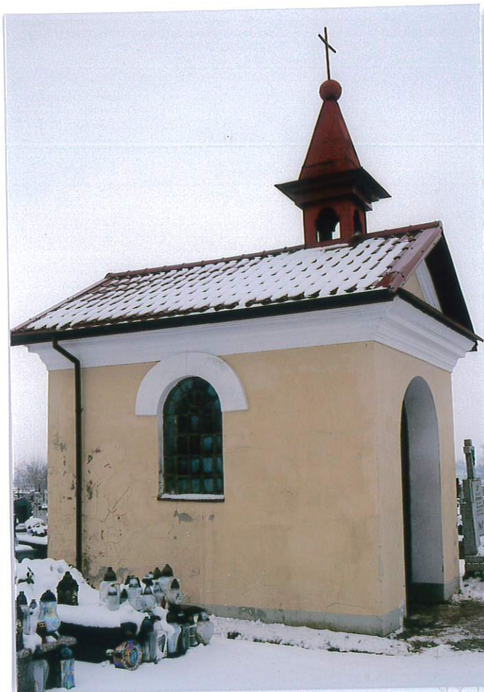
Fot. 2. Elewacja zachodnia.
