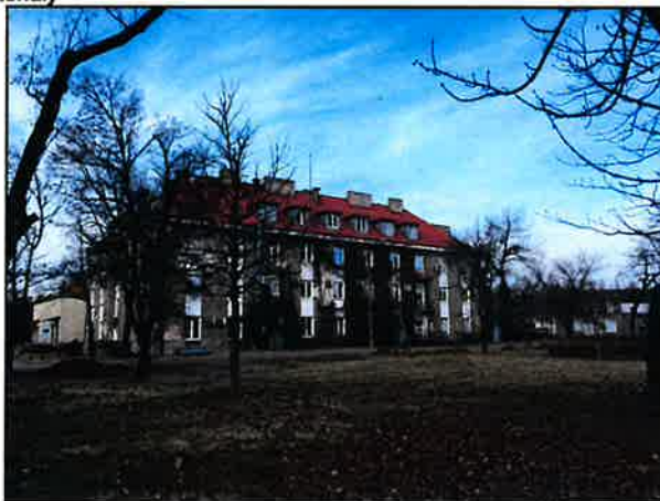
Widok frontowy od strony wewnętrznej ulicy dojazdowej
