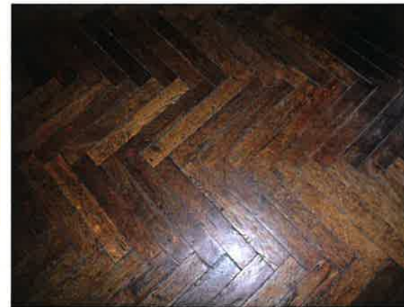
IL. 24. Korytarz 2 piętra. IL. 25. Jedno z pom. laboratoryjnych piętra. IL. 28. Podłoga z drewnianej klepki w jednym z pom. laboratoryjnych.
