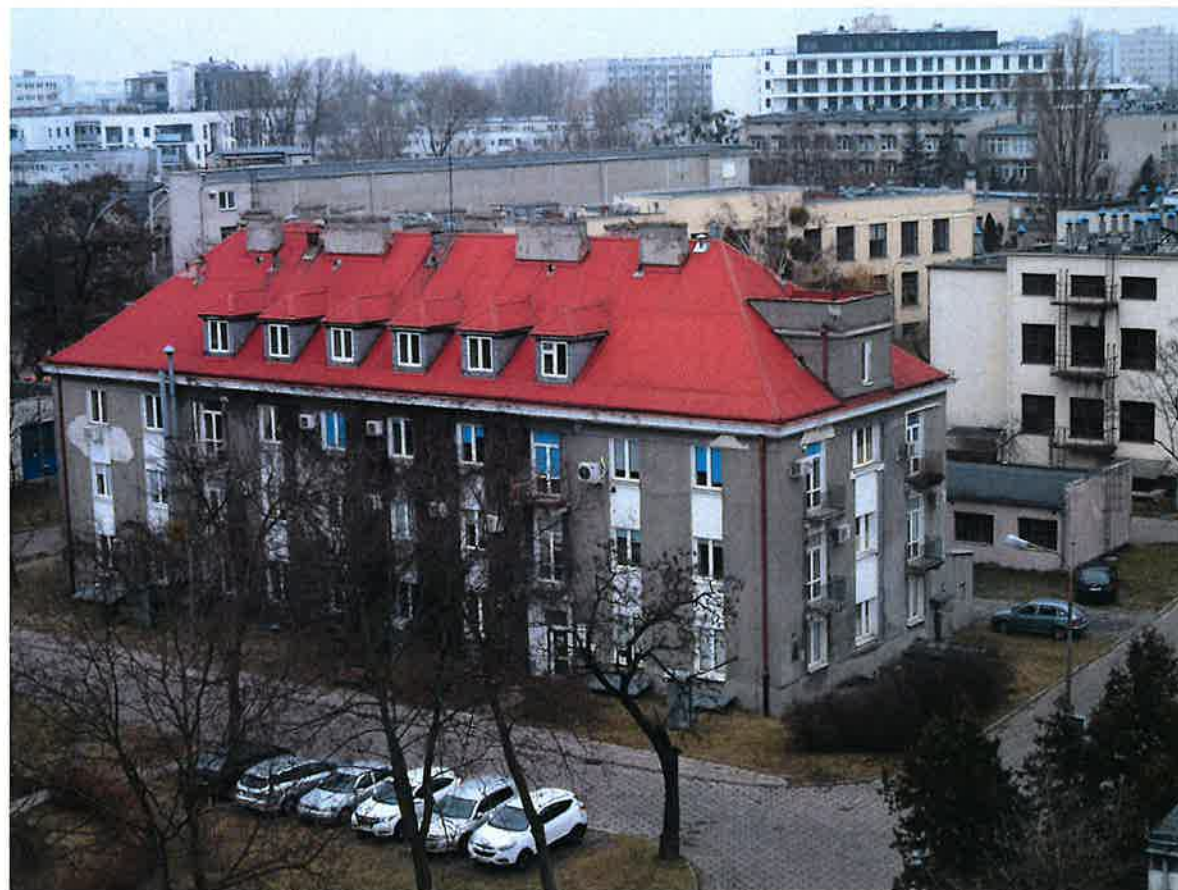
IL. 10. Widok ogólny z budynku biurowego (nr 24).
