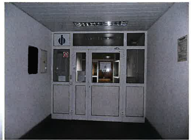
IL. 29. Drzwi korytarza piętra.
