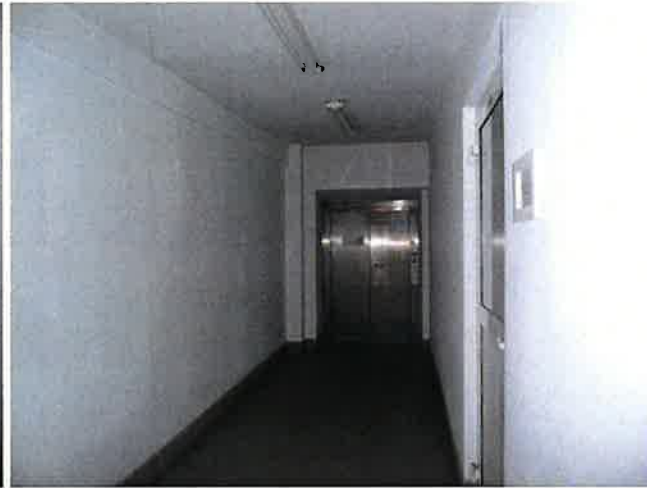
IL. 28. Widok na szyb dźwigowy (w dobudówce).
