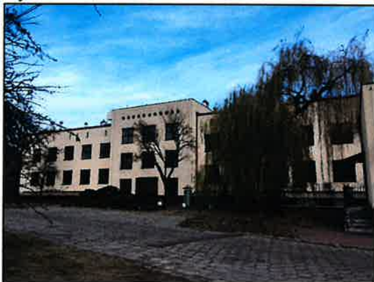
Widok od strony wewnętrznej ulicy dojazdowej
