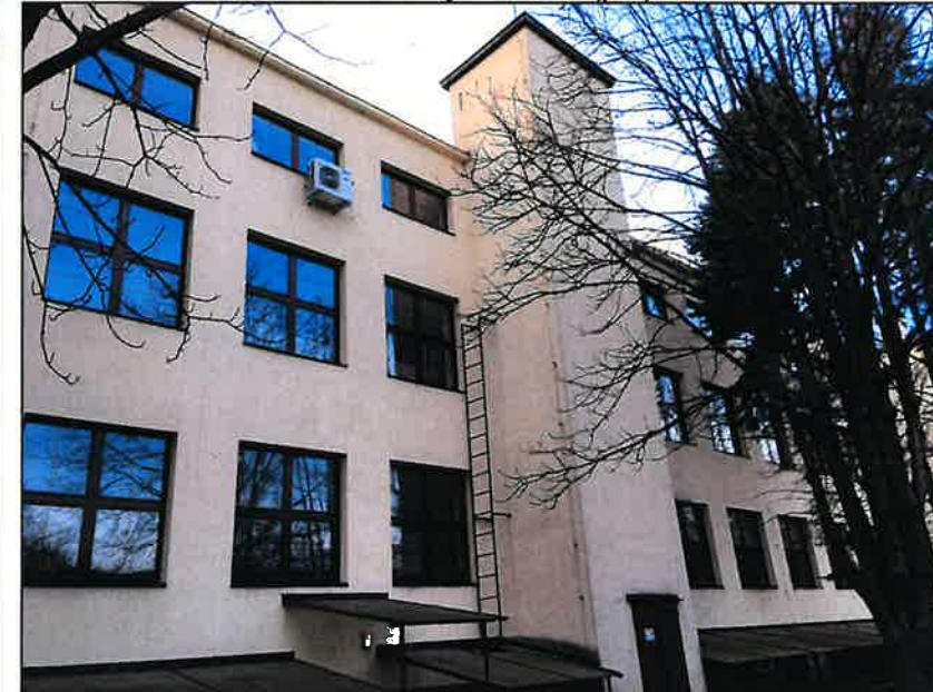
IL. 18. Elewacja tylna (wsch.) ze współczesną dobudową.
