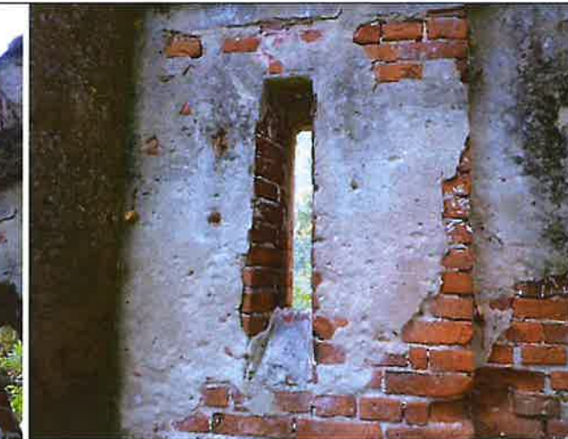
9. Fragmentu muru od pn. – widoczne relikty wypraw tynkarskich
