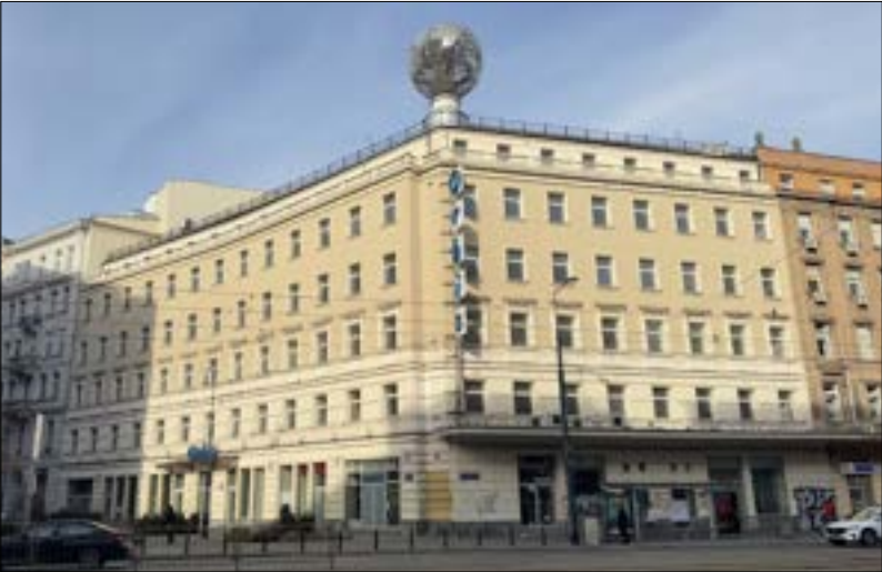
Widok budynku od strony południowo-wschodniej.
