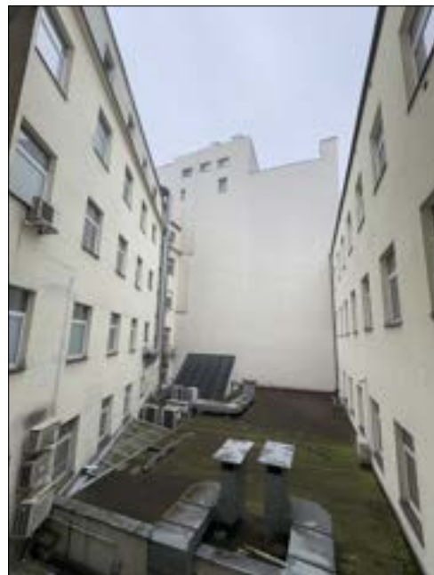
Niższa część budynku pomiędzy częścią frontową i oficyną. Widoczne wtórnie wykonane instalacje wentylacyjne oraz przebudowany dach kryty papą - pierwotnie będącym świetlikiem. (fot. Jakub Andrzejewski, 2025 r.)
