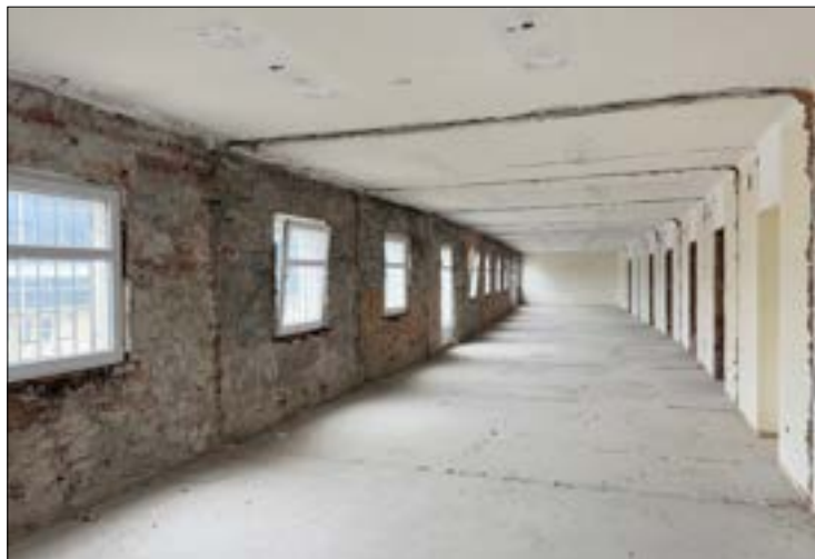
Kondygnacja V piętra od strony ul. Brackiej z wyburzonymi ścianami działowymi, skutymi częściowo tynkami oraz usuniętymi warstwami podłóg. (fot. Jakub Andrzejewski, 2025 r.)
