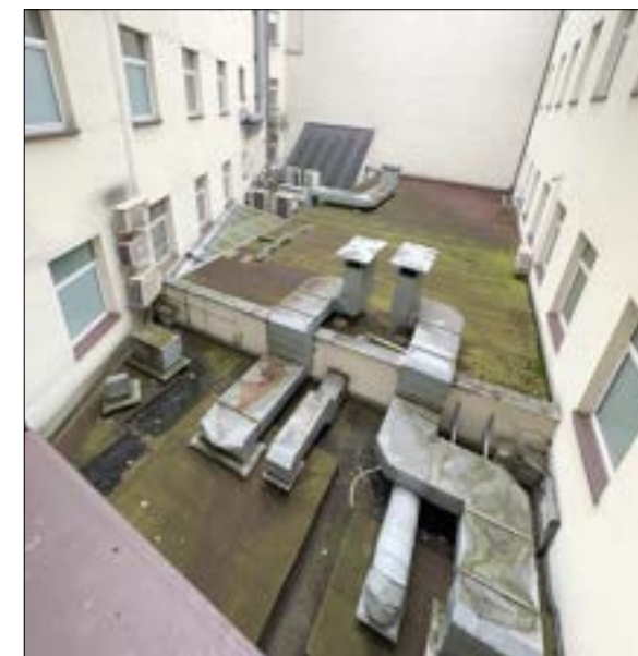
Dach nad niższą częścią budynku, widok w kierunku północno-zachodnim. (fot. Jakub Andrzejewski, 2025 r.)
