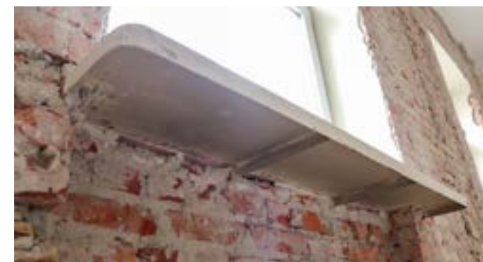
Oryginalny stalowy parapet z czasów powstania budynku, z początku lat 50. (fot. Jakub Andrzejewski, 2025 r.)
