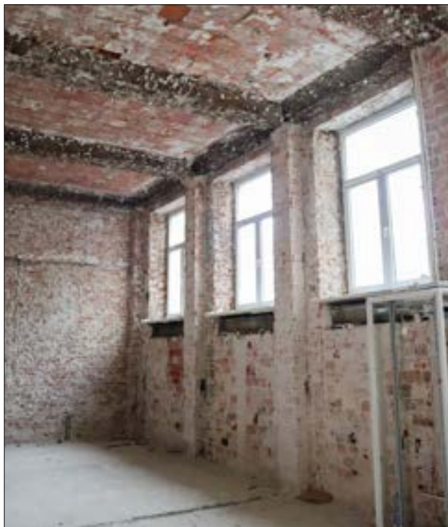
Pomieszczenie znajdujące się w kondygnacji parteru, w oficynie po stronie wschodniej. Widoczne wtórnie skute pokrycie tynkarskie ukazujące podkonstrukcję wykonaną z siatki rabitzu oraz strzemion do ukształtowania pozornego podziału stropu i zamaskowania podciągów. (fot. Jakub Andrzejewski, 2025 r.)
