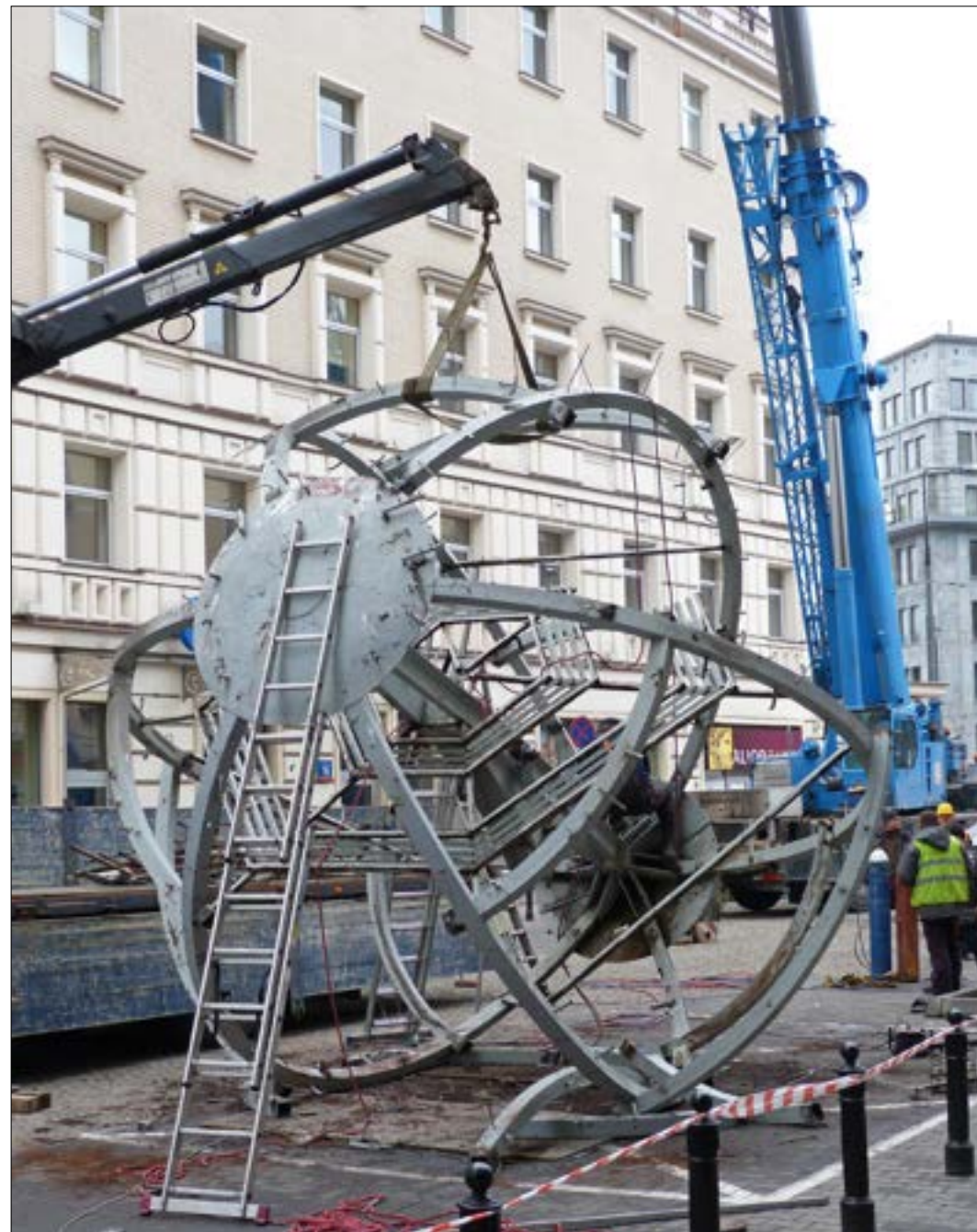
Oryginalna konstrukcja reklamy neonowej - globusa, podczas demontażu w marcu 2011 r. (fot. Jakub Andrzejewski, 2011 r.)
