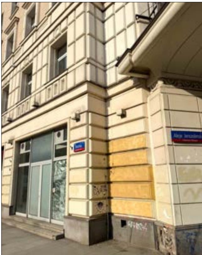
Widok naroża w przyziemiu budynku. Elewacja jak i elementy zadaszenia (markizy) od strony Al. Jerozolimskich zostały wykonane z betonowych lub gruzobetonowych prefabrykatów. Powyżej elewacja została obłożona ciekłą cegłą prasowaną, barwioną w masie, wtórnie pomalowana podczas remontu po 2000 r. (fot. Jakub Andrzejewski, 2025 r.)
