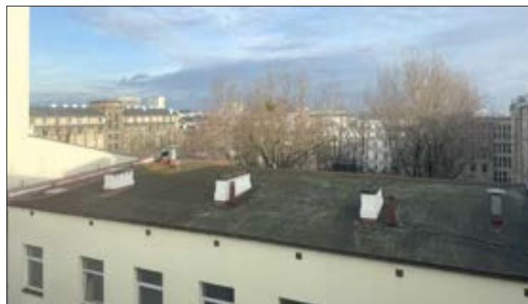
Dach oficyny, widok w kierunku wschodnim. W głębi widoczne kamienice przy ul. Nowy Świat. (fot. Jakub Andrzejewski, 2025 r.)
