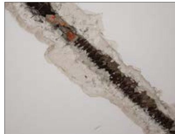
Bruzda po usunięciu ścianki działowej w suficie jednego z pomieszczeń, widoczna belka 2-teowa i siatka rabetowa. (fot. Jakub Andrzejewski, 2025 r.)
