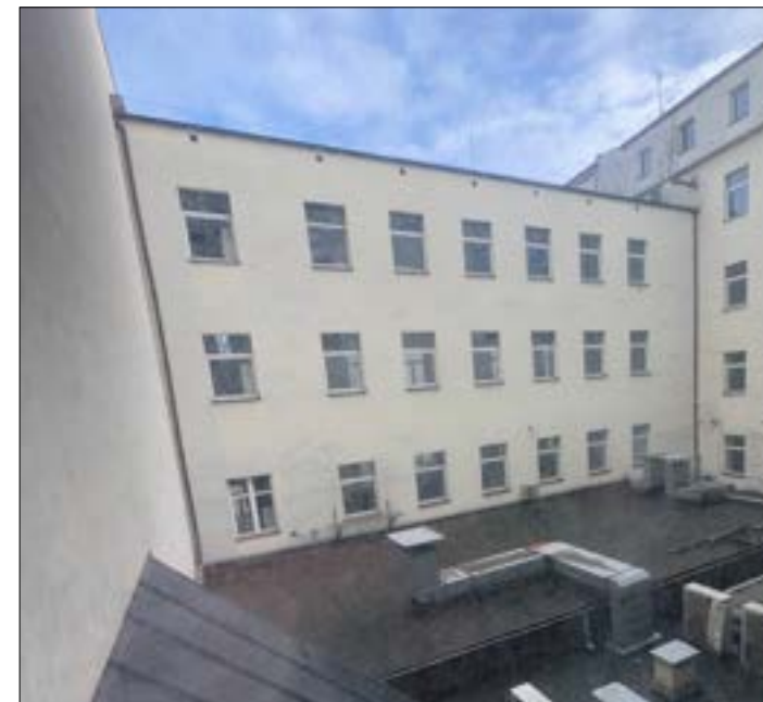
Niższa część budynku pomiędzy częścią frontową i oficyną. Widoczne wtórnie wykonane instalacje wentylacyjne oraz przebudowany dach kryty papą - pierwotnie będącym świetlikiem. (fot. Jakub Andrzejewski, 2025 r.)
