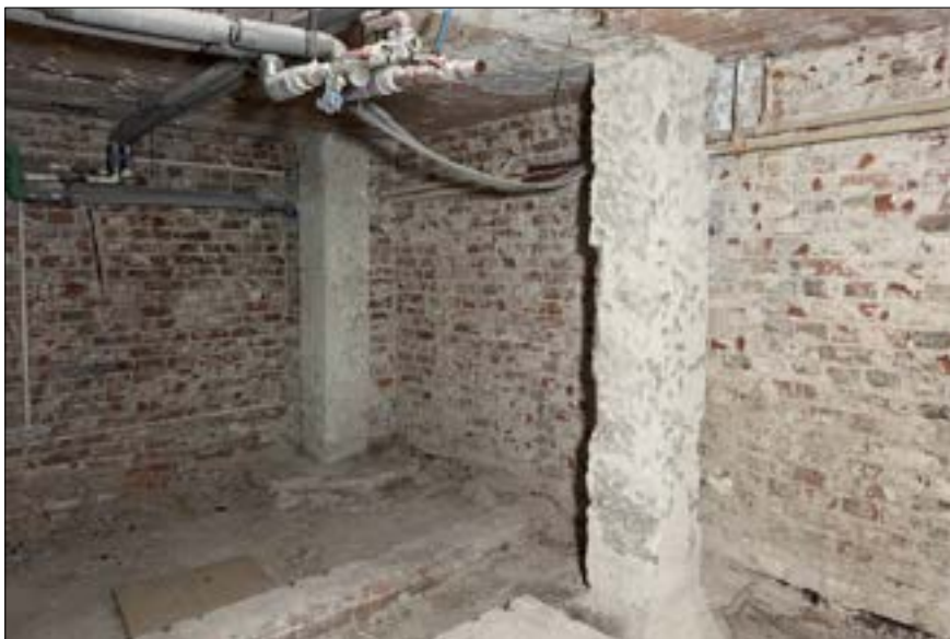
Pomieszczenia piwnic w środkowej części budynku pochodzące z początku lat 50. Widoczne żelbetowe słupy wsporcze, mury wykonane częściowo z cegły rozbiórkowej oraz powyżej strop Ackermana. (fot. Jakub Andrzejewski, 2025 r.)
