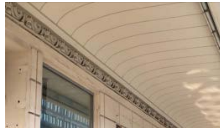
Widok zdobnego fryzu pod zadaszeniem (markizą - nazwa używana w projekcie i dokumentach) od strony Al. Jerozolimskich. Fryz oraz elementy zadaszenia zostały wykonane z elementów prefabrykowanych. (fot. Jakub Andrzejewski, 2025 r.)
