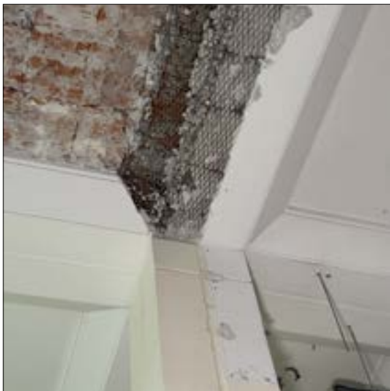
Widoczna podkonstrukcja wykonana z siatki rabetowej oraz strzemię do ukształtowania pozornego podziału stropu. (fot. Jakub Andrzejewski, 2025 r.)
