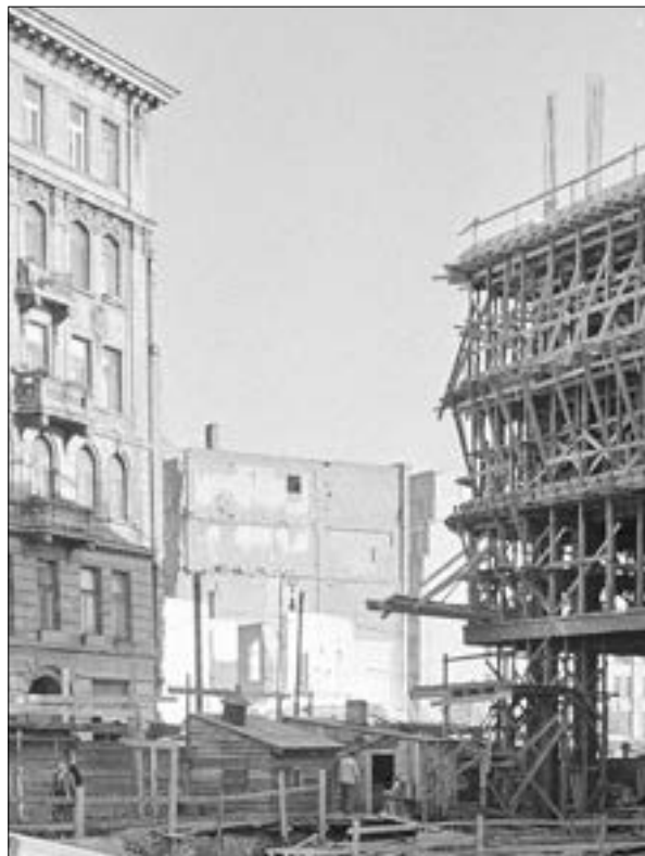
Budowa Powszechnego Domu Towarowego, w głębi widoczna działka po rozebraniu budynku przy ul. Brackiej 16 do poziomu piwnic, jesień 1949 r., (źródło: NAC; Wojskowa Agencja Fotograficzna; https://www.szukajwarchiwach.gov.pl )
