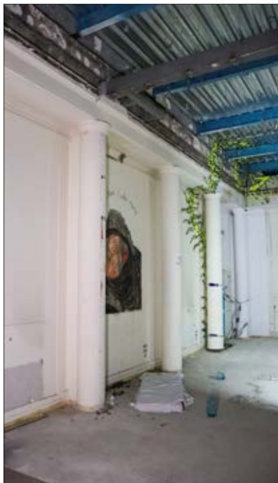
Słupy podtrzymujące żelbetonową belkę poprzeczną oraz konstrukcję dachu, widok w kierunku południowo-wschodnim. (fot. Jakub Andrzejewski, 2025 r.)
