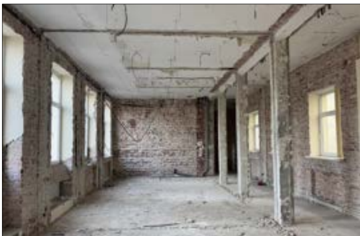
Pomieszczenie znajdujące się w kondygnacji I piętra, w oficynie po stronie wschodniej. Widok w kierunku południowym. (fot. Jakub Andrzejewski, 2025 r.)
