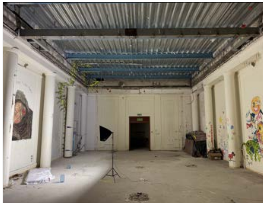
Widok sali wykończonej w stylu socrealistycznym. Sala znajduje się w parterowej części budynku, pierwotnie była przekryta przeszklonym świetlikiem dachowym. (fot. Jakub Andrzejewski, 2025 r.)
