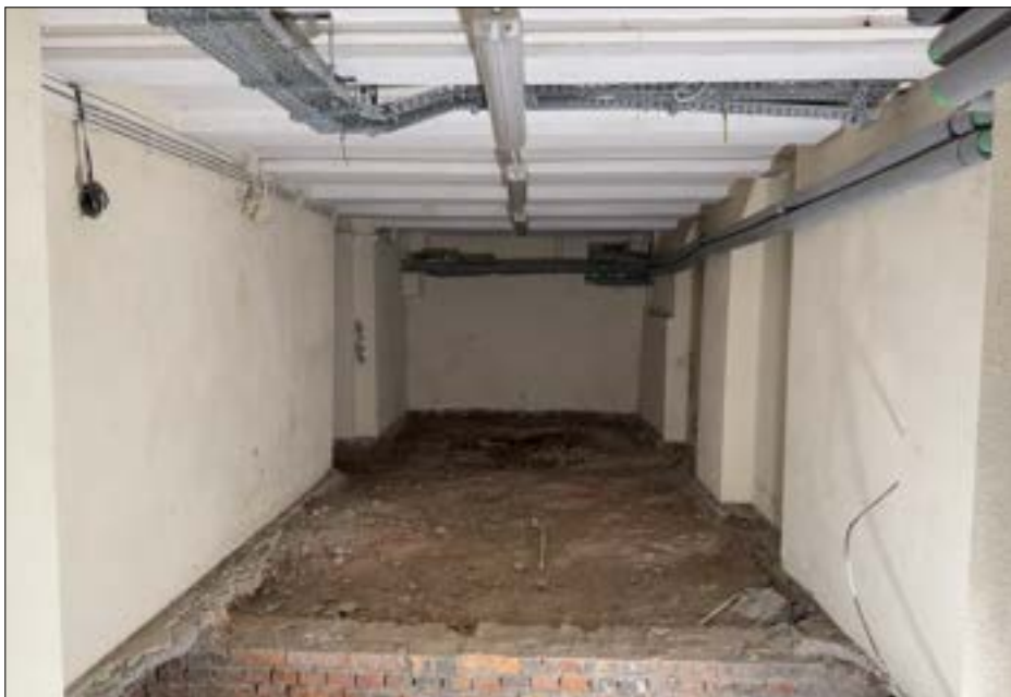
Pomieszczenie w kondygnacji piwnic znajdujące się pod dawnym przejazdem bramowym w kamienicy. Mury oraz ceglane sklepienie odcinkowe pochodzące z pierwszej kamienicy z 1875 r. (fot. Jakub Andrzejewski, 2025 r.)
