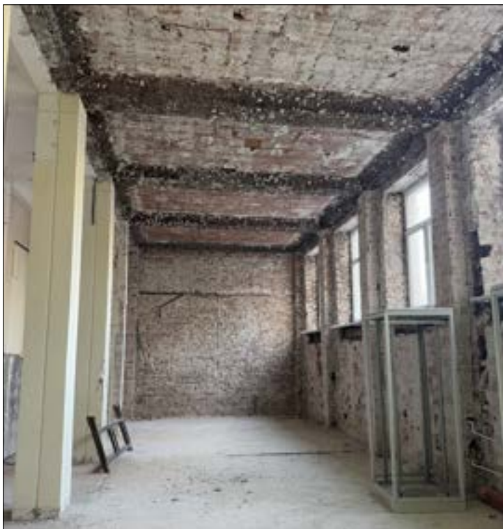
Pomieszczenie znajdujące się w kondygnacji parteru, w oficynie po stronie wschodniej. Widoczne wtórnie skute pokrycie tynkarskie ukazujące podkonstrukcję wykonaną z siatki rabitzu oraz strzemion do ukształtowania pozornego podziału stropu i zamaskowania podciągów. (fot. Jakub Andrzejewski, 2025 r.)
