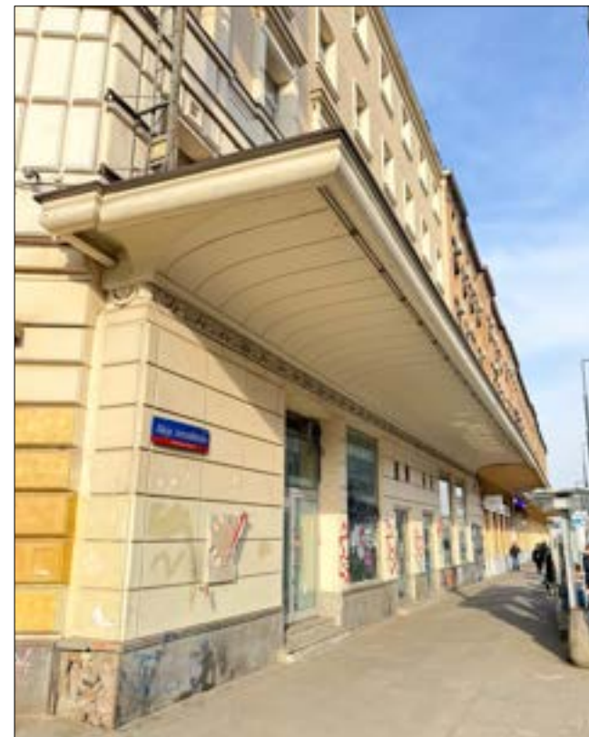
Widok naroża w przyziemiu budynku. Elewacja jak i elementy zadaszenia (markizy) od strony Al. Jerozolimskich zostały wykonane z betonowych lub gruzobetonowych prefabrykatów. Powyżej elewacja została obłożona ciekłą cegłą prasowaną, barwioną w masie, wtórnie pomalowana podczas remontu po 2000 r. (fot. Jakub Andrzejewski, 2025 r.)
