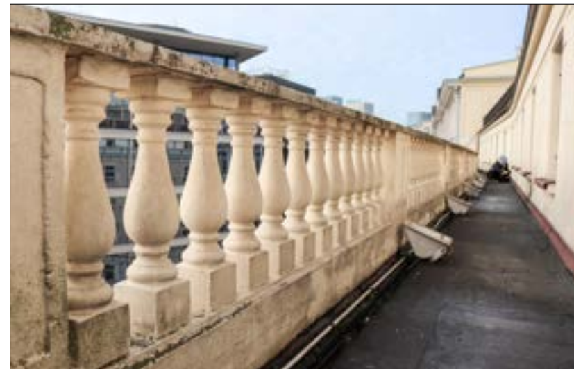
Najprawdopodobniej wtórnie wykonana żelbetowa balustrada tarasu od strony ul. Brackiej. (fot. Jakub Andrzejewski, 2025 r.)
