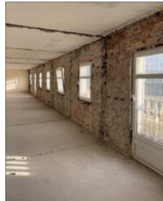
Kondygnacja V piętra, z widocznym wejściem na niewielki taras od strony Al. Jerozolimskich. (fot. Jakub Andrzejewski, 2025 r.)
