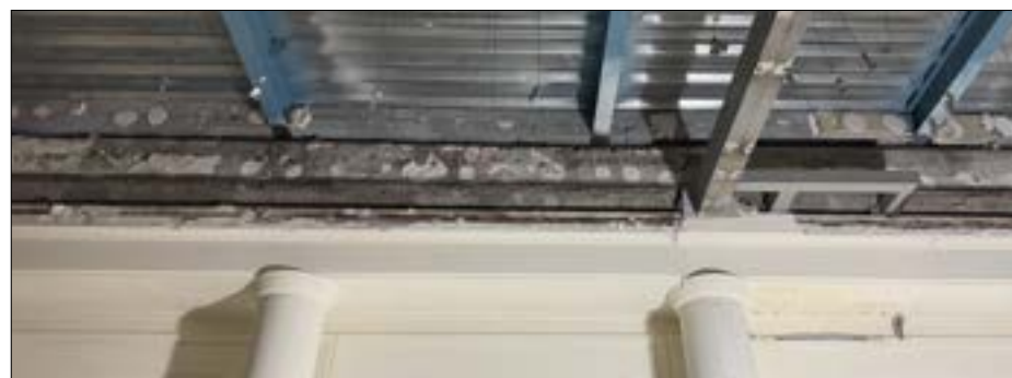
Widoczne fragmenty starej konstrukcji świetlika poniżej obecnej konstrukcji dachu opartej na 2-teownikach (w kolorze niebieskim). (fot. Jakub Andrzejewski, 2025 r.)
