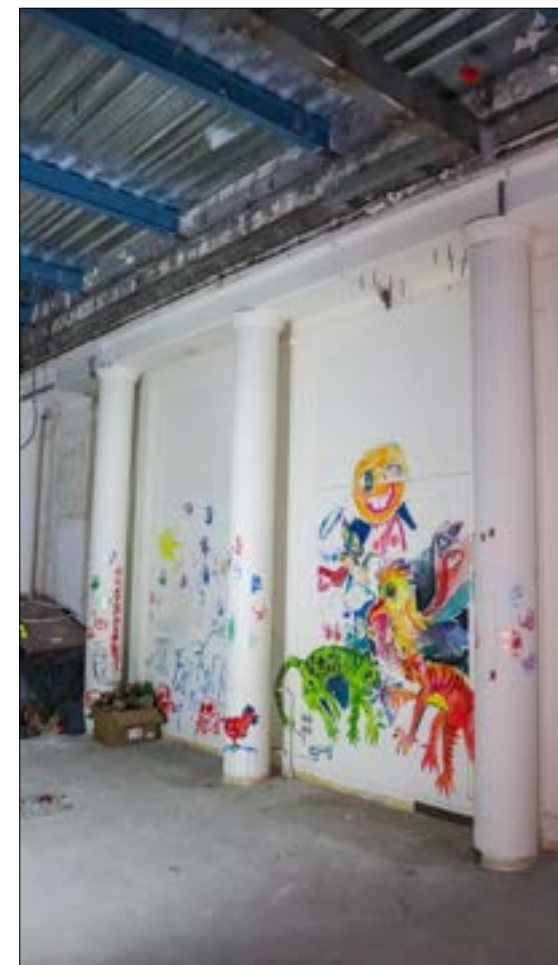
Słupy podtrzymujące żelbetonową belkę poprzeczną oraz konstrukcję dachu, widok w kierunku południowo-zachodnim. (fot. Jakub Andrzejewski, 2025 r.)
