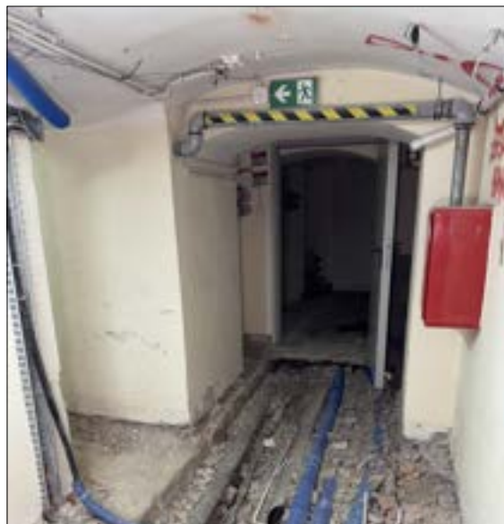
Korytarz w piwnicy w części frontowej od strony ul. Brackiej. Mury oraz ceglane sklepienie kolebkowe pochodzące z pierwszej kamienicy z 1875 r. (fot. Jakub Andrzejewski, 2025 r.)
