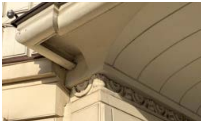
Widok zdobnego fryzu pod zadaszeniem (markizą - nazwa używana w projekcie i dokumentach) od strony Al. Jerozolimskich. Fryz oraz elementy zadaszenia zostały wykonane z elementów prefabrykowanych. (fot. Jakub Andrzejewski, 2025 r.)
