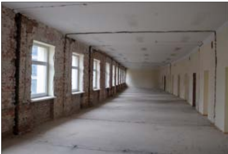
Widok jednej z kondygnacji od strony ul. Brackiej z wyburzonymi ścianami działowymi, skutymi częściowo tynkami. Widok w kierunku północnym. (fot. Jakub Andrzejewski, 2025 r.)
