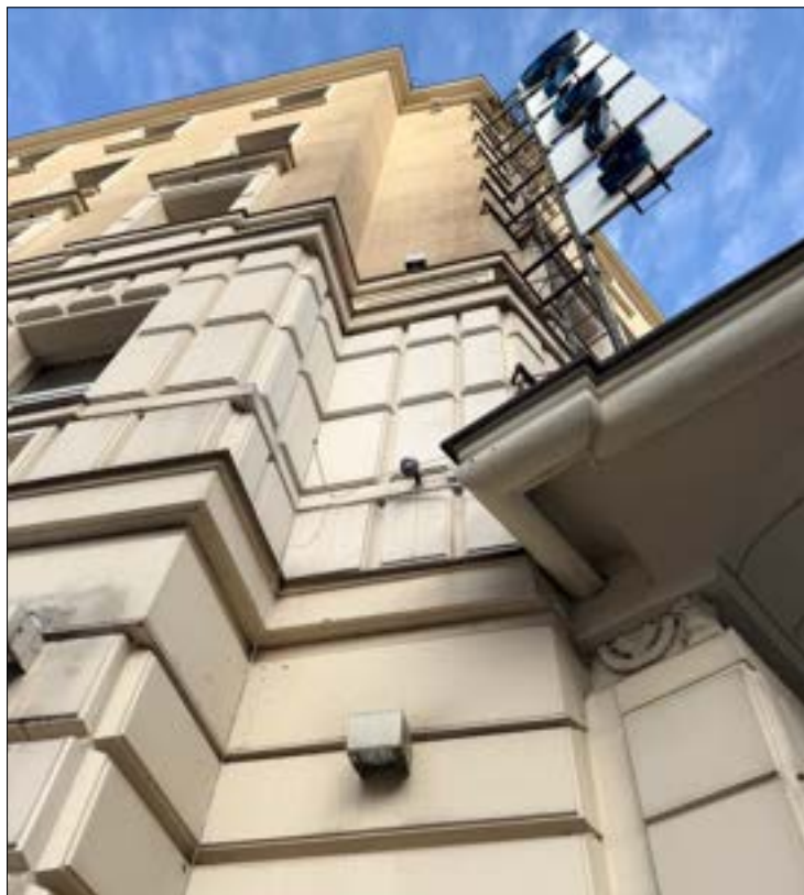
Widok naroża w przyziemiu budynku. Elewacja jak i elementy zadaszenia (markizy) od strony Al. Jerozolimskich zostały wykonane z betonowych lub gruzobetonowych prefabrykatów. Powyżej elewacja została obłożona ciekłą cegłą prasowaną, barwioną w masie, wtórnie pomalowana podczas remontu po 2000 r. (fot. Jakub Andrzejewski, 2025 r.)
