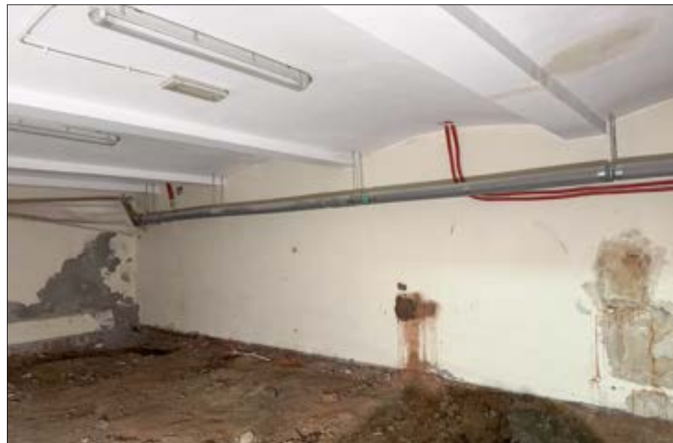
Jedno z pomieszczeń piwnic w części frontowej od strony ul. Brackiej. Mury oraz ceglane sklepienie odcinkowe pochodzące z pierwszej kamienicy z 1875 r. (fot. Jakub Andrzejewski, 2025 r.)
