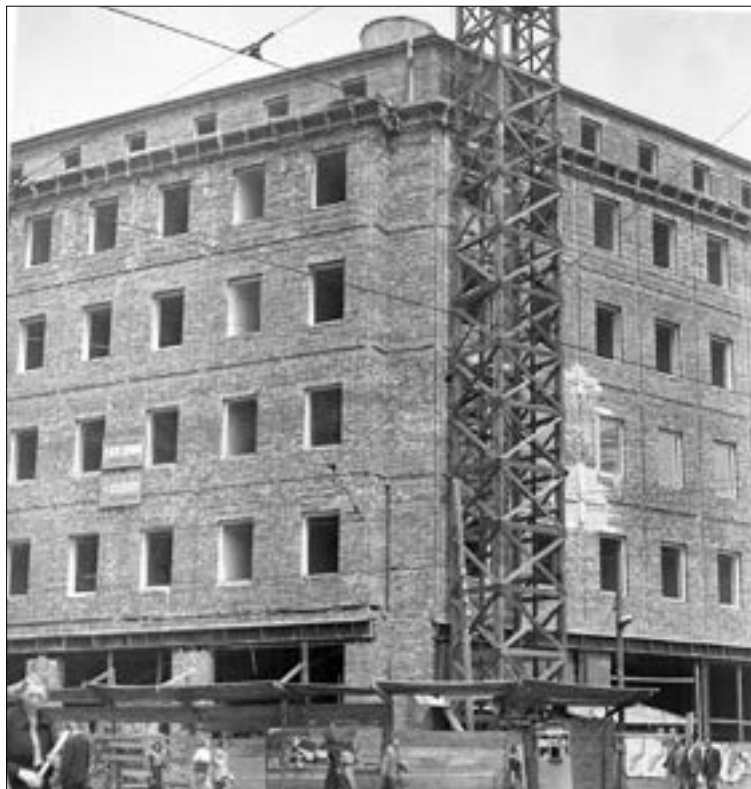
Budowa budynku biurowego przy Brackiej 16, widok od strony południowej i Al. Jerozolimskich. Widoczny stan surowy budynku z próbnym fragmentem elewacji wykonanym przed zmianą projektu. Zdjęcie z połowy 1950 r. (fot. ze zbiorów prywatnych, źródło: http://fotopolska.eu )
