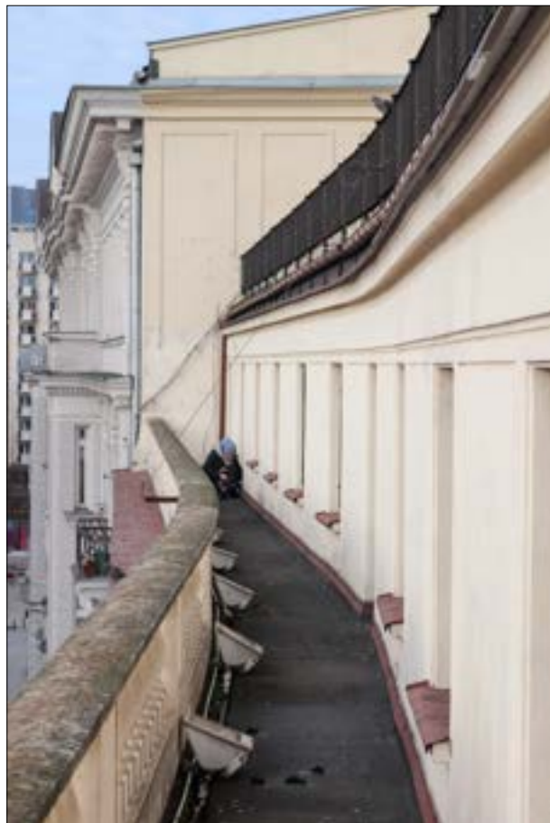
Niewielki taras w kondygnacji V piętra od strony ul. Brackiej. Widok w kierunku północnym, w głębi widoczna kamienica pod numerem 18. (fot. Jakub Andrzejewski, 2025 r.)
