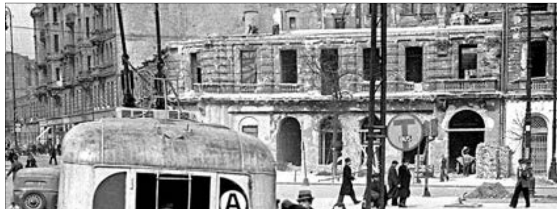
Fragment zdjęcia z 1946 r., w głębi widoczna kamienica przy ul. Brackiej 16 podczas prac porządkowych i adaptacji na cele usługowe (tymczasowe - do sierpnia 1949 r.). Zachowane ściany i kominy powyżej kondygnacji I piętra zostały wyburzone. (źródło: https://fotopolska.eu/ )
