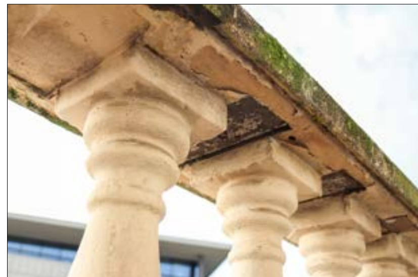
Detal balustrady tarasu. Widoczne kawałki płyty pilśniowej pomiędzy tralkami (pozostałość po szalunku). (fot. Jakub Andrzejewski, 2025 r.)
