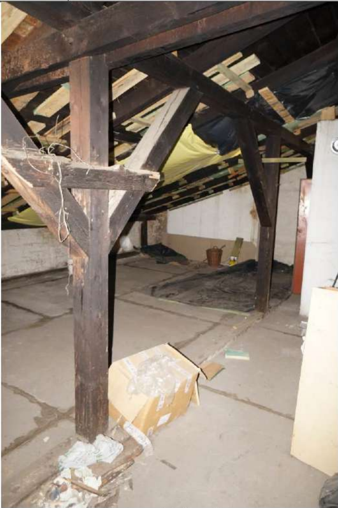
Więźba dachowa płatwiowo-kleszczowa.
