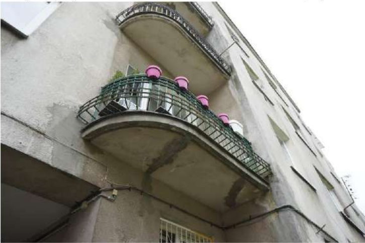
Balkony na elewacji południowej.
