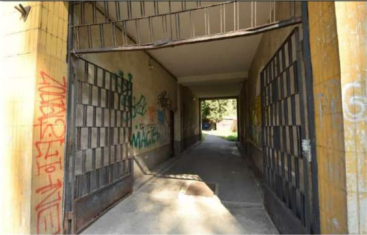
Przejazd bramny z zachowaną oryginalną bramą.
