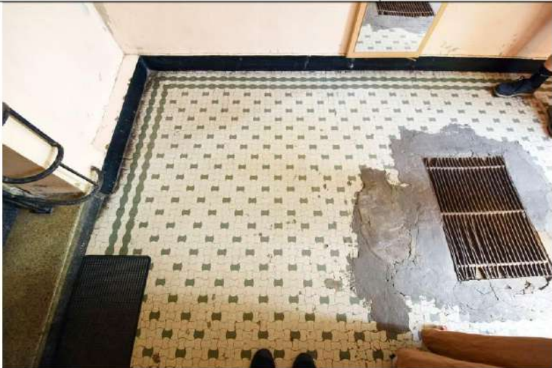
Dekoracja posadzki głównej klatki schodowej.
