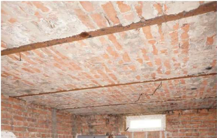
Piwnica. Strop Kleina.
