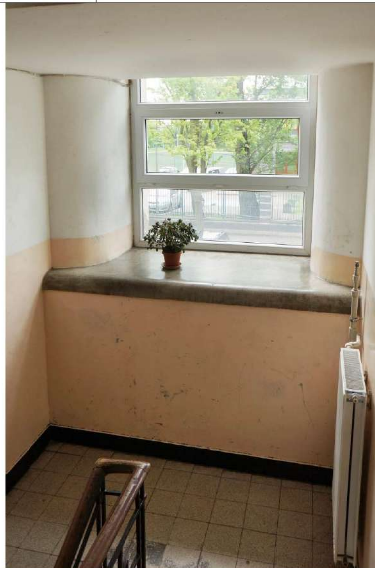
Spocznik klatki schodowej.
