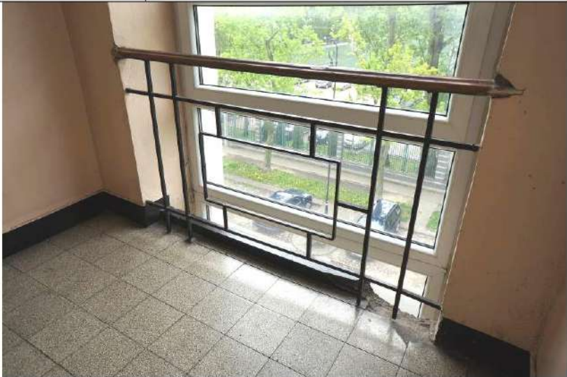
Ozdobna bariera schodów głównej klatki schodowej.
