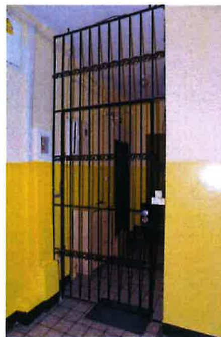
krata wydzielająca wejścia do lokali w poziomie trzeciego piętra
