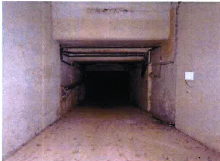
wjazd do garażu podziemnego
