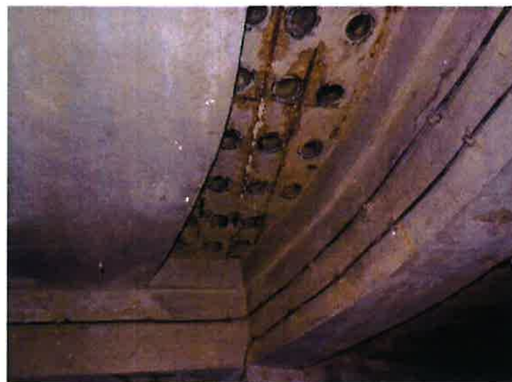
zbrojenie stropu oraz innowacyjne półsferyczne kształtki zatopione w żelbecie
