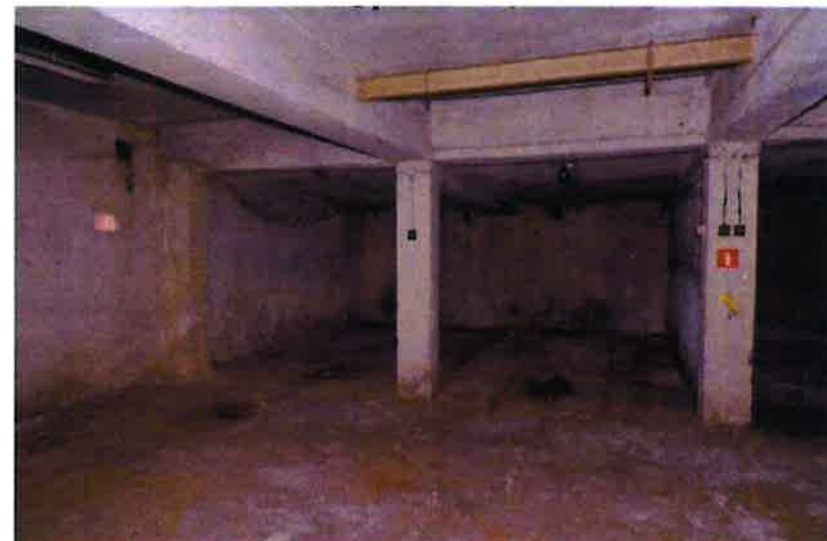
stanowiska naprzeciw wjazdu rozdzielone słupem, z wykonanym w cegle pasem dzielącym miejsca postojowe
