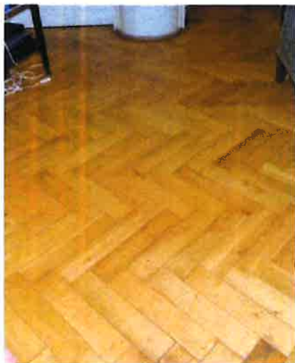
podłoga z klepki dębowej, mozaika ceramiczna w pomieszczeniach sanitarnych i w kuchni
