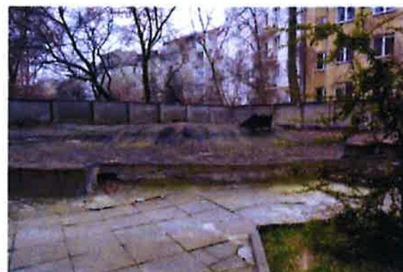
zejście do hali garażowej, fragment zadaszenia z wywietrznikami, widok na zadaszenie garażu
