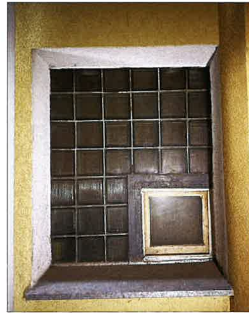
Oryginalne, zachowane, okna po lewej balkonowe okno drewniane, zespolone, po prawej okno wykonane z luksferów od strony galerii komunikacyjnej. (fot. Jakub Andrzejewski, 2025 r.).
