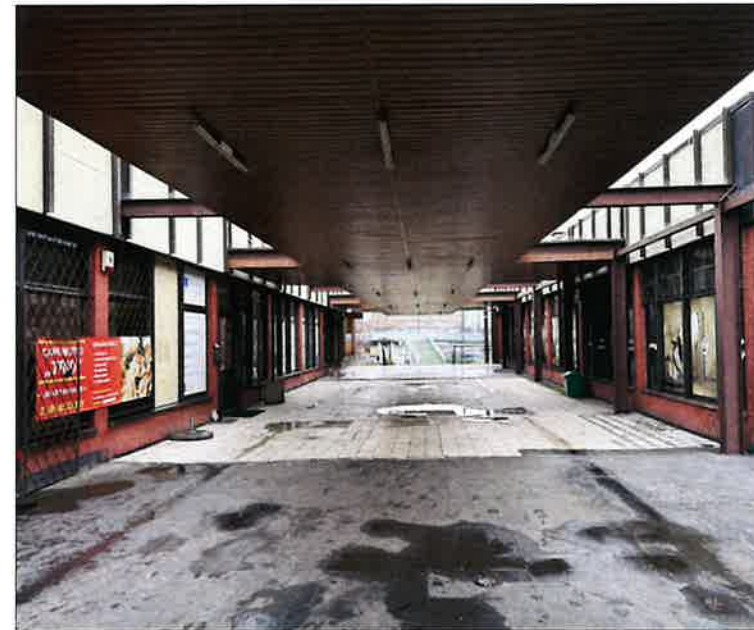
Pasaż pawilonu handlowego na kondygnacji I piętra. (fot. Jakub Andrzejewski, 2025 r.).
