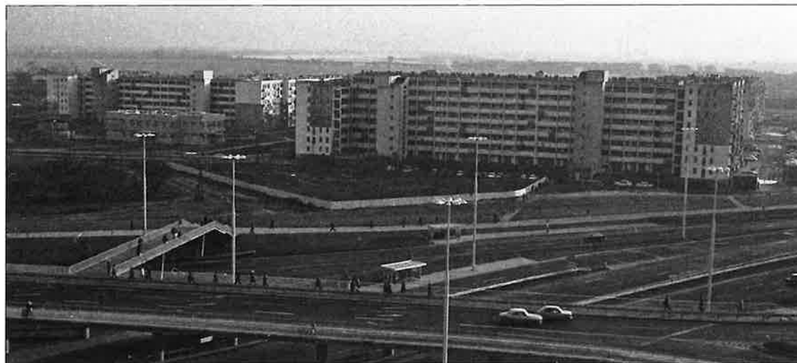
Zdjęcie wykonane od strony północnej z widokiem na ogrodzony teren placu budowy pawilonu, połowa lat 70. (źródło: https://metahost.online/ )
