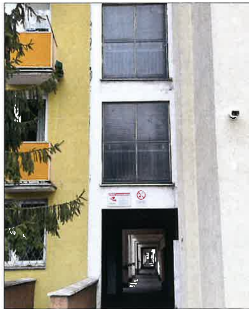
Oryginalne drewniane drzwi ramowo-płycinowe z wypełnieniem klepkowym, po prawej przeszklenia na zakończeniu galerii komunikacyjnej powyżej kondygnacji parteru. (fot. Jakub Andrzejewski, 2025 r.).
