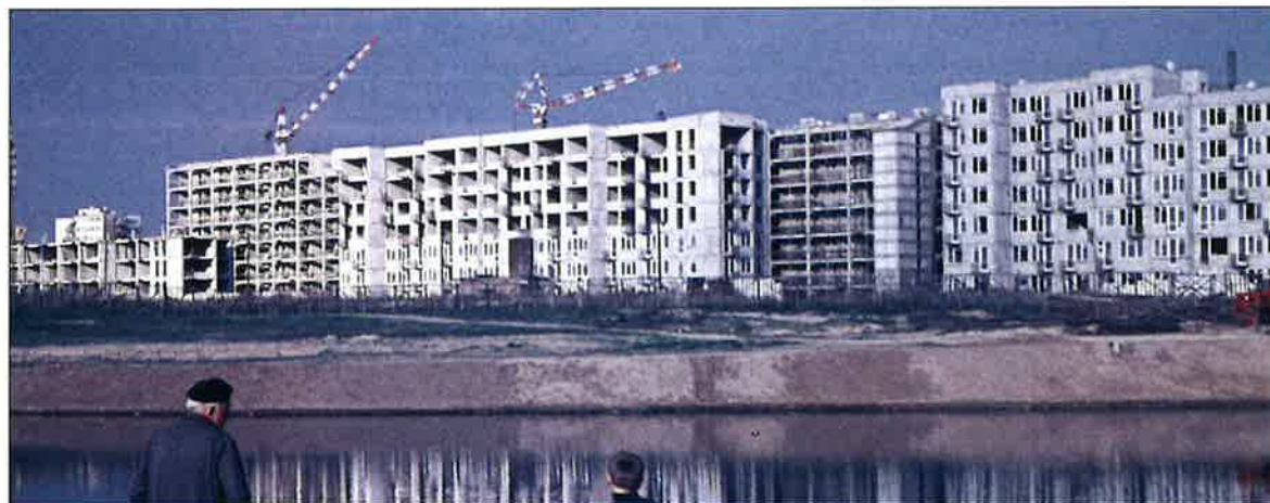
Zdjęcie z lat 1969-70 wykonane od strony Jeziora Gocławskiego w kierunku północno-wschodnim z widokiem na budynki wznoszone przy obecnej ulicy Braclawskiej. (źródło: https://metahost.online/ )
