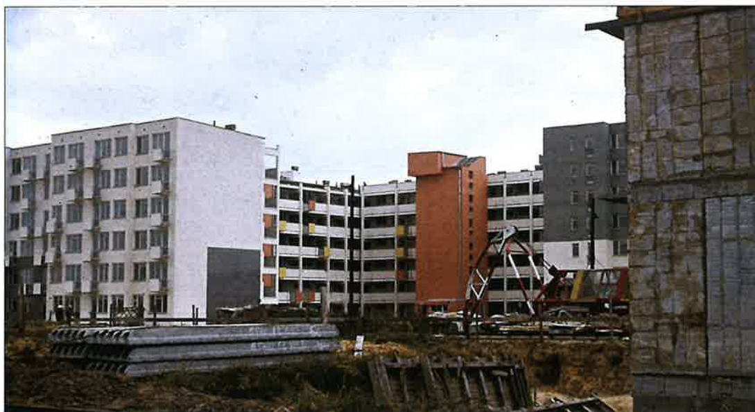
Widok placu budowy z lat 1970-1971, w głębi widoczne budynki przy ulicach Cyrklowej i Braclawskiej. (źródło: https://metahost.online/ )
