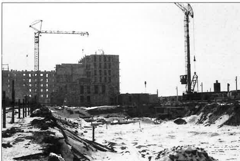
Zdjęcie wykonane z około 1969 r. po lewej widoczny wykop pod fundamenty nowych budynków przy ul. Braclawskiej, po prawej widoczne torowisko żurawia wieżowego ŻB-45. (źródło: https://metahost.online/ )
