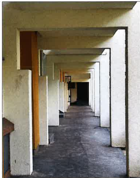
Widok pieszych galerii komunikacyjnych, od lewej widoczne zabezpieczone uszkodzenia krawędzi płyt stropowych galerii, następnie galeria w kondygnacji parteru i galeria w kondygnacji wyższych pięter. (fot. Jakub Andrzejewski, 2025 r.).
