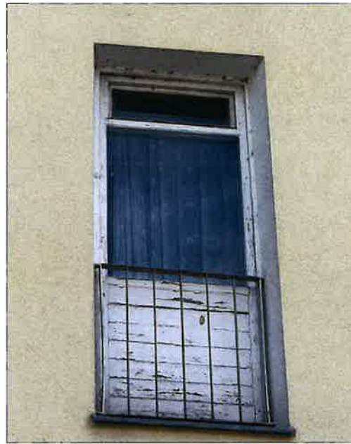
Oryginalne, zachowane, okna po lewej balkonowe okno drewniane, zespolone, po prawej okno wykonane z luksferów od strony galerii komunikacyjnej. (fot. Jakub Andrzejewski, 2025 r.).
