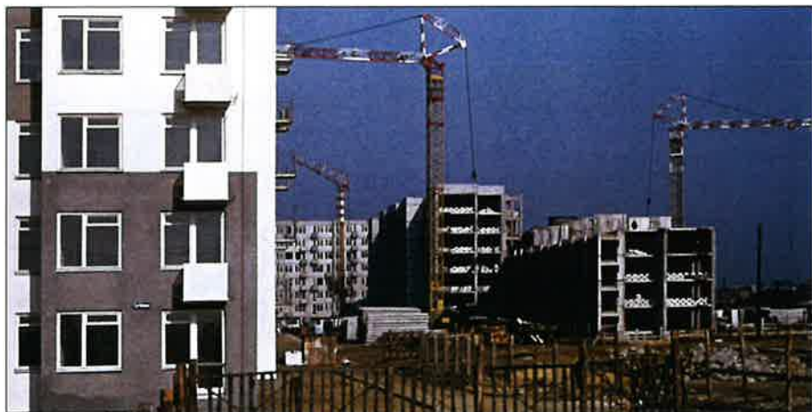
Widok placu budowy z lat 1970-1971, na pierwszym planie widoczny budynek przy ul. Cyrklowej 6, w głębi wznoszone budynki przy ul. Opinogórskiej. (źródło: https://metahost.online/ )
