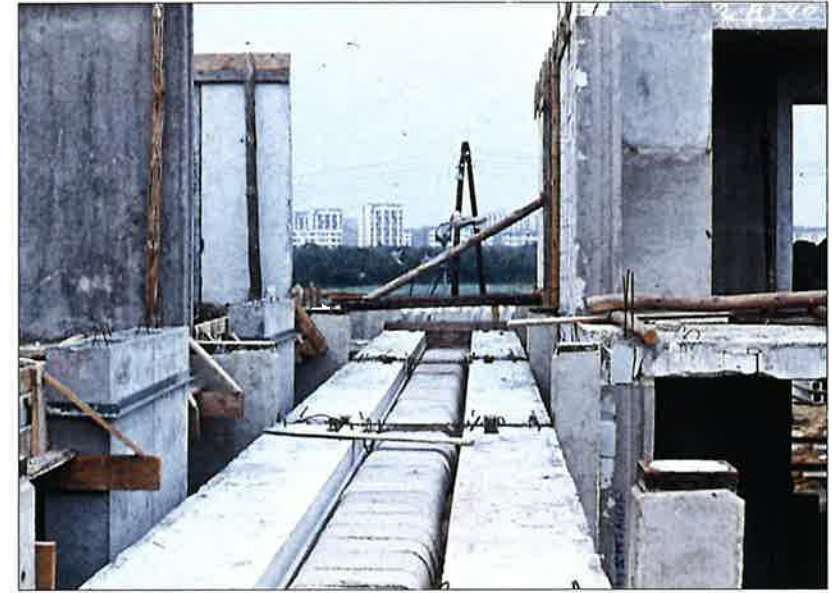
Widok placu budowy z lat 1970-1971, po lewej widoczna konstrukcja pieszej galerii komunikacyjnej pomiędzy budynkami, po prawej widoczna konstrukcja galerii na wyższych kondygnacjach. (źródło: https://metahost.online/ )
