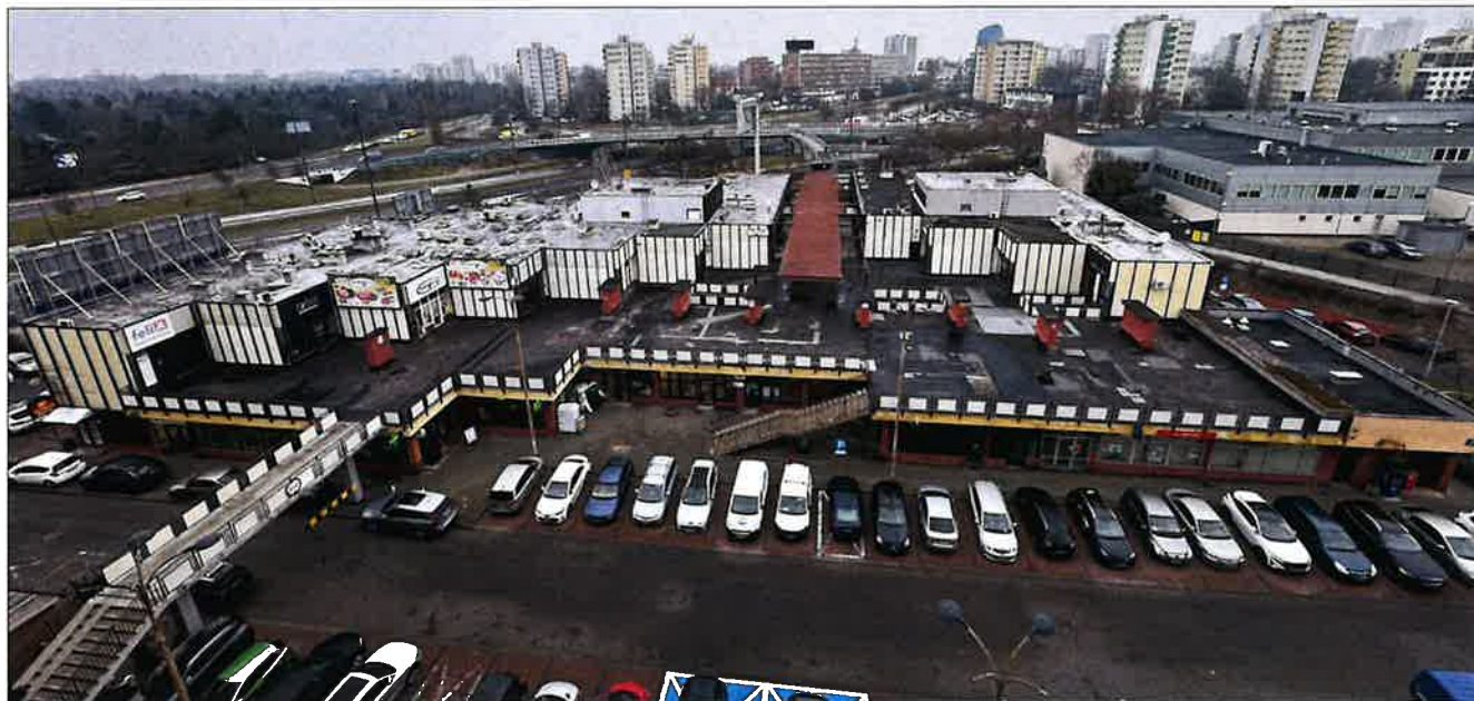
Widok ogólny pawilonu handlowego od strony południowej, nad ul. Ostrzycką. (fot. Jakub Andrzejewski, 2025 r.).
