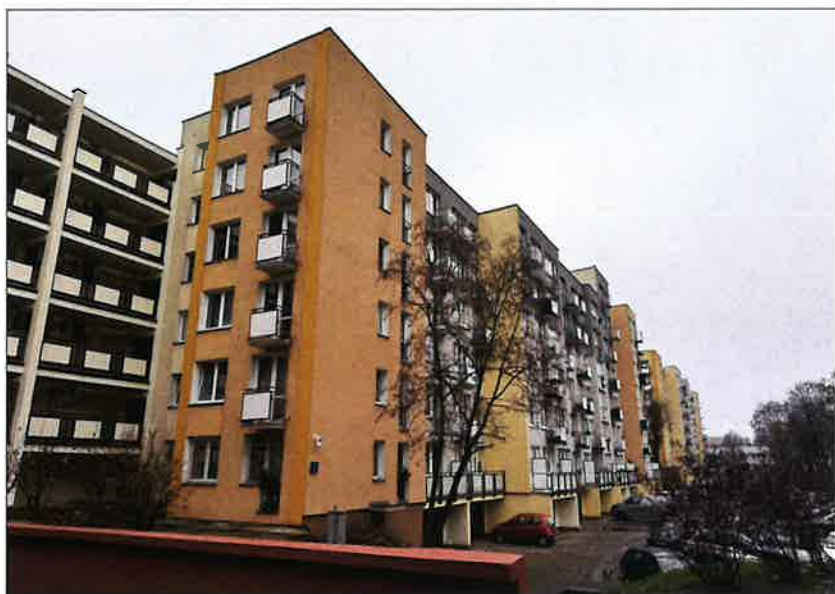
Widok budynków osiedla od strony ulicy Opinogórskiej w kierunku północnym. (fot. Jakub Andrzejewski, 2025 r.).
