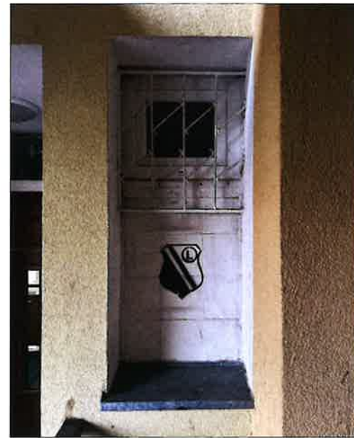
Oryginalne okna wykonane z luksferów z drewnianą lub wtórną stolarką z pcw z skrzydłem otwieranym, okna od strony galerii komunikacyjnej. (fot. Jakub Andrzejewski, 2025 r.).
