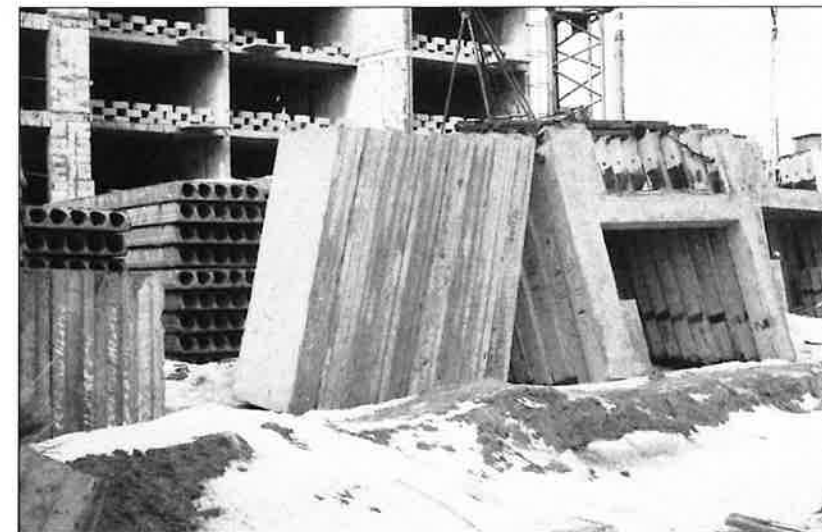
Zdjęcie placu budowy z widocznymi żelbetowymi elementami konstrukcji budynku, stropów i ścian typu „Żerań” oraz ramy konstrukcji pieszych galerii komunikacyjnych. (źródło: https://metahost.online/ )
