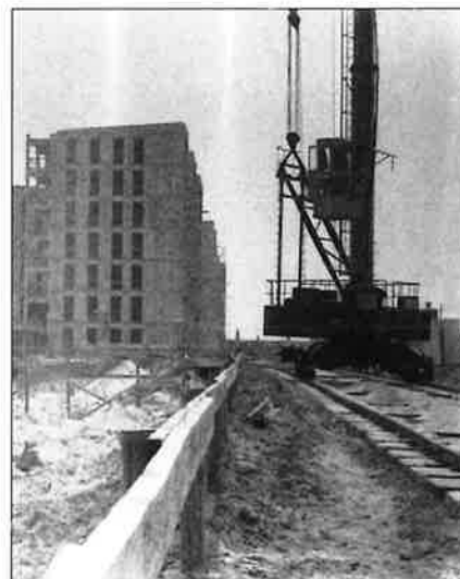
Zdjęcie wykonane z około 1969 r. po lewej widoczny wykop pod fundamenty nowych budynków przy ul. Braclawskiej, po prawej widoczne torowisko żurawia wieżowego ŻB-45. (źródło: https://metahost.online/ )
