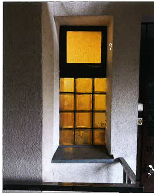
Oryginalne okna wykonane z luksferów z drewnianą lub wtórną stolarką z pcw z skrzydłem otwieranym, okna od strony galerii komunikacyjnej. (fot. Jakub Andrzejewski, 2025 r.).
