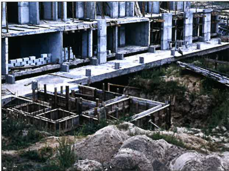
Widok placu budowy z lat 1970-1971, z widocznym na pierwszym planie fundamentem klatki schodowej, windy oraz galerii pieszej. (źródło: https://metahost.online/ )
