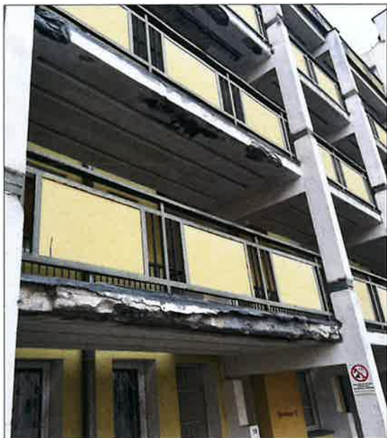
Widok pieszych galerii komunikacyjnych, od lewej widoczne zabezpieczone uszkodzenia krawędzi płyt stropowych galerii, następnie galeria w kondygnacji parteru i galeria w kondygnacji wyższych pięter. (fot. Jakub Andrzejewski, 2025 r.).
