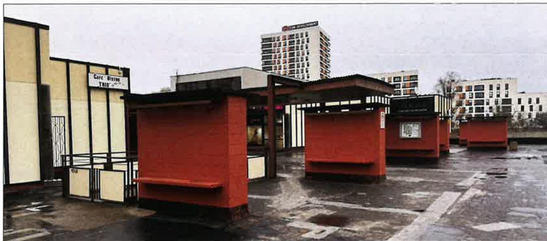
Pasaż w kondygnacji I piętra z widocznymi wywiewnikami lokali znajdujących się pod spodem, widok w kierunku północno-wschodnim. (fot. Jakub Andrzejewski, 2025 r.).
