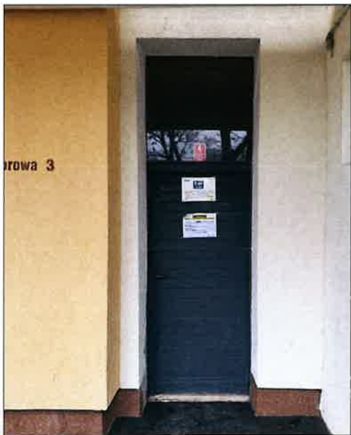
Oryginalne drewniane drzwi ramowo-płycinowe z wypełnieniem klepkowym, po prawej przeszklenia na zakończeniu galerii komunikacyjnej powyżej kondygnacji parteru. (fot. Jakub Andrzejewski, 2025 r.).
