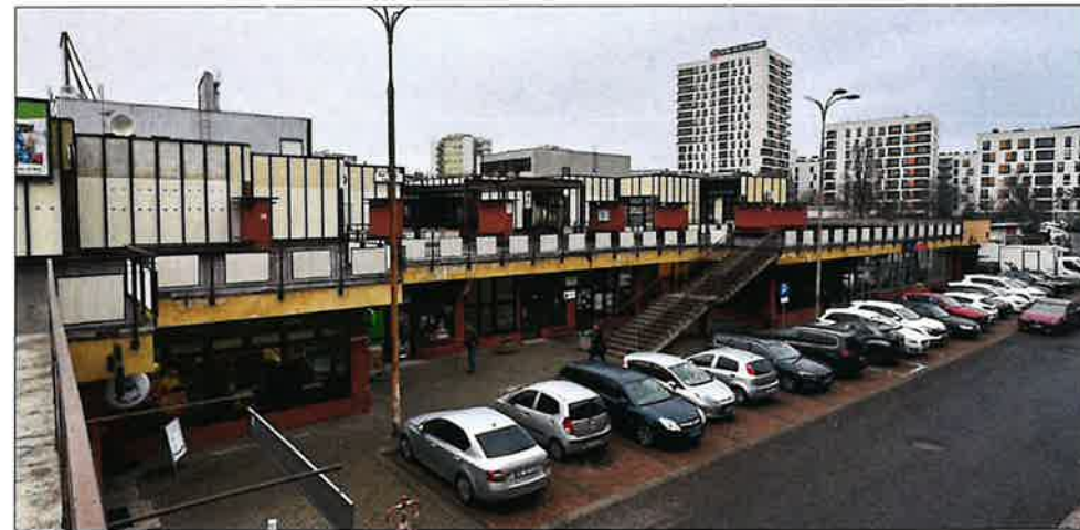
Widok pawilonu handlowego z kładki pieszej nad ul. Ostrzycką. (fot. Jakub Andrzejewski, 2025 r.).
