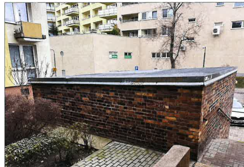
Zachowane elementy małej architektury z murami oraz pomieszczeniami stacji trafo i śmietników licowane cegłą klinkierową. (fot. Jakub Andrzejewski, 2025 r.).
