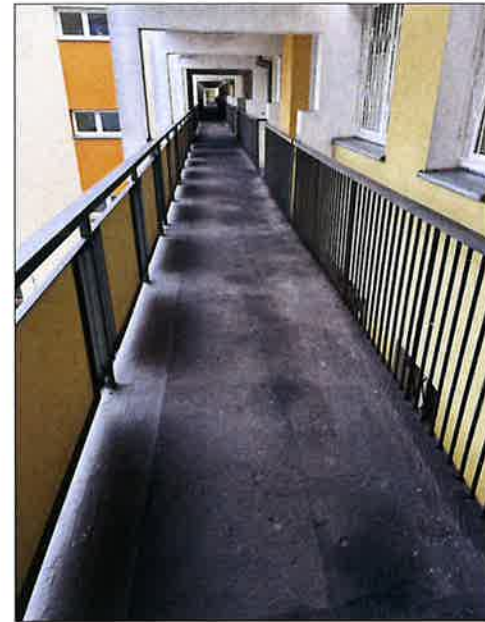
Widok pieszych galerii komunikacyjnych, od lewej widoczne zabezpieczone uszkodzenia krawędzi płyt stropowych galerii, następnie galeria w kondygnacji parteru i galeria w kondygnacji wyższych pięter. (fot. Jakub Andrzejewski, 2025 r.).
