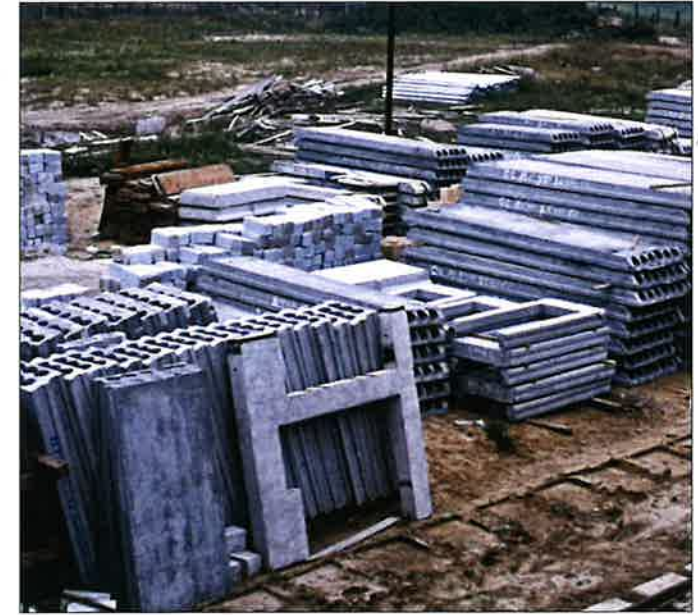
Elementy konstrukcji budynku, stropów i ścian typu „Żerań” na placu budowy. (źródło: https://metahost.online/ )
