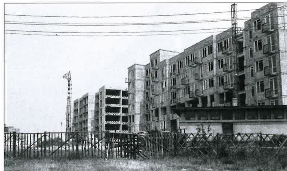
Widok placu budowy z około 1969 r. od strony południowo-zachodniej, w głębi widoczne wznoszone budynki przy ul. Braclawskiej, na pierwszym planie widoczny budynek pralni mechanicznej (nieistniejący). (źródło: https://metahost.online/ )
