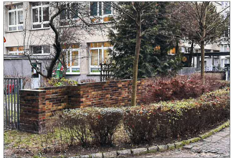
Oryginalny mur klinkierowy przedszkola. (fot. Jakub Andrzejewski, 2025 r.)
