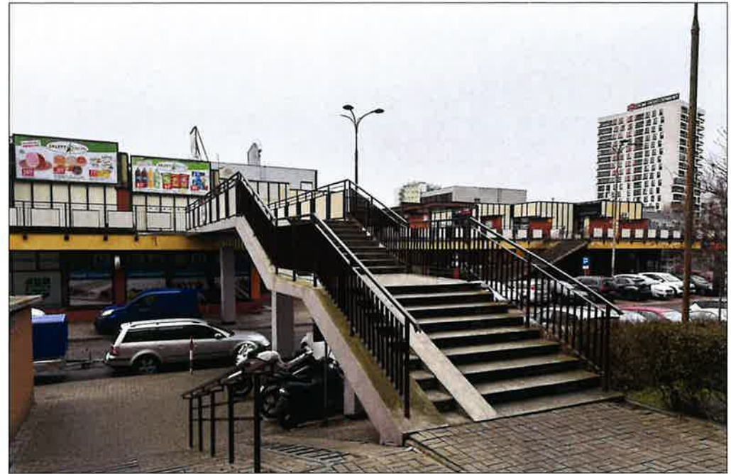
Zdjęcie ostatniej zachowanej kładki nad ul. Ostrzycką po północnej stronie osiedla. (fot. Jakub Andrzejewski, 2025 r.).
