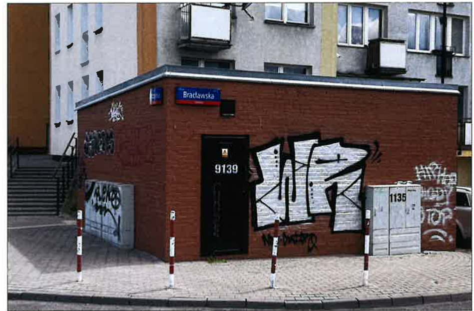
Widok stacji trafo z wtórnie pomalowaną elewacją pierwotnie wyłożoną cegłą klinkierową. (fot. Jakub Andrzejewski, 2025 r.)
