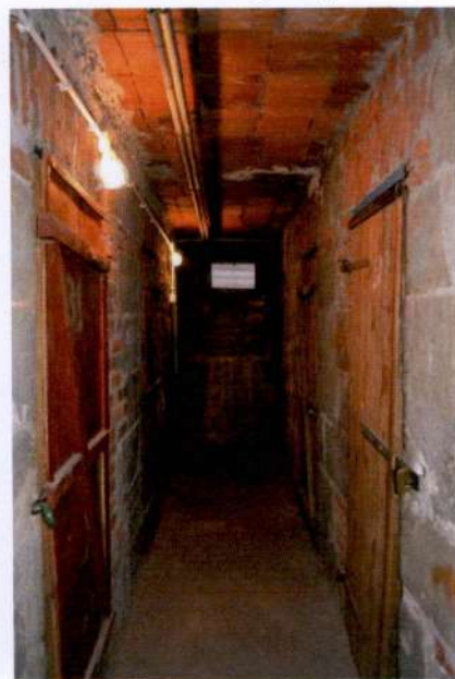
II. 90 Korytarz piwniczny
