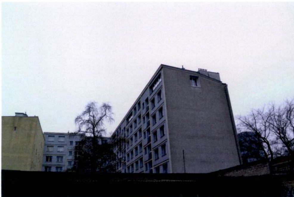
II. 67 Widok na ścianę szczytową i elewację północną od strony garaży
