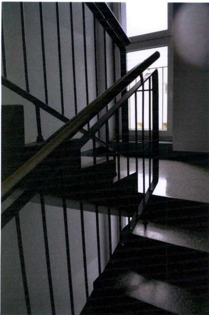
II. 82-83 Klatka schodowa, fragment schodów i balustrady
