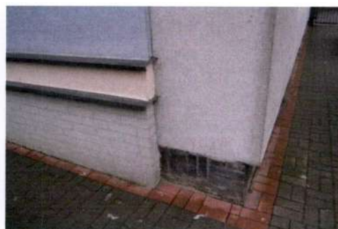
II. 65-66 Detal opracowania – oryginalne cegły klinkierowe w strefie cokołowej
