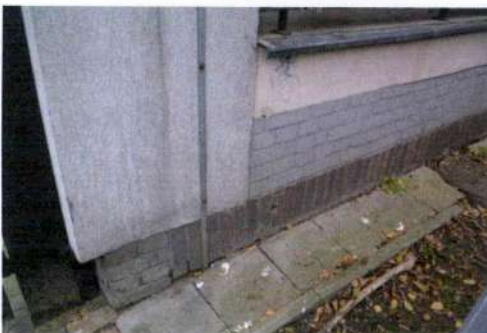
II. 65-66 Detal opracowania – oryginalne cegły klinkierowe w strefie cokołowej
