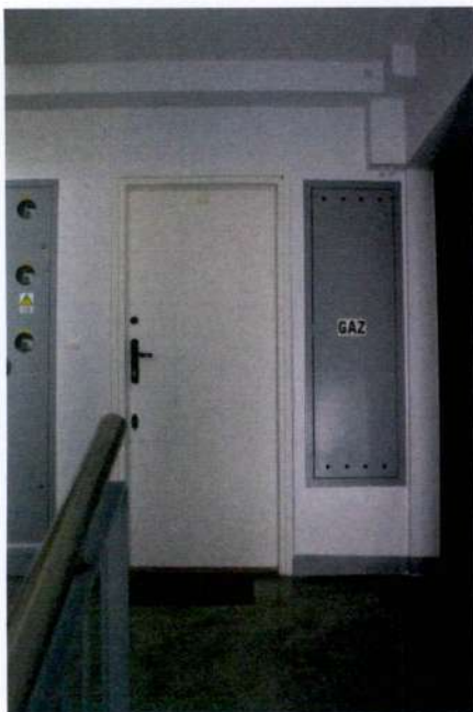
II. 86 Drzwi do lokalu mieszkalnego
