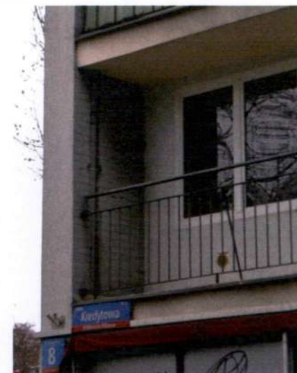
II. 58 Loggia z okładziną klinkierową ściany i prowadzoną w ścianie rury spustowej
