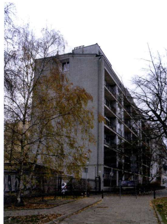
II. 64 Elewacja północne (ściana szczytowa) z wtórnym otworem okiennym
