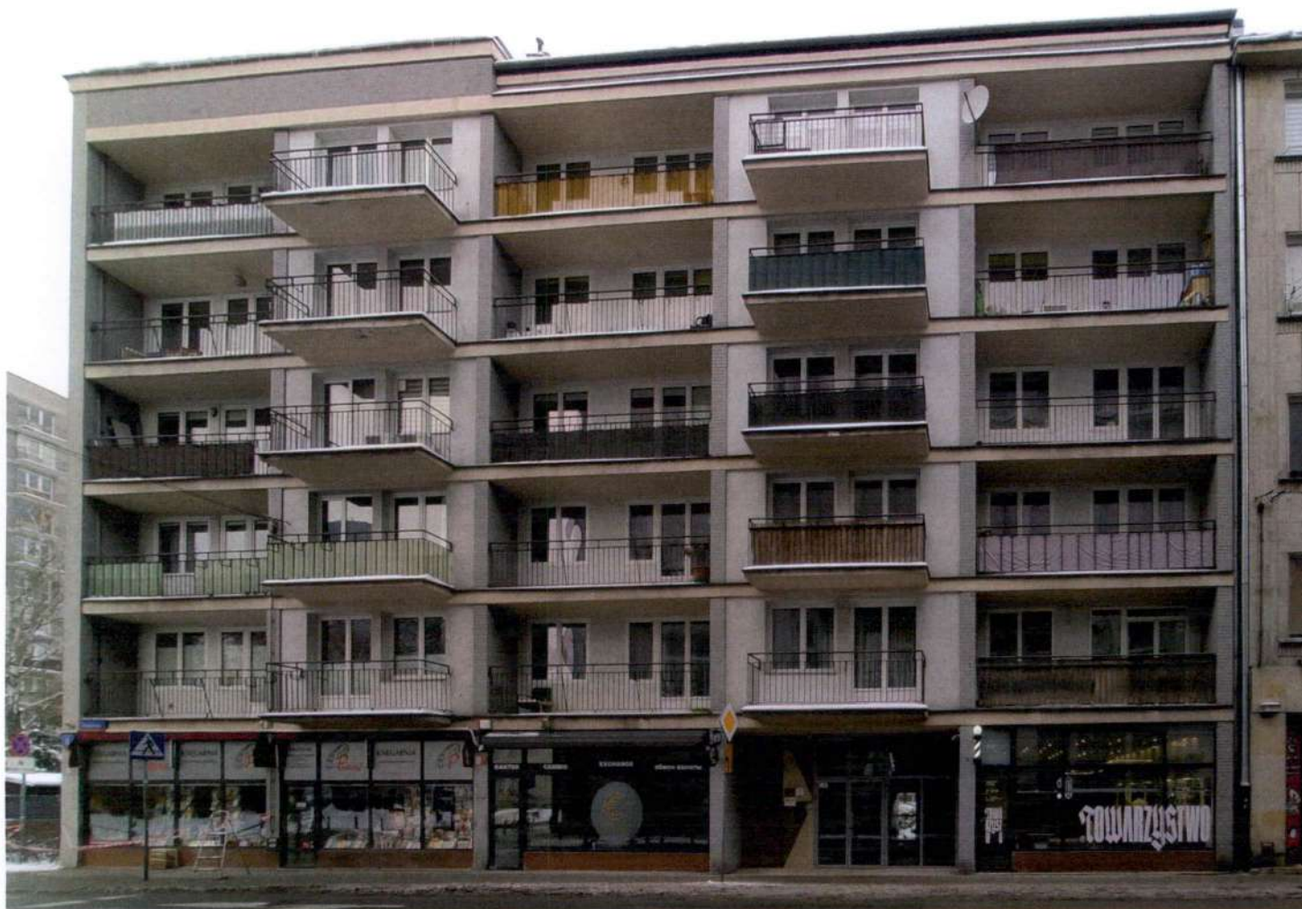
II. 57 Elewacja frontowa (południowa), na kolor szary pomalowano cegłę betonową
