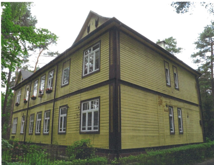
3. Elewacja południowa i wschodnia (boczna)
