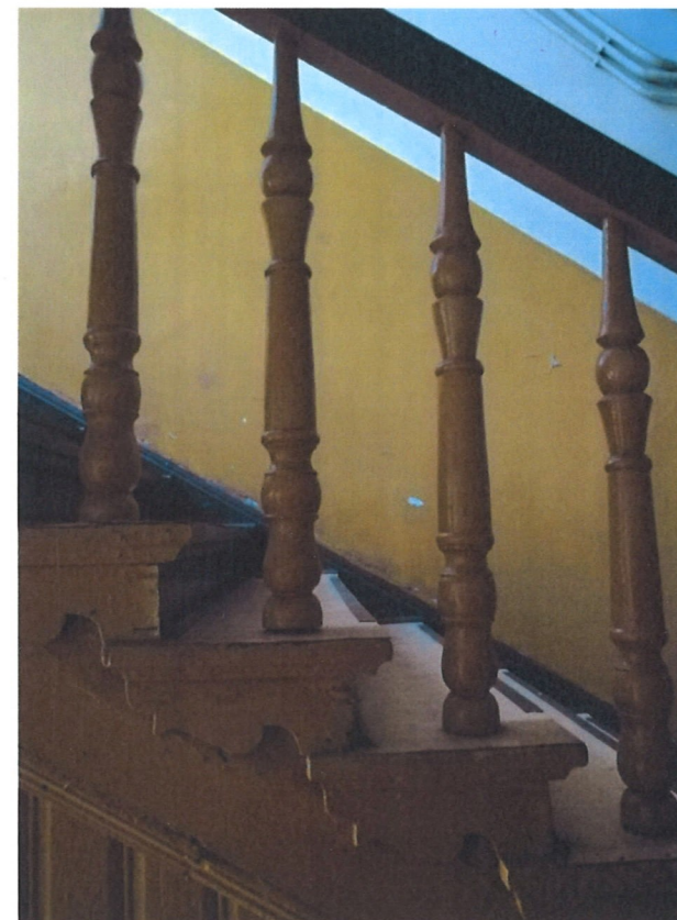
7. Balustrada klatki schodowej z dekoracją snycerską
