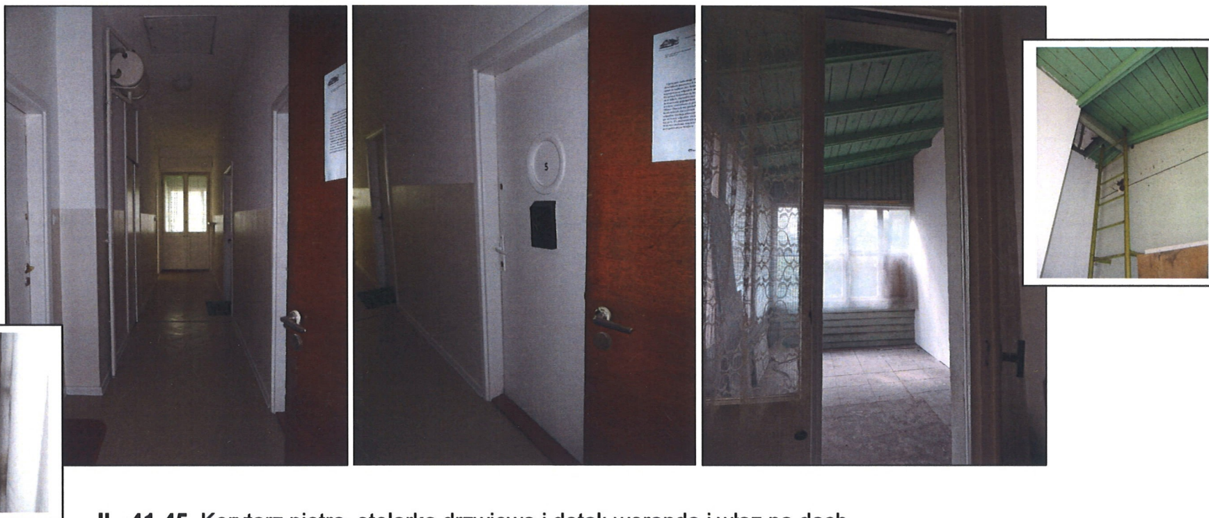
IL. 41-45. Korytarz piętra, stolarka drzwiowa i detal; weranda i wjazd na dach.
