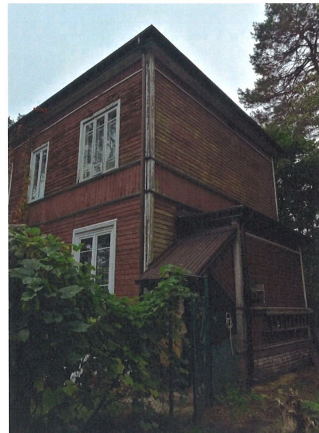
5. Część elewacji wschodniej oraz północnej
