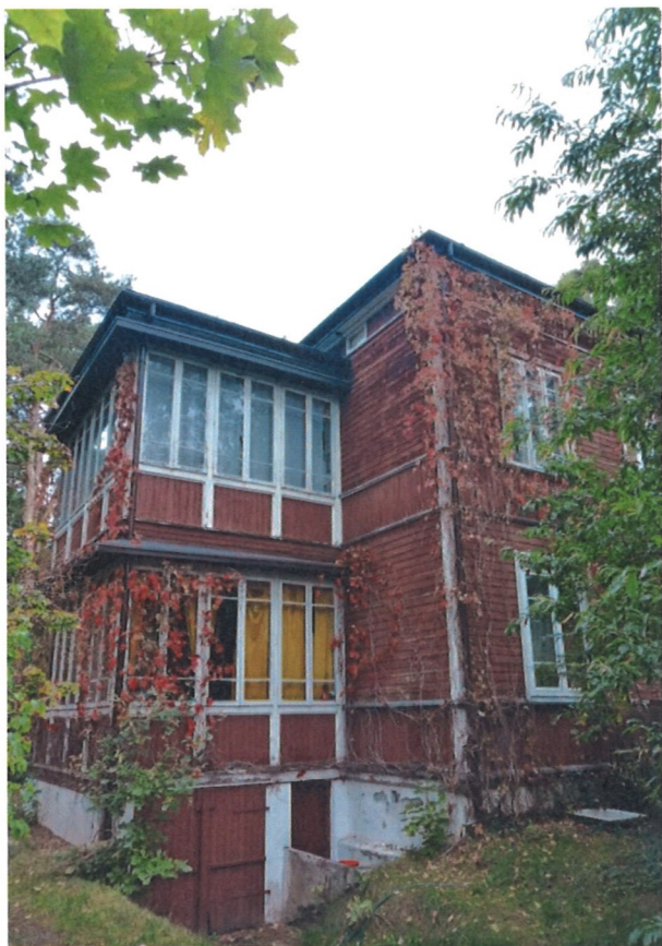
3. Widok części elewacji wschodniej oraz skrzydła werandy.
