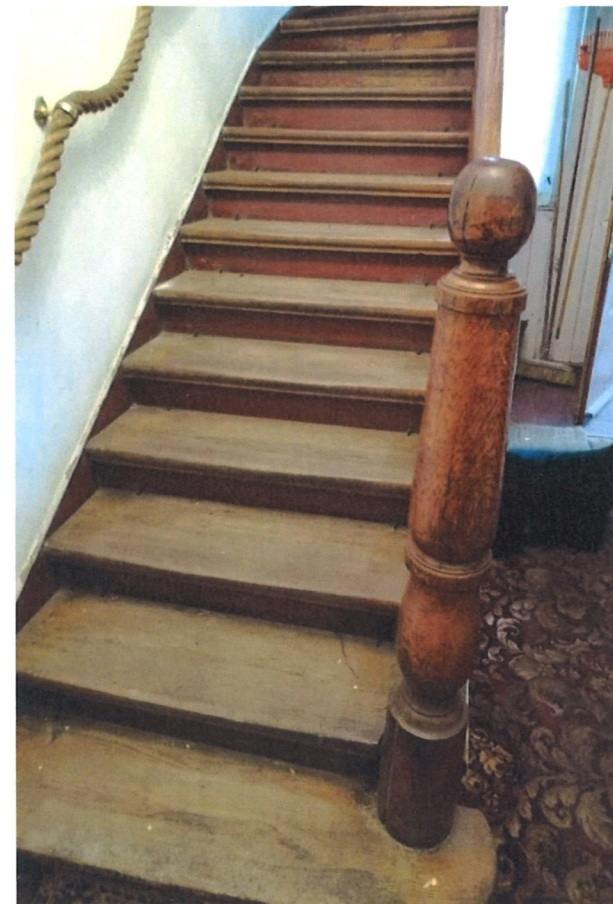
11. Drewniana klatka schodowa.
