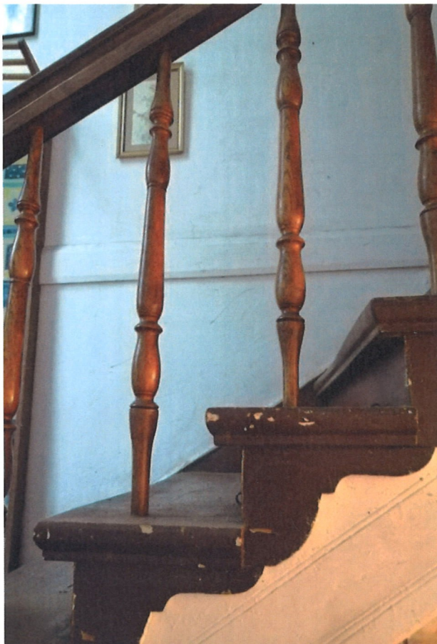
10. Balustrada klatki schodowej z toczonymi tralkami.
