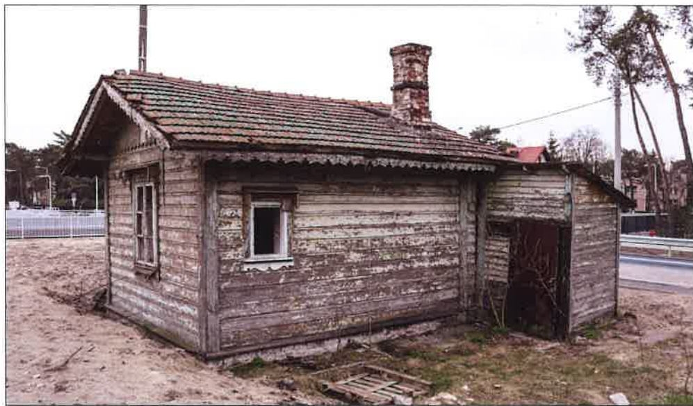
Widok budynku od strony północnej. (fot. Jakub Andrzejewski, 2021 r.)
