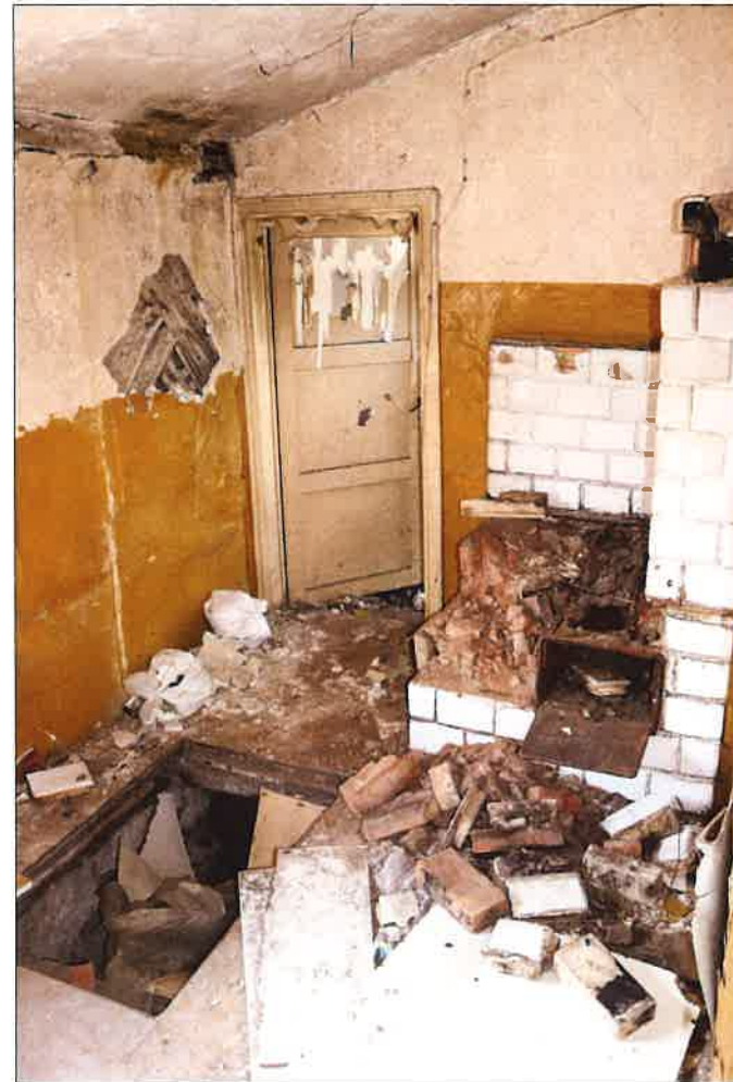
Widok pomieszczenia w przybudówce ze zniszczoną kuchnią węglową oraz niewielkim pomieszczeniem piwnicznym pod podłogą. Widok w kierunku zachodnim. (fot. Jakub Andrzejewski, 2021 r.)
