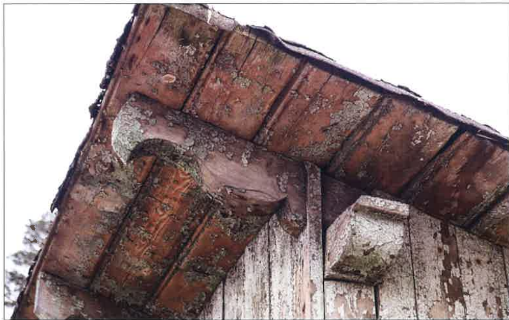
Zdobnie zakończone krokiew w szczycie połaci dachowej przy elewacji południowo-wschodniej. (fot. Jakub Andrzejewski, 2021 r.)
