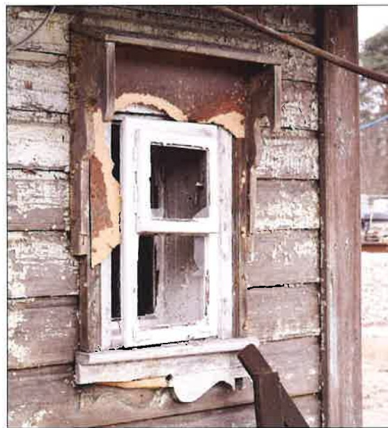
Okno w elewacji południowo-wschodniej. (fot. Jakub Andrzejewski, 2021 r.)
