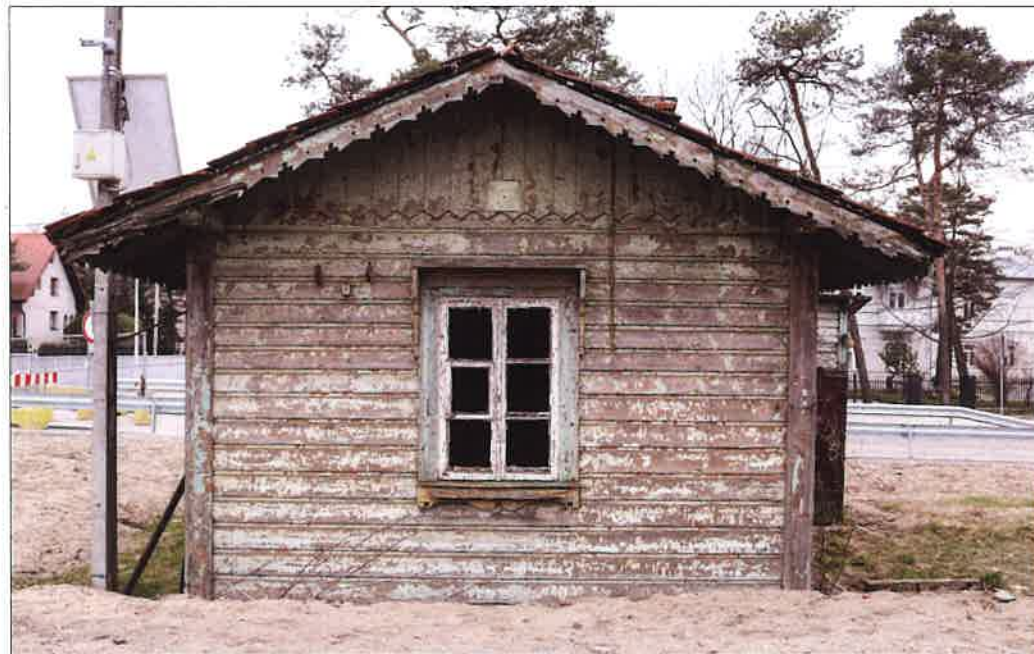
Widok elewacji północno-wschodniej. (fot. Jakub Andrzejewski, 2021 r.)
