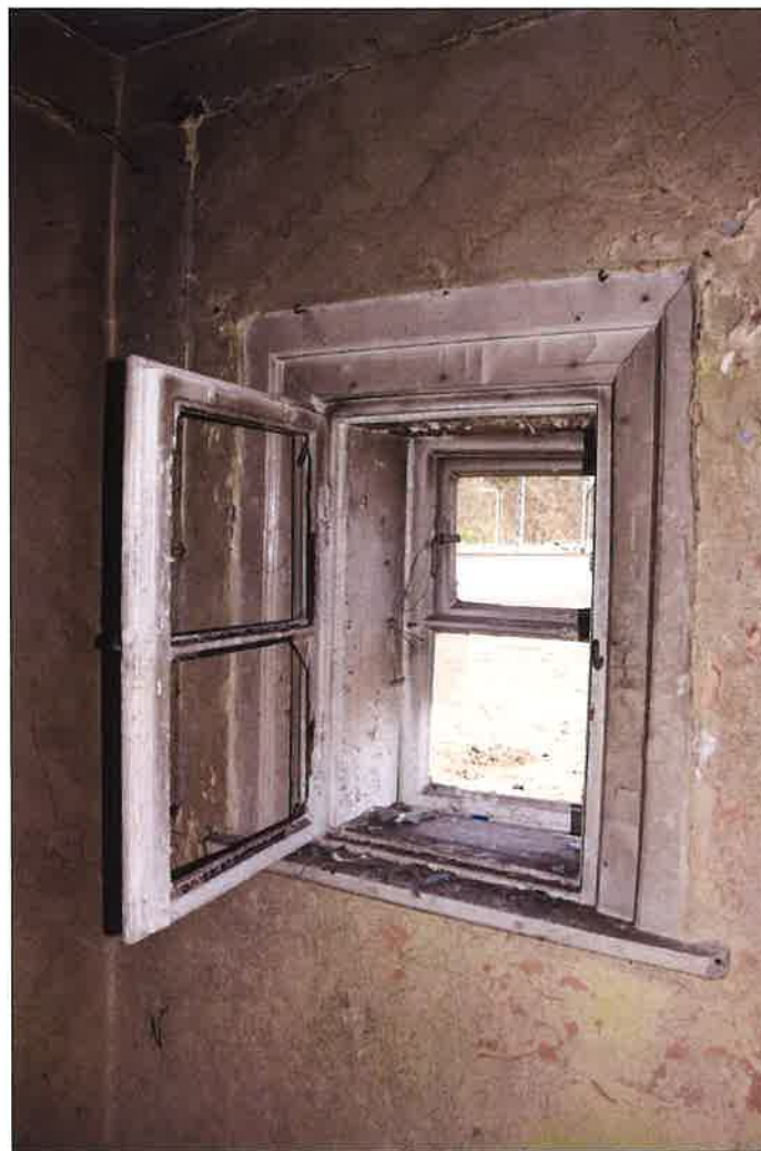
Zachowane kompletne okno w ścianie elewacji północno-wschodniej. (fot. Jakub Andrzejewski, 2021 r.)
