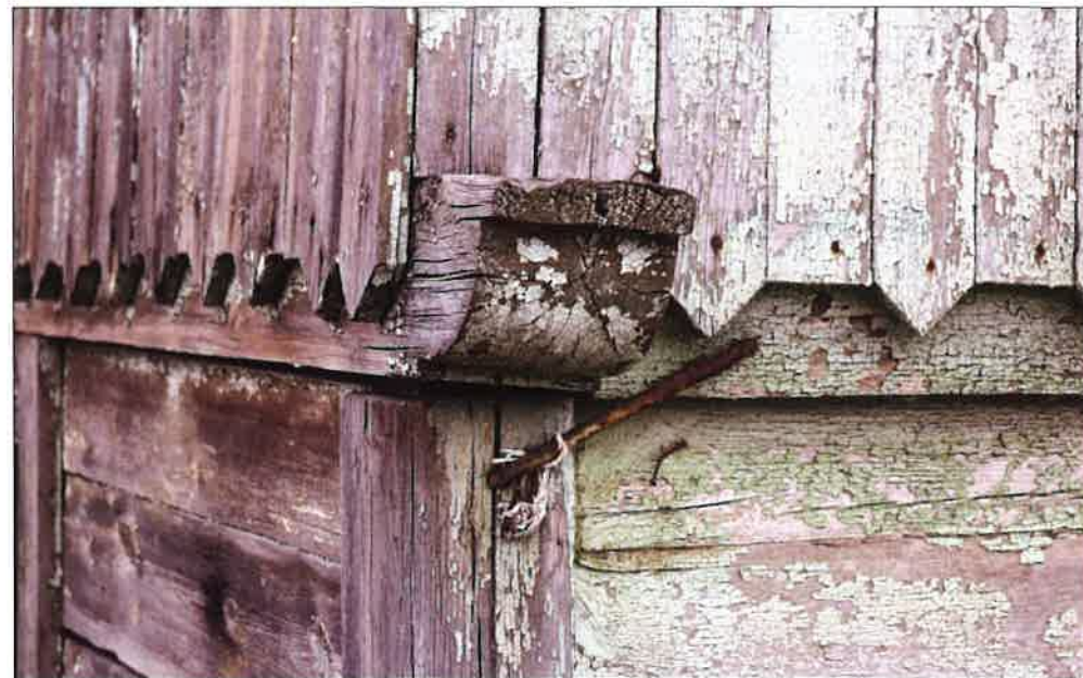
Naroże wschodnie budynku gospodarczego, widoczna belka (oczep) oraz narożny słup dodatkowo połączone klamrą. (fot. Jakub Andrzejewski, 2021 r.)
