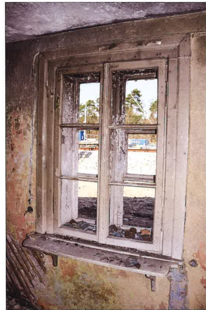
Zachowane kompletne okno, bez szklenia w ścianie elewacji północno-zachodniej. (fot. Jakub Andrzejewski, 2021 r.)
