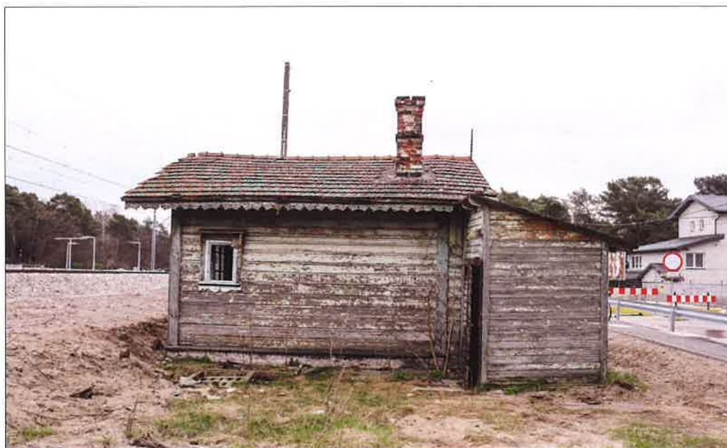
Widok elewacji północno-zachodniej. (fot. Jakub Andrzejewski, 2021 r.)
