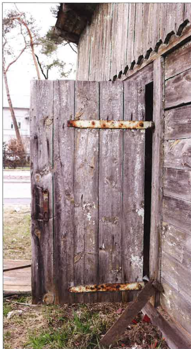
Zachowane skrzydło drzwiowe listwowo-deskowe z zastrzałem. (fot. Jakub Andrzejewski, 2021 r.)
