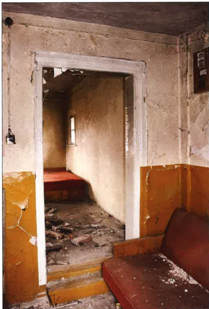
Przejście z pomieszczenia w przybudówce w stronę wschodnią; widoczna jest różnica poziomów pomiędzy pomieszczeniami. (fot. Jakub Andrzejewski, 2021 r.)
