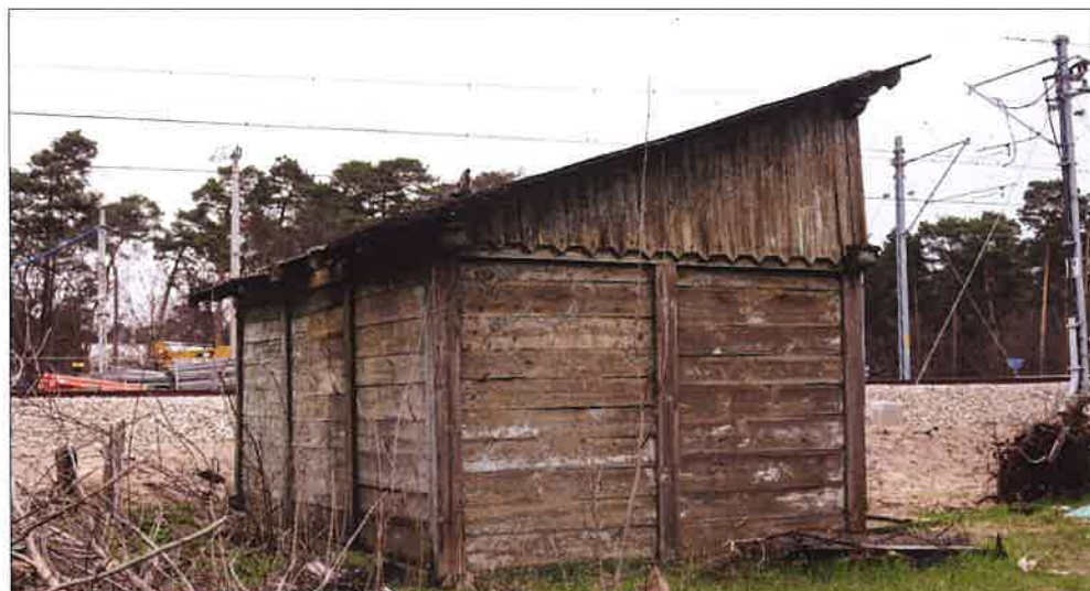
Widok budynku gospodarczego od strony zachodniej. (fot. Jakub Andrzejewski, 2021 r.)
