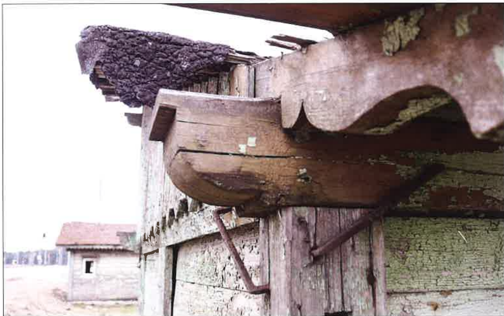
Belka (oczep) pełniąca także funkcję płatwi, połączona z narożnym słupem klamrami. Powyżej widoczna zdobnie zakończona krokiew. (fot. Jakub Andrzejewski, 2021 r.)
