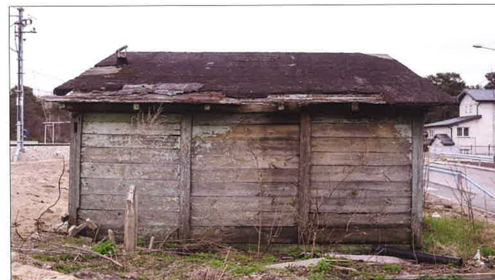
Widok elewacji północno-zachodniej. (fot. Jakub Andrzejewski, 2021 r.)
