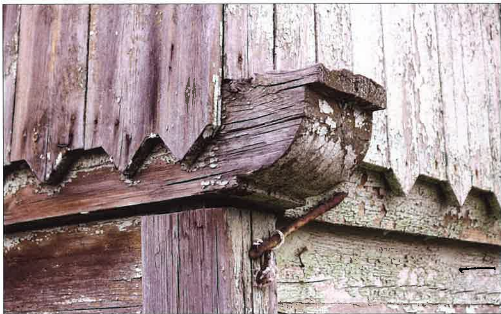
Naroże wschodnie budynku gospodarczego, widoczna belka (oczep) oraz opierzenie z desek układanych na przylgę. (fot. Jakub Andrzejewski, 2021 r.)
