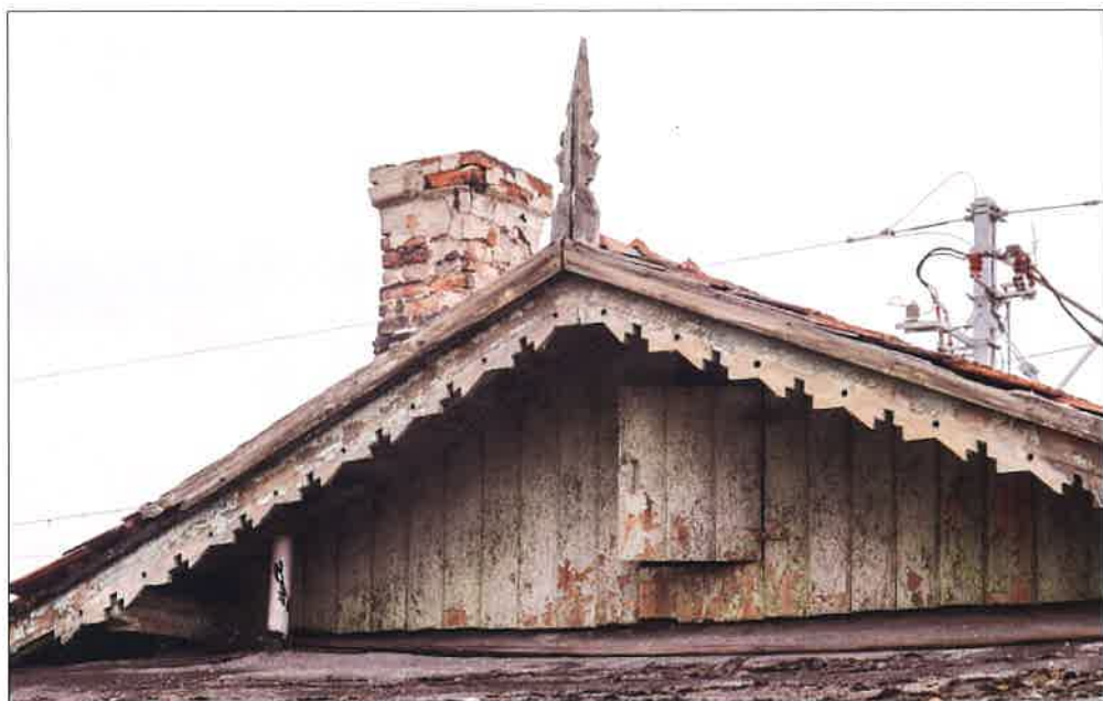
Komin, sterczyna oraz wejście na kondygnację poddasza w elewacji południowo-zachodniej. (fot. Jakub Andrzejewski, 2021 r.)
