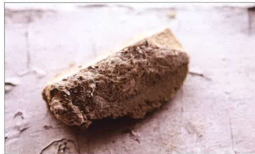
Fragment wypełnienia przestrzeni pomiędzy belkami drewnianymi konstrukcji wieńcowej. Wypełnienie składa się z sznura konopnego, gliny oraz wapna. (fot. Jakub Andrzejewski, 2021 r.)
