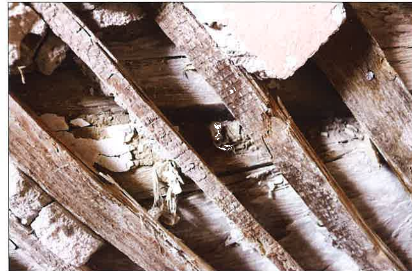
Listwy drewniane stanowiących podkonstrukcję dla powłoki tynkarskiej przybite do belek konstrukcji wieńcowej. (fot. Jakub Andrzejewski, 2021 r.)
