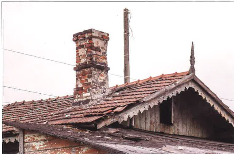
Najprawdopodobniej wtórnie przebudowany komin ceglany w północno-zachodniej połaci dachowej. (fot. Jakub Andrzejewski, 2021 r.)
