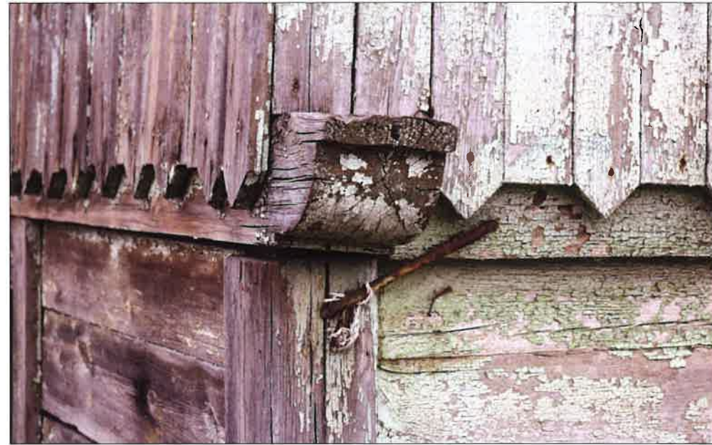
Naroże wschodnie budynku gospodarczego, widoczna belka (oczek) oraz narożny słup dodatkowo połączone klamrą. (fot. Jakub Andrzejewski, 2021 r.)
