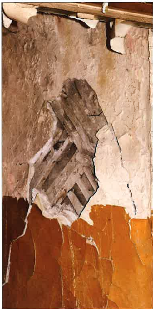
Widok odspojonej powłoki tynkarskiej oraz belek konstrukcji wieńcowej i listewek stanowiących podkonstrukcję dla powłoki tynkarskiej. (fot. Jakub Andrzejewski, 2021 r.)
