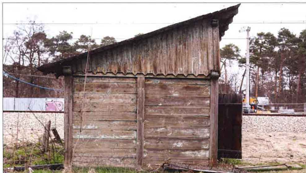
Widok elewacji południowo-zachodniej. (fot. Jakub Andrzejewski, 2021 r.)
