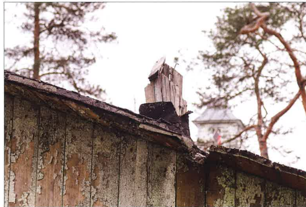
Fragment zachowanej wywiewki kanalizacyjnej w połaci dachowej. (fot. Jakub Andrzejewski, 2021 r.)
