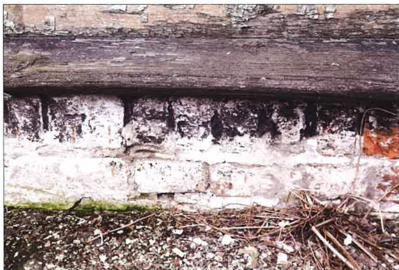
Widok muru ceglanego ściany fundamentowej i fragmentu cokołu w elewacji północno-zachodniej. (fot. Jakub Andrzejewski, 2021 r.)
