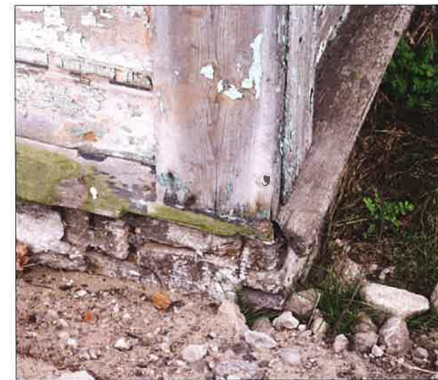
Mur ceglany cokołu w narożu północnym budynku na styku z drewnianym opierzeniem drewnianej ściany konstrukcyjnej. (fot. Jakub Andrzejewski, 2020 i 2021 r.)
