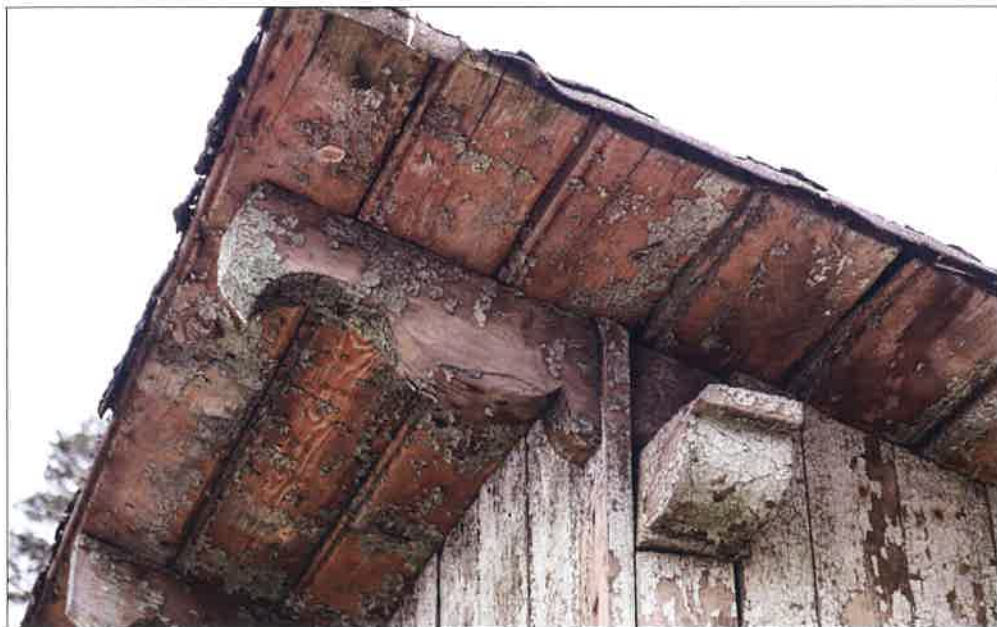
Zdobnie zakończone krokwie w szczycie połaci dachowej przy elewacji południowo-wschodniej. (fot. Jakub Andrzejewski, 2021 r.)
