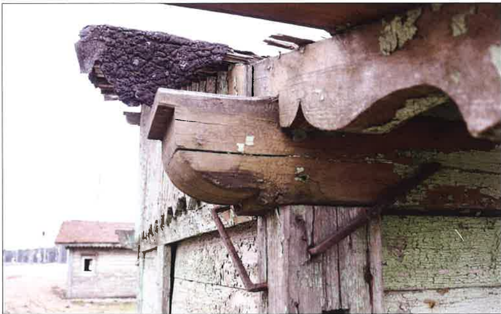
Belka (oczep) pełniąca także funkcję płatwi, połączona z narożnym słupem kłami. Powyżej widoczna zdobnie zakończona krokiew. (fot. Jakub Andrzejewski, 2021 r.)
