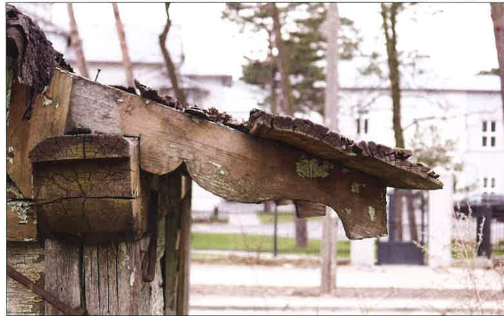
Zdobnie zakończone krokiew przy elewacji północno-zachodniej. (fot. Jakub Andrzejewski, 2021 r.)
