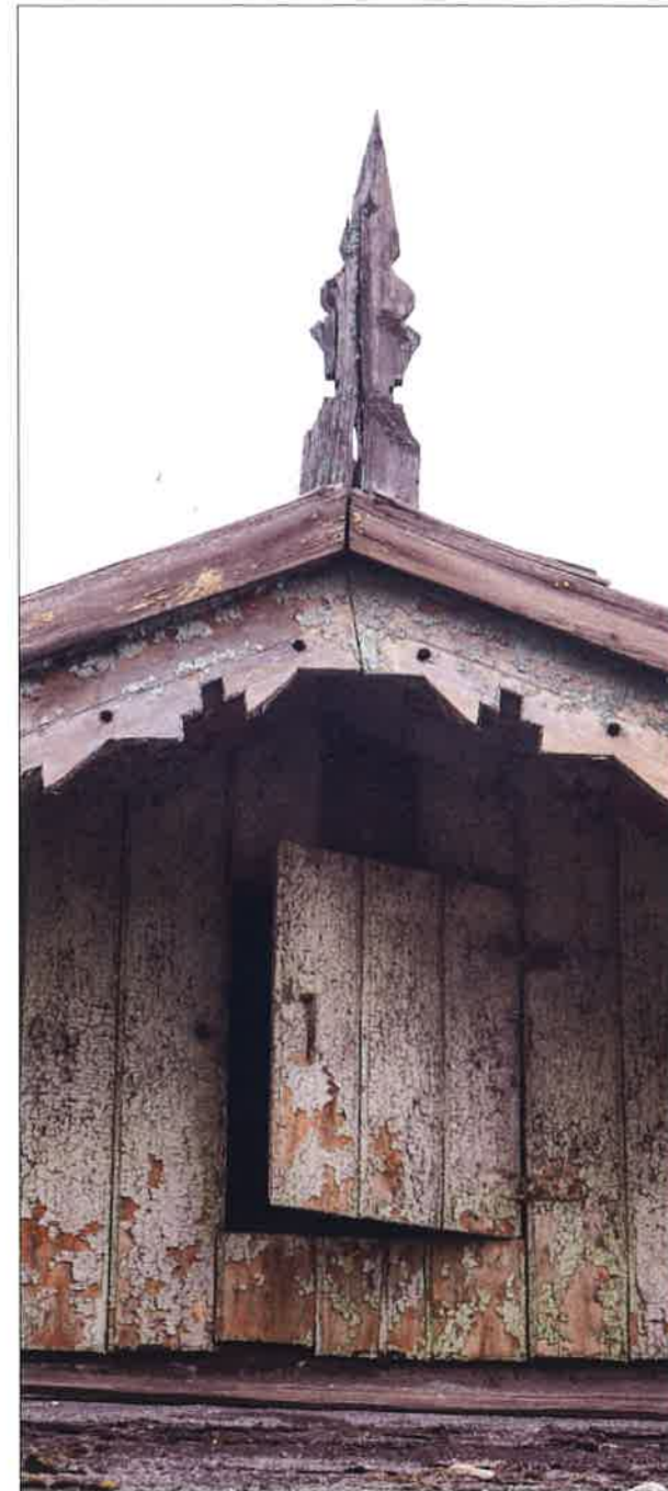
Sterczyna w kalenicy dachu i widoczne pod nią wejście na poddasze budynku. (fot. Jakub Andrzejewski, 2021 r.)
