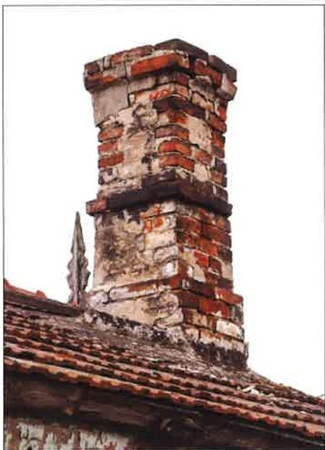
Najprawdopodobniej wtórnie przebudowany komin ceglany w północno-zachodniej połaci dachowej. (fot. Jakub Andrzejewski, 2021 r.)
