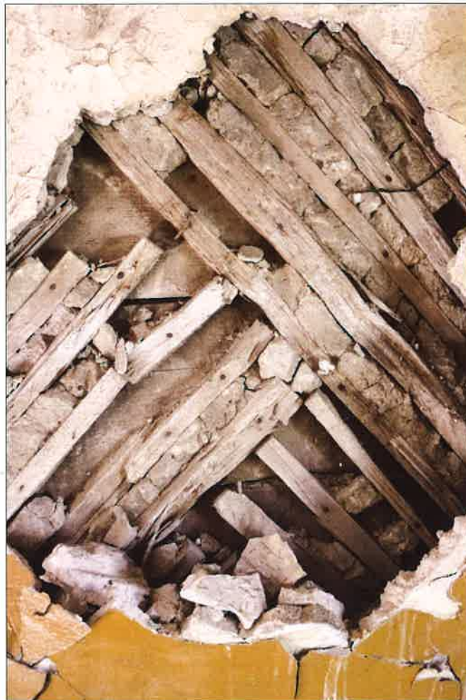
Widok odspojonej powłoki tynkarskiej oraz belek konstrukcji wieńcowej i listewek stanowiących podkonstrukcję dla powłoki tynkarskiej. (fot. Jakub Andrzejewski, 2021 r.)
