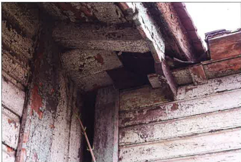
Naroże głównej części budynku z przybudówką, widok od strony północnej. (fot. Jakub Andrzejewski, 2021 r.)
