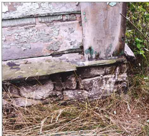
Mur ceglany cokołu w narożu północnym budynku na styku z drewnianym opierzeniem drewnianej ściany konstrukcyjnej. (fot. Jakub Andrzejewski, 2020 i 2021 r.)
