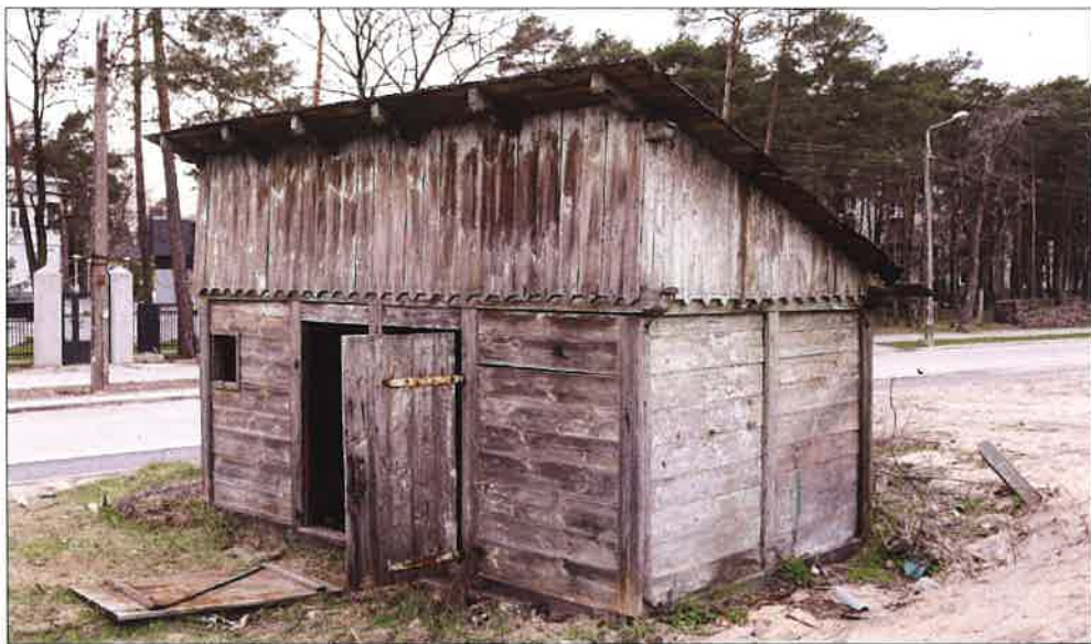
Widok budynku gospodarczego od strony wschodniej. (fot. Jakub Andrzejewski, 2021 r.)
