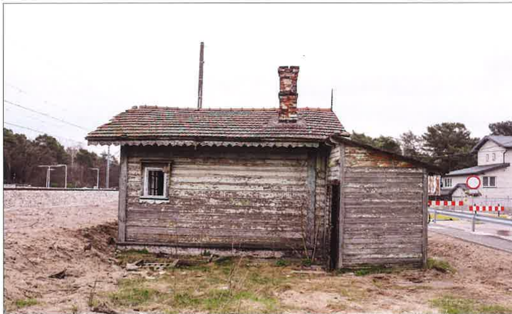
Widok elewacji północno-zachodniej. (fot. Jakub Andrzejewski, 2021 r.)
