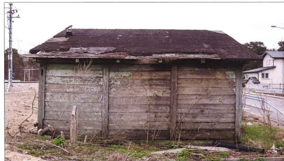
Widok elewacji północno-zachodniej. (fot. Jakub Andrzejewski, 2021 r.)
