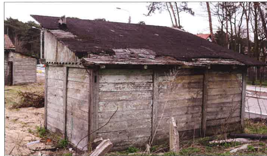
Widok budynku gospodarczego od strony północnej. (fot. Jakub Andrzejewski, 2021 r.)
