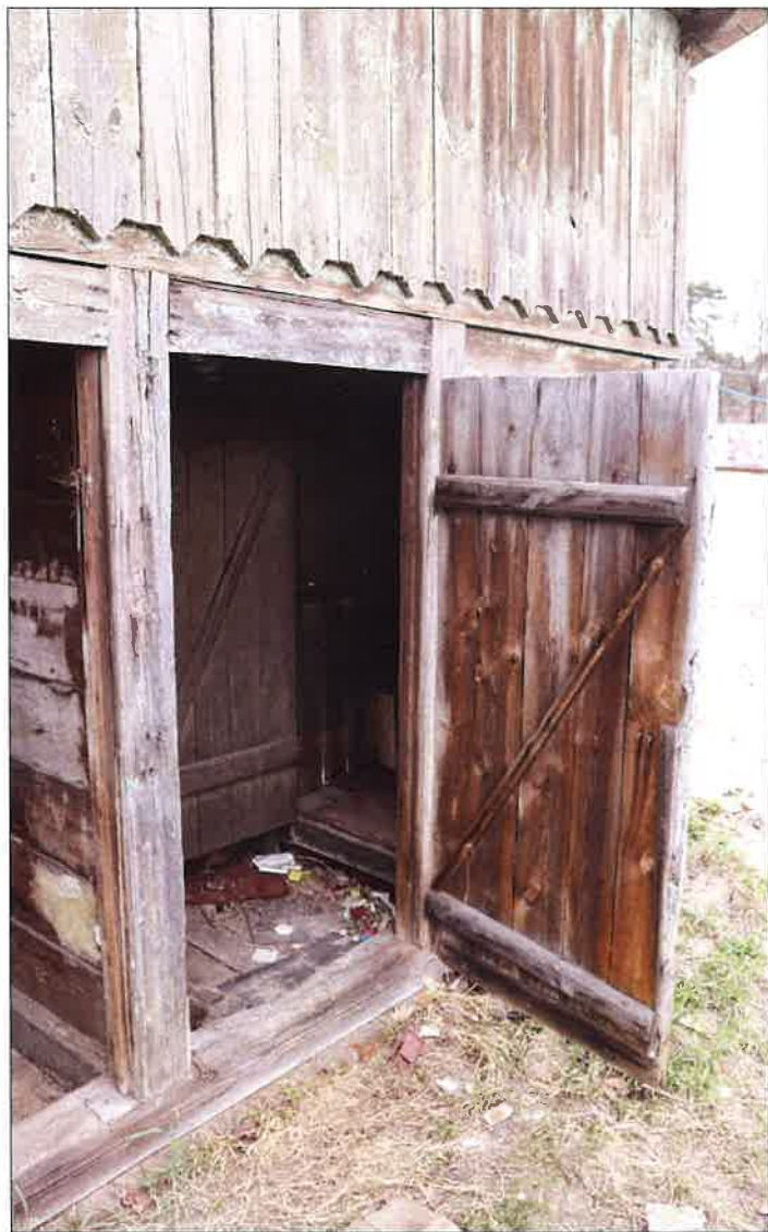
Zachowane skrzydło drzwiowe w elewacji południowo-wschodniej. Widok pomieszczenia po północnej stronie budynku. (fot. Jakub Andrzejewski, 2021 r.)
