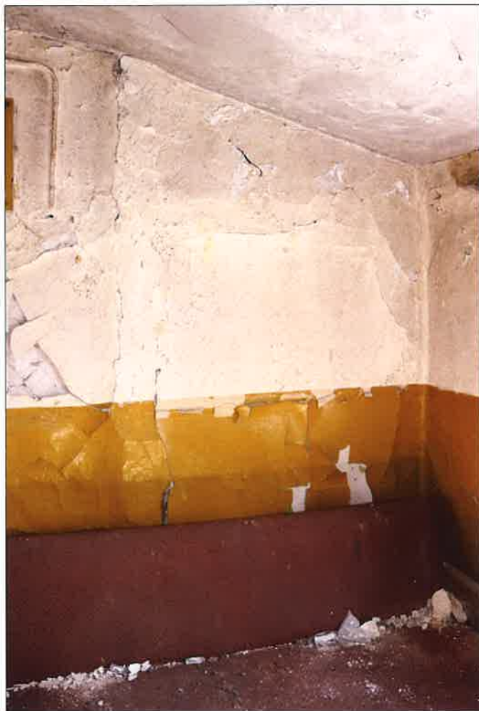
Ściana elewacji południowo-wschodniej widoczna od strony wnętrza. Widoczny zarys zamurowanego oryginalnego wejścia do budynku. (fot. Jakub Andrzejewski, 2021 r.)
