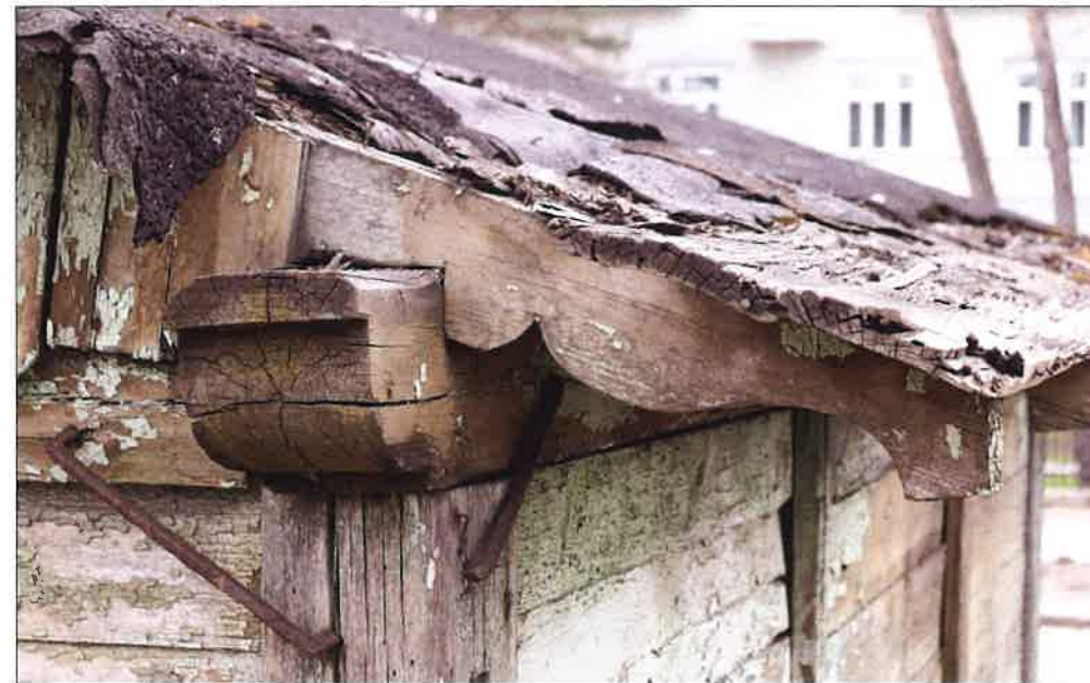
Belka (oczek) pełniąca także funkcję płatwi, połączona z narożnym słupem klamrami. Powyżej widoczna zdobnie zakończona krokiew. (fot. Jakub Andrzejewski, 2021 r.)
