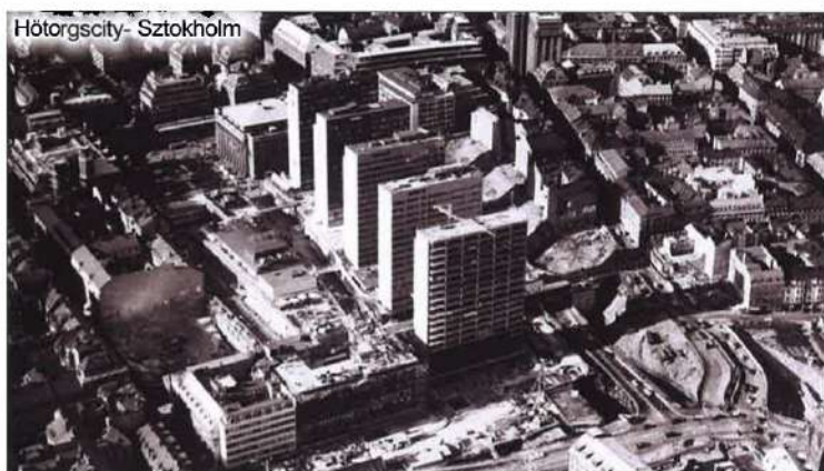
Budowa Hötorgscity w Sztokholmie w 1961 r. założenie które powstało w podobnym czasie co Ściana Wschodnia. (fot. Oscar Bladh/Stockholmskällan, www.fastighetsvarlden.se )
