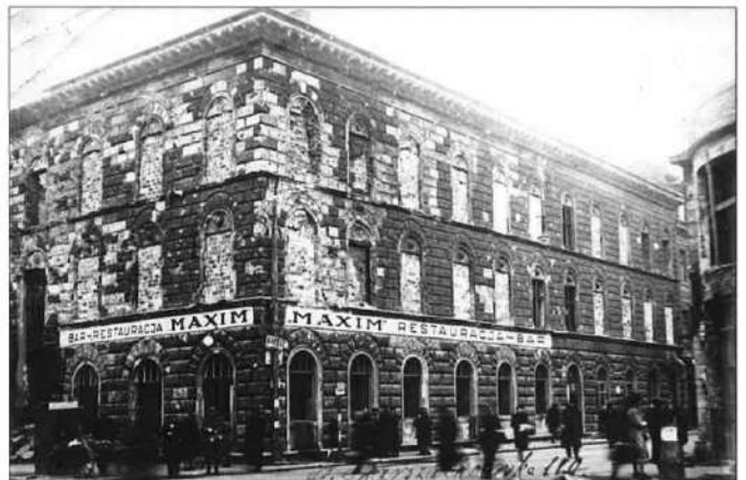
Budynek przy ul. Marszałkowskiej 110 przy skrzyżowaniu z ul. Chmielną, widok przed wyburzeniem, ok. 1946 r. (źródło: Wydział Archiwum, Biuro Organizacji Urzędu M. St Warszawy; sygn. P.12 t.2/541)
