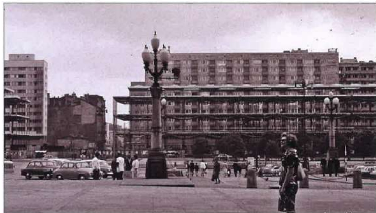
Widok placu budowy Domu Towarowego „Junior” i „Sawa” oraz pozostałych obiektów „Ściany Wschodniej” w 1966 r. (źródło: https://fotopolska.eu )
