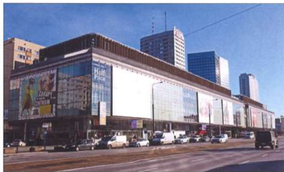
Widok budynku od strony zachodniej
