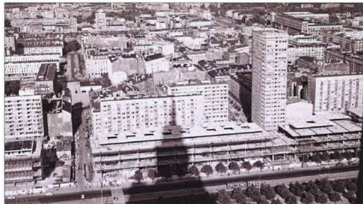
Widok budowy „Ściany Wschodniej”. (fot. Lech Zieliński, 1966 r., źródło: Narodowe Archiwum Cyfrowe, audiovis.nac.gov.pl , sygn. 3/53/0/8/539/3)
