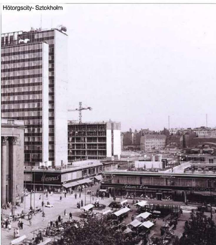
Budowa Hötorgscity w Sztokholmie w 1959 r. widoczne pasáže oraz niska zabudowa handlowa założenia. (fot. Ragnhild Haarstad/Stockholmskällan, www.fastighetsvarlden.se )
