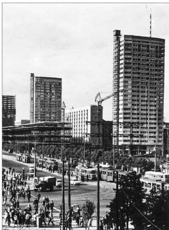
Teren budowy „Ściany Wschodniej” widoczny od strony skrzyżowania Alej Jerozolimskich z ul. Marszałkowską, 1966 r. (fot. Zbyszko Siemaszko, źródło: Narodowe Archiwum Cyfrowe, audiovis.nac.gov.pl; sygn. 3/51/0/12.4/533)
