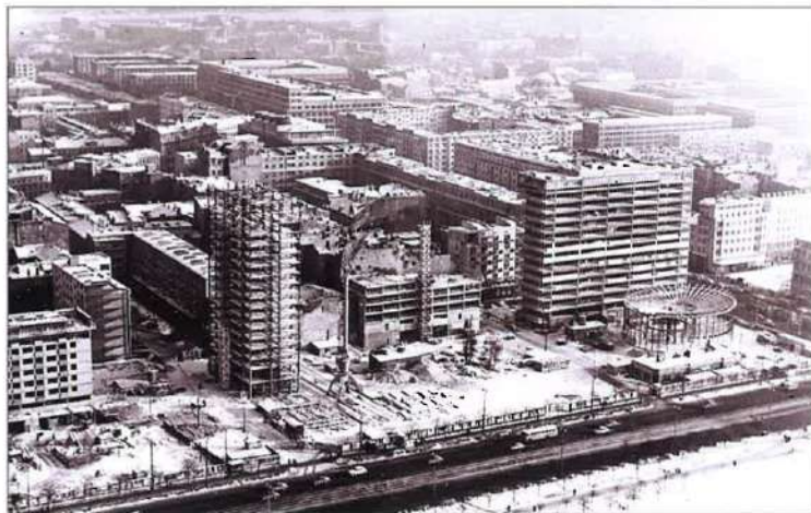
Plac budowy Domu Towarowego Wars i Sawa oraz pozostałych obiektów „Ściany Wschodniej” ok. 1966 r. (fot. Antoni Spiewak, zbiory Agnieszki Sternickiej, https://www.tubyfotustalo.pl )
