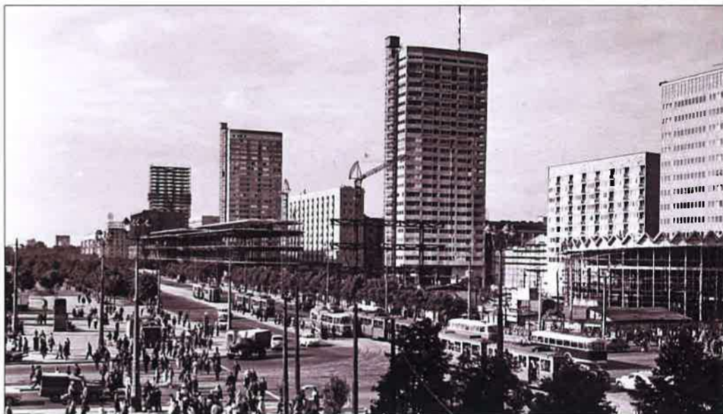
Teren budowy „Ściany Wschodniej” widoczny od strony skrzyżowania Alej Jerozolimskich z ul. Marszałkowską, 1966 r. (fot. Zbyszko Siemaszko, źródło: Narodowe Archiwum Cyfrowe, audiovis.nac.gov.pl ; sygn. 3/51/0/12.4/533)
