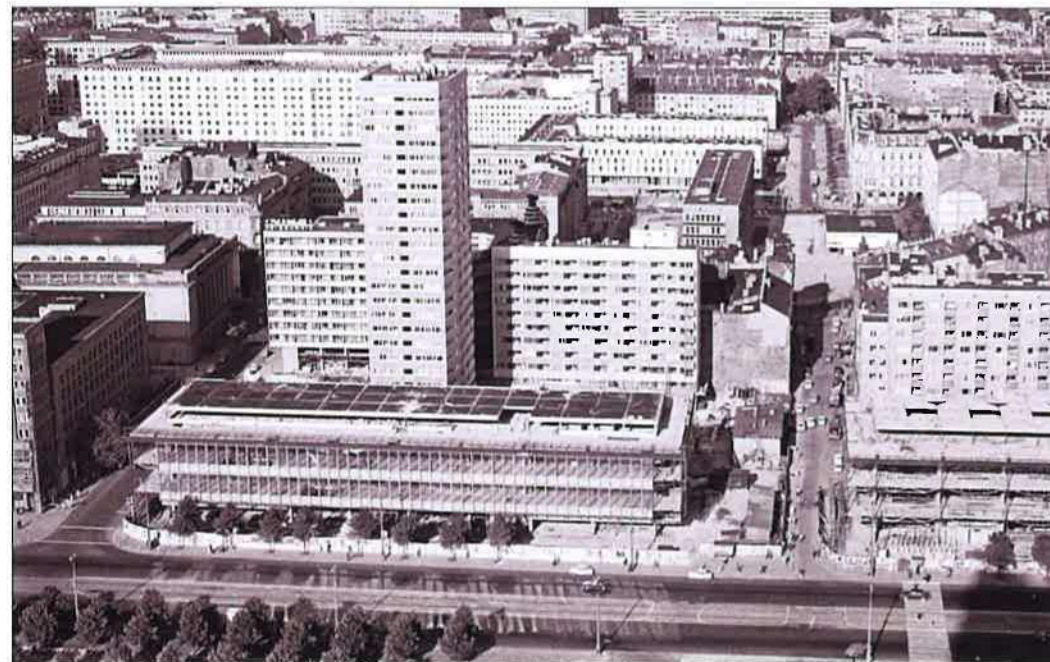
Widok budowy „Ściany Wschodniej”. (fot. Lech Zielaskowski, 1966 r., źródło: Narodowe Archiwum Cyfrowe, audiovis.nac.gov.pl , sygn. 3/53/0/8/539/4)
