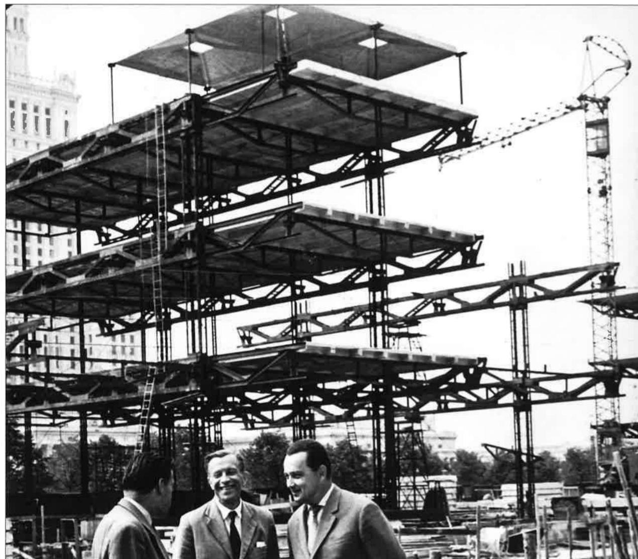
Zbigniew Karpiński na budowie ściany wschodniej 1965 r. W głębi widoczna stalowa konstrukcja budynku Domów Towarowych „Sawa” i „Wars” - o identycznej konstrukcji z konstrukcją Młodzieżowego Domu Towarowego „Junior”. (źródło: http://www.wojciechkarpinski.com/zbigniewkarpinski )
