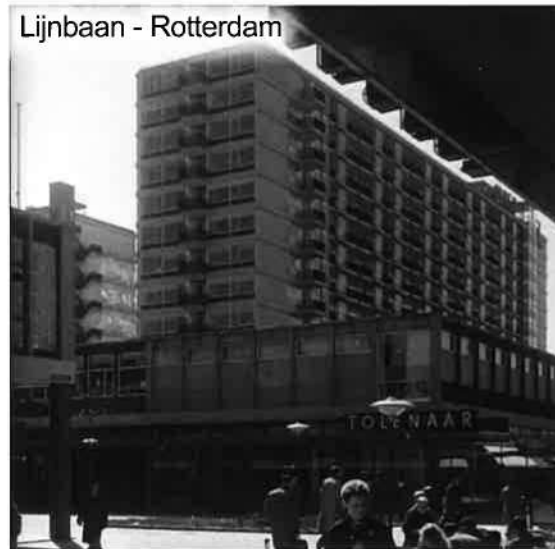
Widok pasażu i budynku mieszkalnego Lijnbaan w Rotterdamie, 1958 r. (Archiwum miejskie w Rotterdamie, 4273-L-3312, źródło: https://wederopbouwrotterdam.nl )
