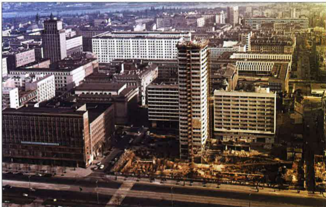
Widok placu budowy domu Młodzieżowego Domu Towarowego oraz pozostałych obiektów „Ściany Wschodniej” w 1965 r. (fot. Nagy Gyula, https://fortepan.hu )
