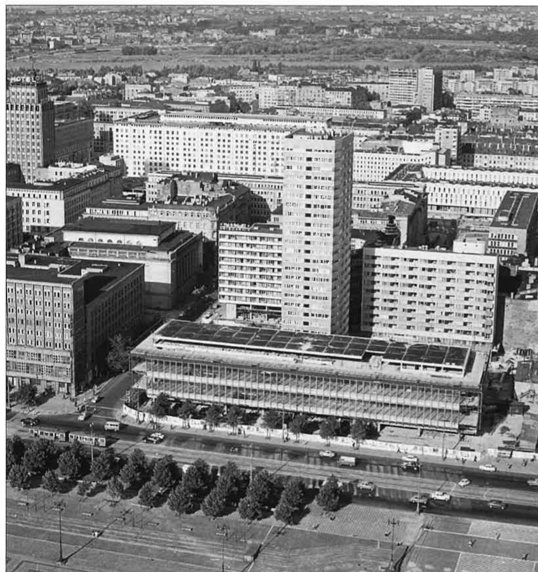
Widok budowy „Ściany Wschodniej”. (fot. Lech Zielaskowski, 1966 r., źródło: Narodowe Archiwum Cyfrowe, audiovis.nac.gov.pl , sygn. 3/53/0/8/539/2)
