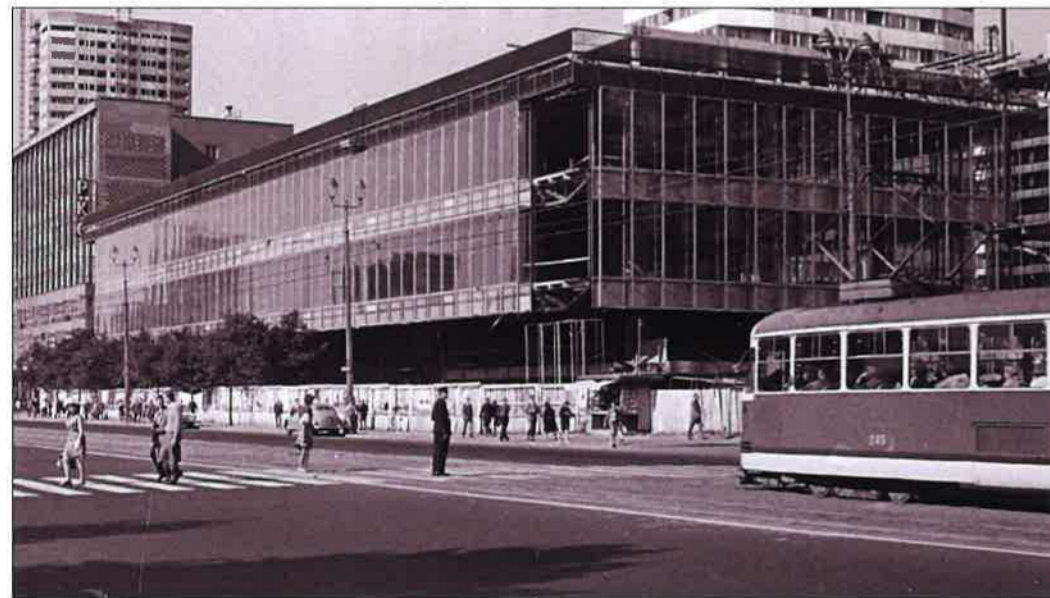
Budowa Młodzieżowego Domu Towarowego widoczna od strony skrzyżowania ul. Marszałkowskiej i Żłotej, 1966 r. (fot. Grażyna Rutowska, źródło: Narodowe Archiwum Cyfrowe, audiovis.nac.gov.pl ;) )
