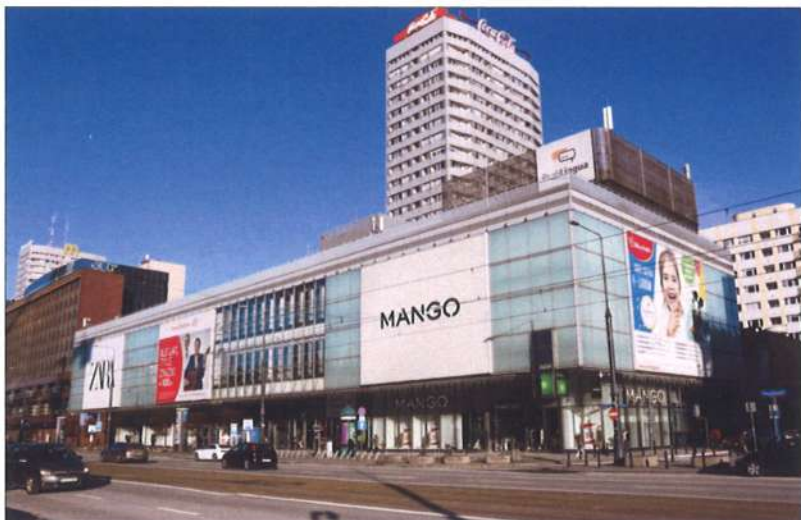
Widok budynku od strony południowej
