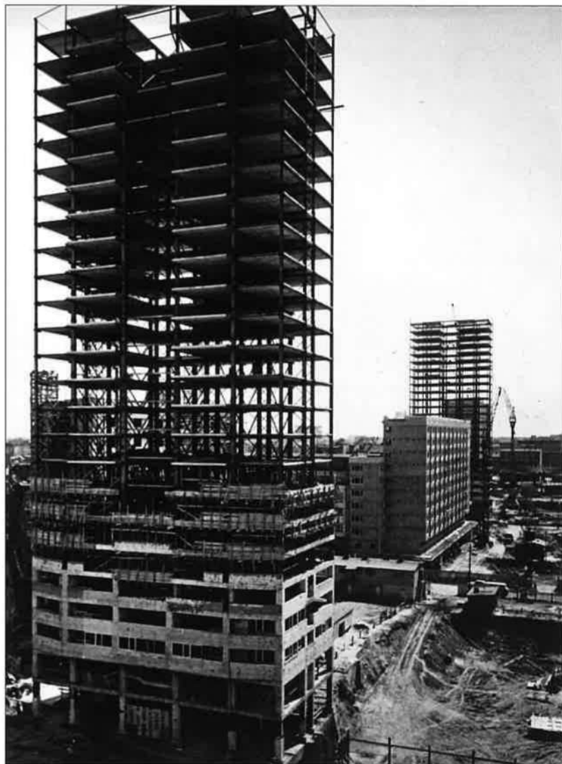
Budowa „Ściany Wschodniej” w 1965 r. Widoczna budowa budynków mieszkalnych oraz po prawej wykop pod fundamenty MDT „Junior”. (źródło: http://www.wojciechkarpinski.com/zbigniewkarpinski )
