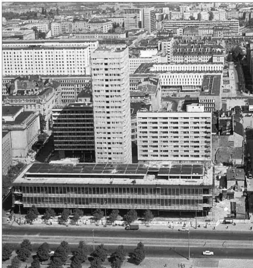
Widok budowy „Ściany Wschodniej”. (fot. Lech Zielaskowski, 1966 r., źródło: Narodowe Archiwum Cyfrowe, audiovis.nac.gov.pl , sygn. 3/53/0/8/538/6)
