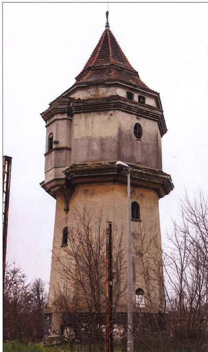
Widok ogólny wieży od strony północno-wschodniej, od strony linii kolejowej. (fot. Jakub Andrzejewski, 2021 r.)
