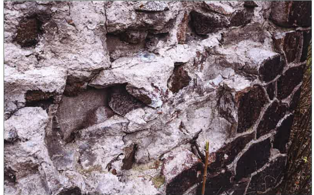
Fragment odsłoniętej żelbetowej ściany spod warstwy kamiennej ściany licującej cokół. (fot. Jakub Andrzejewski, 2021 r.)
