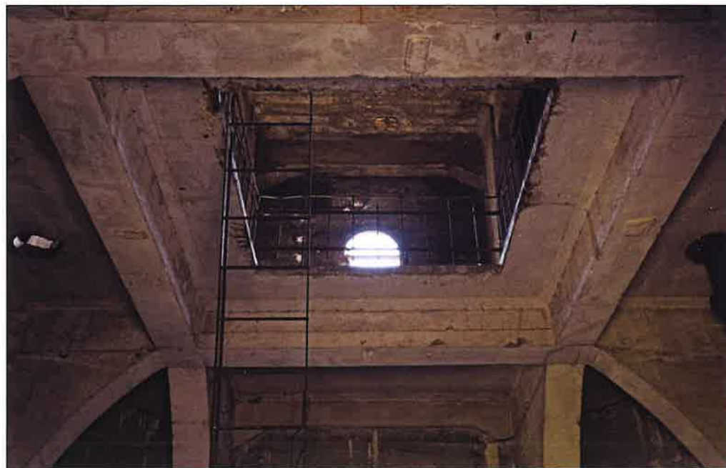
Wnętrze budynku, widok żelbetowych rygli w stropie powyżej kondygnacji parteru, w głębi widoczne wyższe piętro ze stropem żelbetowym. (fot. MWKZ, 2021 r.)
