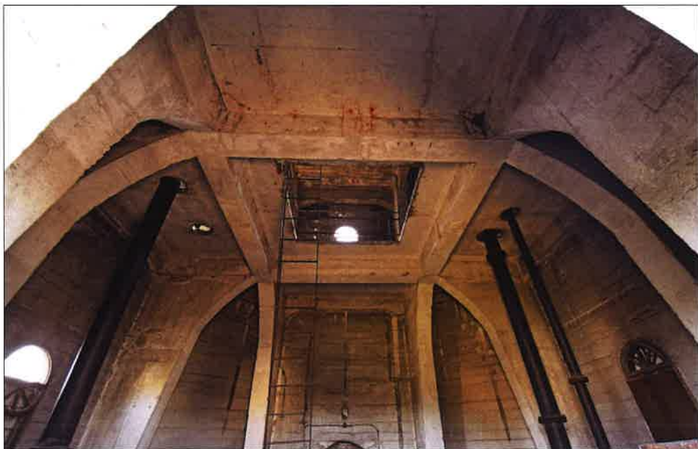
Wnętrze budynku z widoczną żelbetową konstrukcją wieży oraz z częściowo zachowanymi instalacjami wodnymi; ściany wewnętrzne nie zostały wykończone (fot. MWKZ, 2021 r.)
