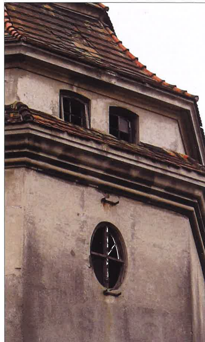
Widok głowicy wieży z oknami, fragment elewacji północnej. (fot. Jakub Andrzejewski, 2021 r.)
