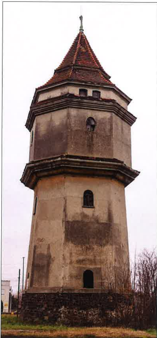
Widok wieży od strony zachodniej
