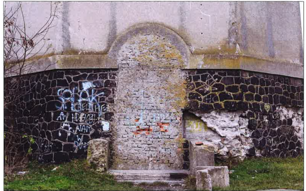
Wtórnie zamurowane wejście w przyziemiu wieży po stronie wschodniej, część cokołowa licowana kamieniem, zakończona gzymsem prostym. (fot. Jakub Andrzejewski, 2021 r.)
