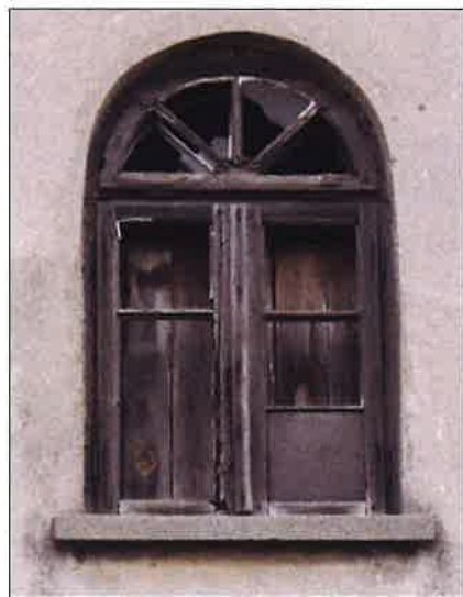
Widok części zachowanych oryginalnych drewnianych okien ościeżnicowych (polskich), z uchylnym łukowym naświetlem. (fot. Jakub Andrzejewski, 2021 r.)
