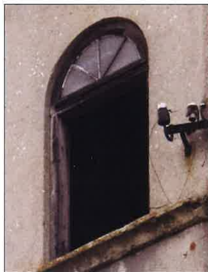
Widok części zachowanych oryginalnych drewnianych okien ościeżnicowych (polskich), z uchylnym łukowym naświetlem. (fot. Jakub Andrzejewski, 2021 r.)
