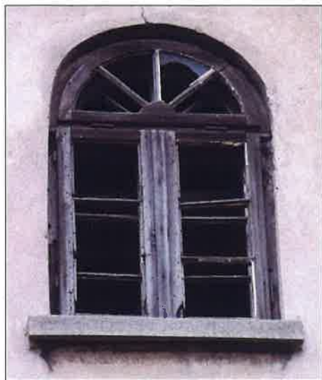
Widok części zachowanych oryginalnych drewnianych okien ościeżnicowych (polskich), z uchylnym łukowym naświetlem. (fot. Jakub Andrzejewski, 2021 r.)
