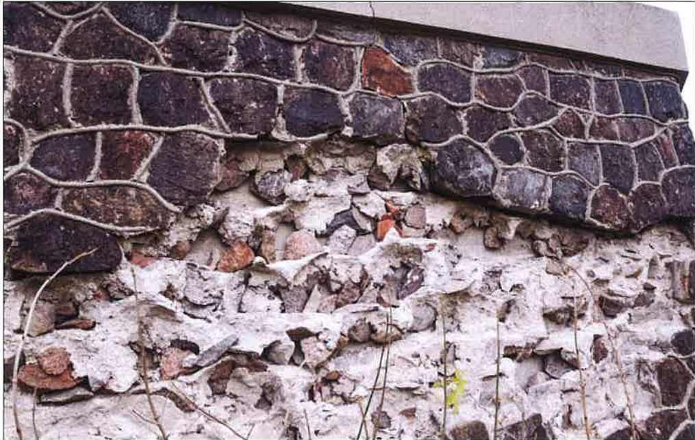
Odsłonięta struktura ściany cokołowej z zaprawą cementową łączącą łamane i łupane fragmenty kamienia z żelbetową ścianą konstrukcyjną. (fot. Jakub Andrzejewski, 2021 r.)
