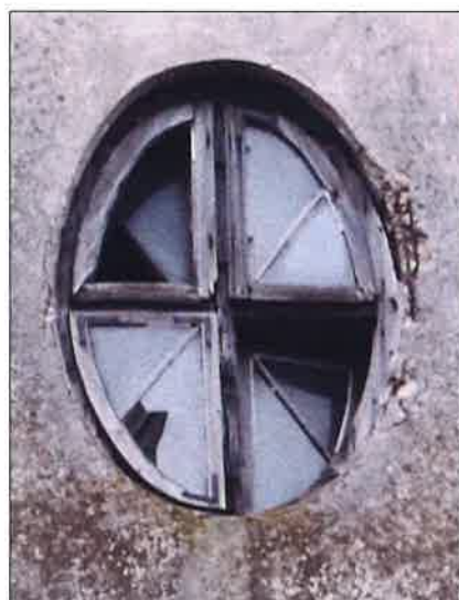
Okna w kształcie owalnych oculusów w kondygnacji głowicy wieży, okna 4-dzielne, ościeżnicowe. (fot. Jakub Andrzejewski, 2021 r.)
