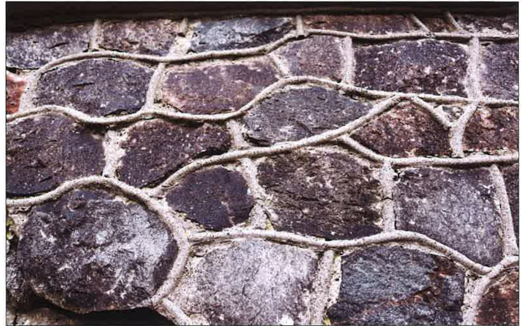
Widok cokołu wykonanego z łupanego kamienia najprawdopodobniej andezytu pienińskiego, spoinowanego zaprawą cementową. (fot. Jakub Andrzejewski, 2021 r.)
