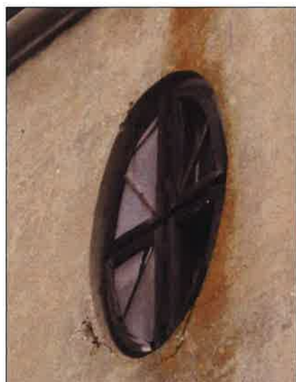
Okna w kształcie owalnych oculusów w kondygnacji głowicy wieży, okna 4-dzielne, ościeżnicowe. (fot. Jakub Andrzejewski, 2021 r.)
