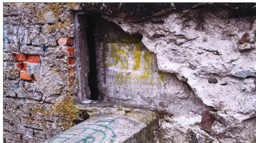
Widok odsłoniętej żelbetowej ściany konstrukcyjnej przy wtórnie zamurowanym wejściu do budynku. (fot. Jakub Andrzejewski, 2021 r.)
