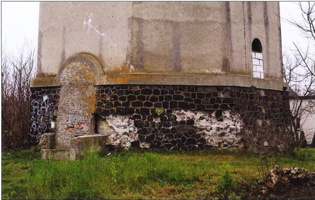
Przyziemie wieży, część cokołowa licowana kamieniem łupanym na zaprawie cementowej, widok od strony północno-wschodniej. (fot. Jakub Andrzejewski, 2021 r.)
