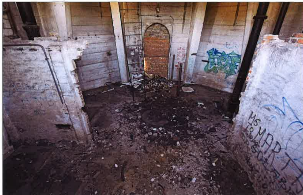
Wnętrze budynku z widocznymi częściowo wyburzonymi ścianami działowymi i fundamentami po zdemontowanych instalacjach. (fot. MWKZ, 2021 r.)
