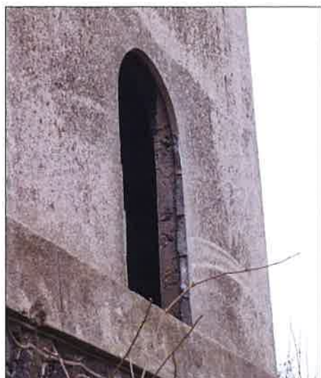
Zdemontowana stolarka okienna w elewacji zachodniej. (fot. Jakub Andrzejewski, 2021 r.)
