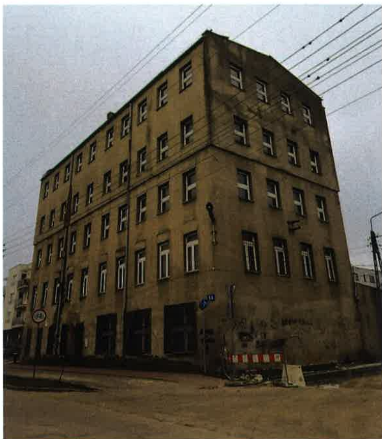
Widok ogólny fabryki.
