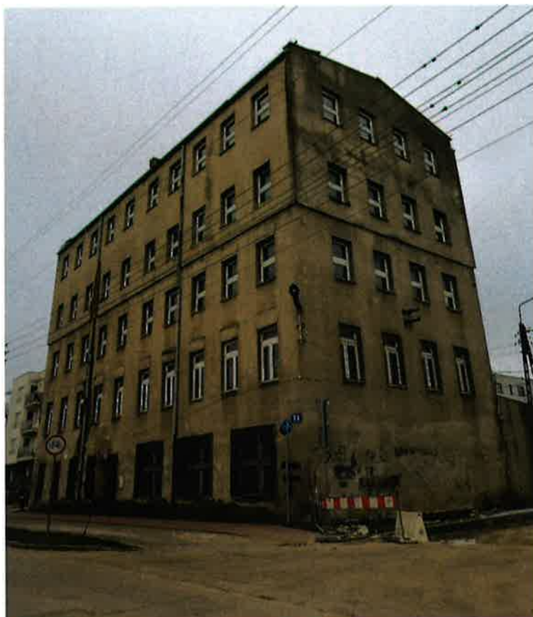
Widok ogólny fabryki.
